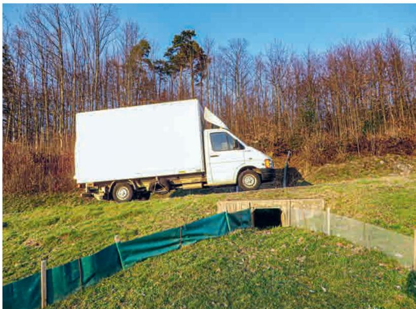
Mobile Amphibienzäune führen zu einer Kleintierunterführung, die ein gefahrloses Queren der Fahrbahn ohne helfende Hände ermöglicht. Der Geflechtzaun rechts ist für Molche überwindbar und wird nicht mehr verwendet.
