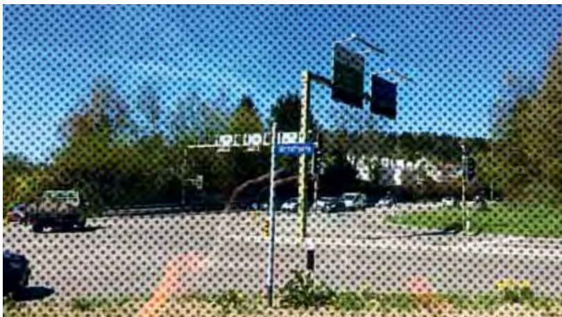
Ein mit der Vogelwarte Sempach abgestimmtes Punkteraster auf dem Glas verhindert, dass die Glaselemente zur Vogelfalle werden. Quelle: TBA
