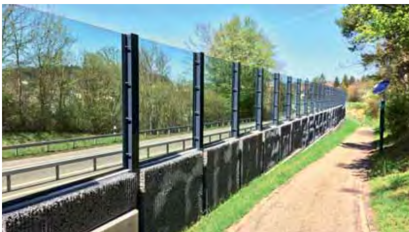
Das Besondere der neu entwickelten Steinkorbelemente: Sie sind dank eines integrierten Lavabeton-Elementkerns schalldicht, aber auch stabil genug, darauf Glaselemente zu montieren. Quelle: TBA
