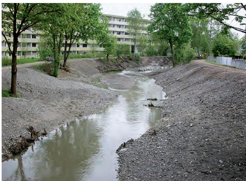
Der Chriesbach in Dübendorf vor (oben) und nach der Revitalisierung im Mai 2013 (unten). Die durchgehende Uferverbauung aus Blockwurf wurde entfernt, die Uferböschung stellenweise abgeflacht und dem Bach eine natürlichere Linienführung gegeben. Zudem wurde der Mündungsbereich in die Glatt naturnah gestaltet. So können sich auch wieder Organismen mit höheren Ansprüchen an den Lebensraum im Chriesbach ansiedeln.
