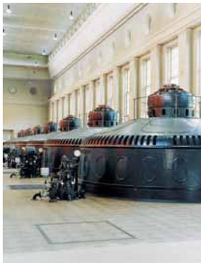
Die sieben Turbinen des Kraftwerks Eglisau Glattfelden nutzen das Gefälle des Rheins und treiben Generatoren an.
