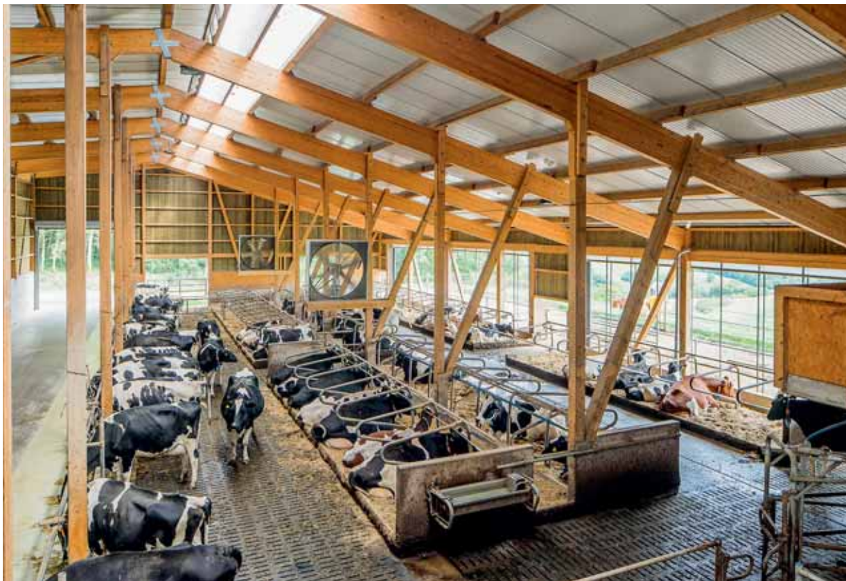
Schon ab 24 Grad Celsius geraten Rinder in Hitzestress und fühlen sich unwohl, Kühe produzieren weniger Milch. Stalllüftung und Ventilatoren sind dann wichtige Massnahmen. Quelle: agrotech.ch
