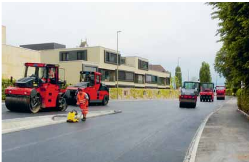
Lärmarme Beläge als Massnahme an der Quelle sind effizient, da sie den Lärm am Ort der Entstehung reduzieren. Quelle: TBA
