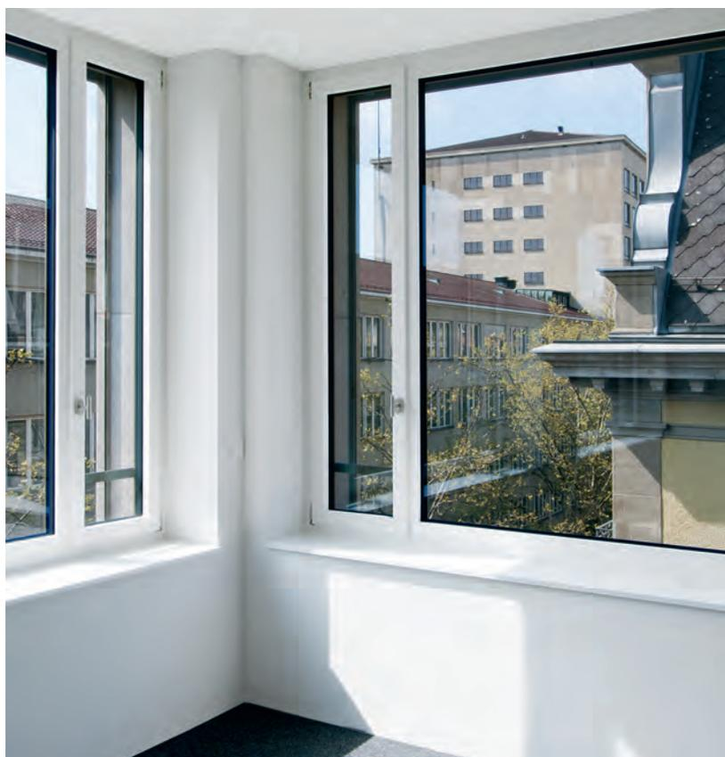
Optimal ist die Kombination von mechanischer Lüftung mit Fenstern, die man öffnen kann.
