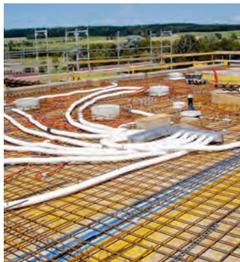
Eingelegte Lüftungsrohre in der Geschosdecke.
