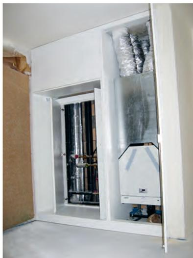
Das Lüftungsgerät im Schrank beim Eingang erleichtert den Zugang zur Wartung.
