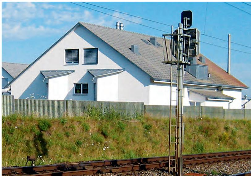
Lüftung mit offenem, lärmabgewandtem Erker-Fenster, Lösung der LSV seit 1987. Der Lärmschutz bei Bahnlärm beträgt gegenüber der lärmexponierten Fassade -7 bis -10 dB.
