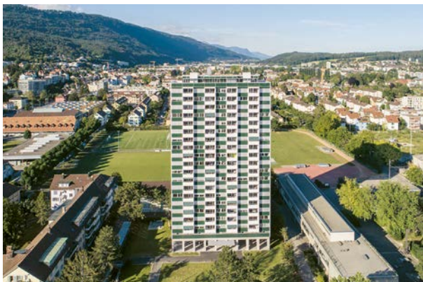
Die schlechte Energieeffizienz von Tour La Champagne in Biel mit seiner dünnen, vorgehängten Aluminium-Glas-Fassade konnte mit wenigen Eingriffen verbessert werden.
