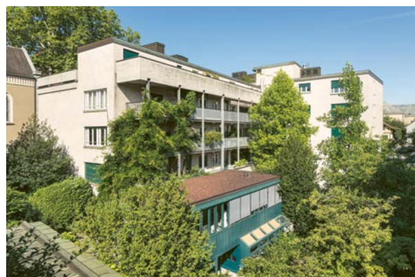
Der kleine ökologische Fussabdruck der Siedlung Wettingerwies geht auf die einfache Konstruktion und die durchdachte Haustechnik zurück.
