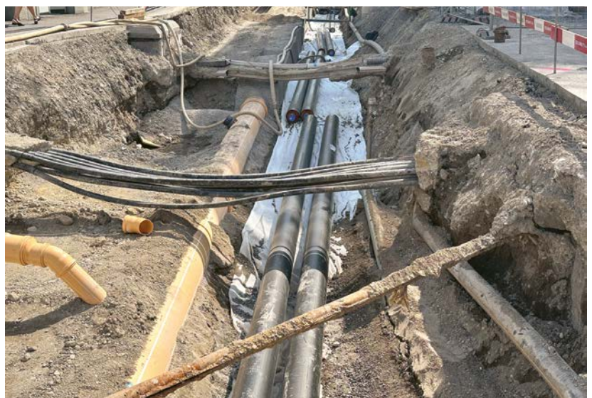
Geöffneter Boden. Durch den Leitungskataster können Unternehmen Bauprojekte besser koordinieren. Quelle: ARE
