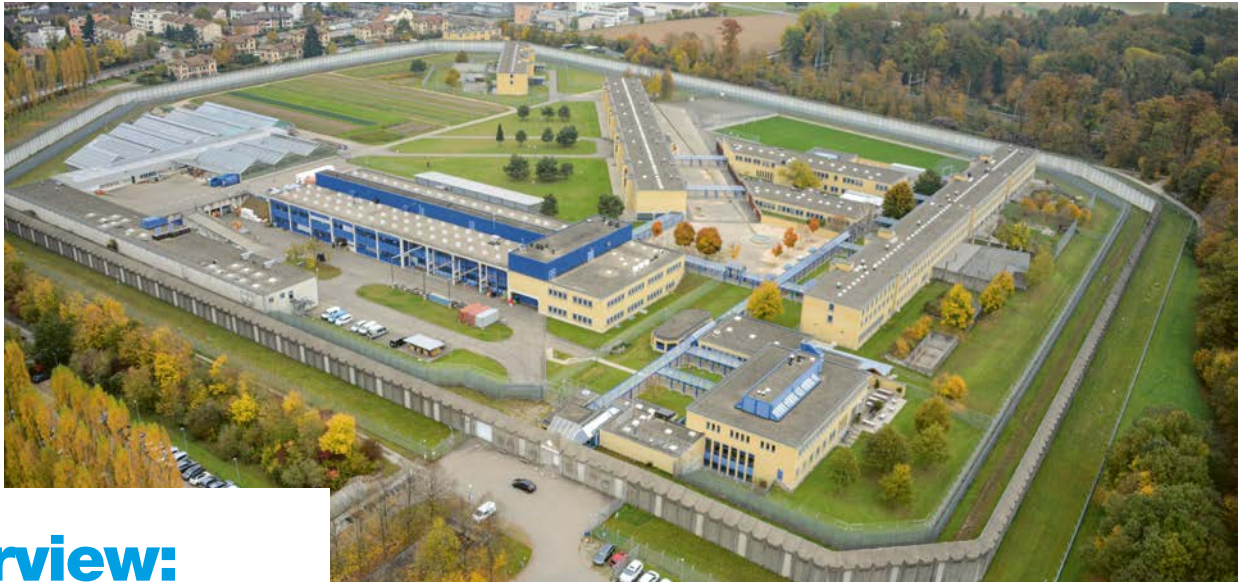
Die Justizvollzugsanstalt Pöschwies (JVA) ist das grösste Gefängnis der Schweiz. Quelle: Justizvollzug und Wiedereingliederung
