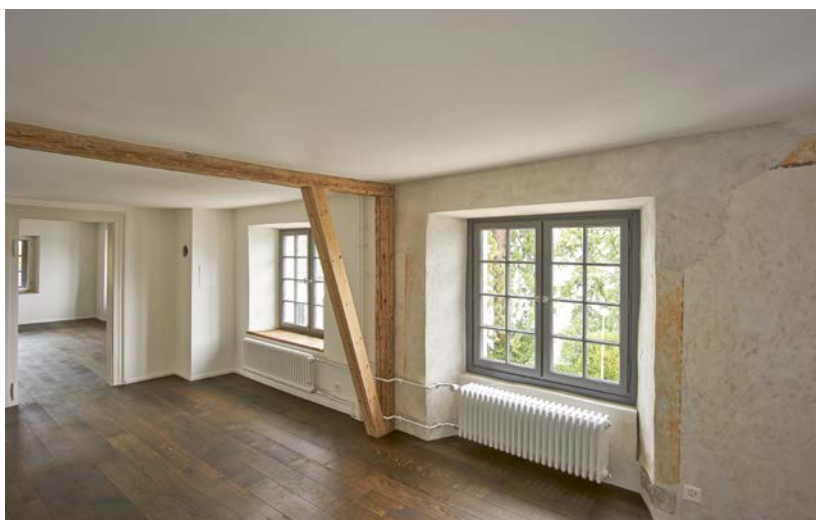
Im «Haus zur Lilie» wurden während der Umbauarbeiten im zweiten Obergeschoss die Zwischenwand entfernt, der Boden ersetzt, der Wand- und Deckenverputz repariert, die freigelegte Deckenmalerei wieder überstrichen, die Farbfassung an der Südwestwand restauriert und die Fenster ersetzt. Quelle: Roland Böhmer, Archäologie und Denkmalpflege Kanton Zürich
