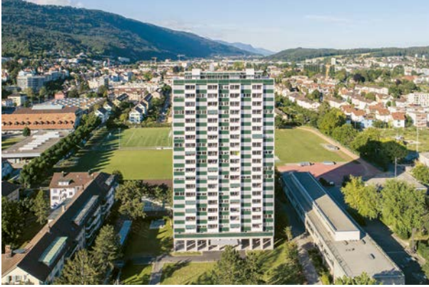
Die schlechte Energieeffizienz von Tour La Champagne in Biel mit seiner dünnen, vorgehängten Aluminium-Glas-Fassade konnte mit wenigen Eingriffen verbessert werden.
