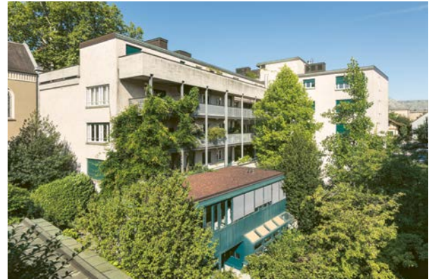
Der kleine ökologische Fussabdruck der Siedlung Wettingerwies geht auf die einfache Konstruktion und die durchdachte Haustechnik zurück.
