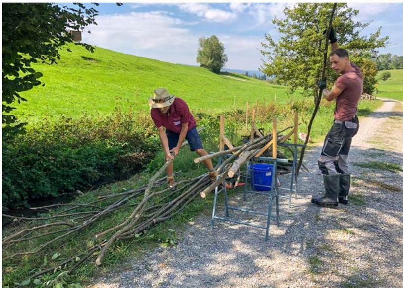
Aus Rutenbündeln eine Faschine zu konstruieren, ist Handarbeit und will gelernt sein.
