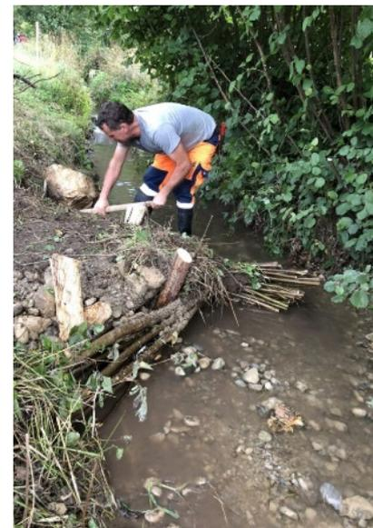
Eine Dreiecksbuhne, geformt aus zwei Faschinen, lenkt hier die Strömung.
