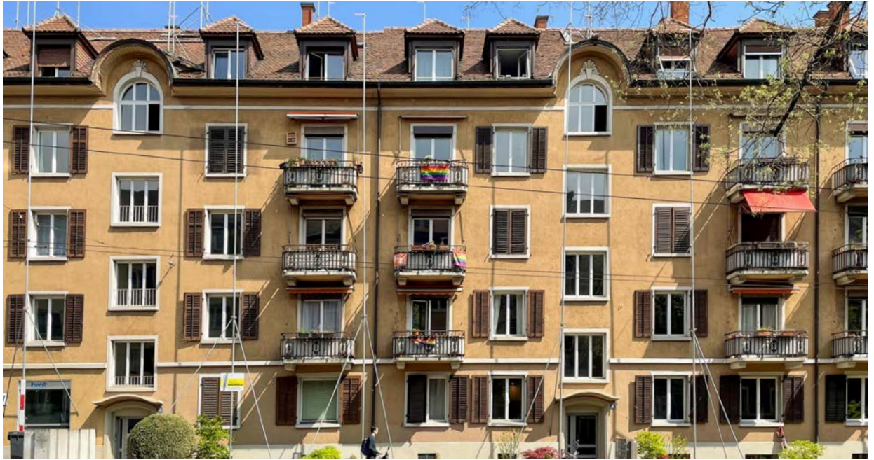
Kornhausstrasse in Zürich. Seit längerem zeigen die Visiere an, dass hier etwas geplant ist. Noch sind einige Fragen hinsichtlich Lärmoptimierung offen, und das Projekt ist vorerst sistiert. Quelle: FALS
