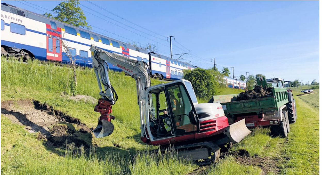
In Bonstetten kam bei der Erstellung von Kleinstrukturen auch der Bagger zum Einsatz. Quelle: Werner Schwehr
