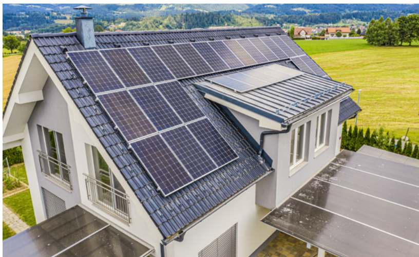
Immer mehr Fotovoltaikanlagen tragen zur regenerativen Stromversorgung bei. Quelle: @wirestock, Freepik.com
