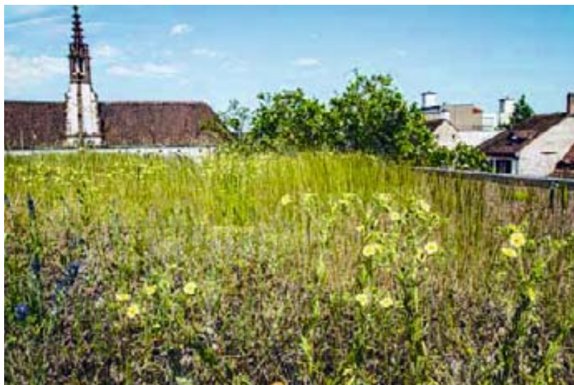
Basel gilt heute weltweit als die Stadt mit der höchsten Dachbegrünungsquote mit rund acht Quadratmeter pro Einwohner. Im Bild: das im Jahr 2003 sanierte begrünte Dach des Universitätsspitals.
