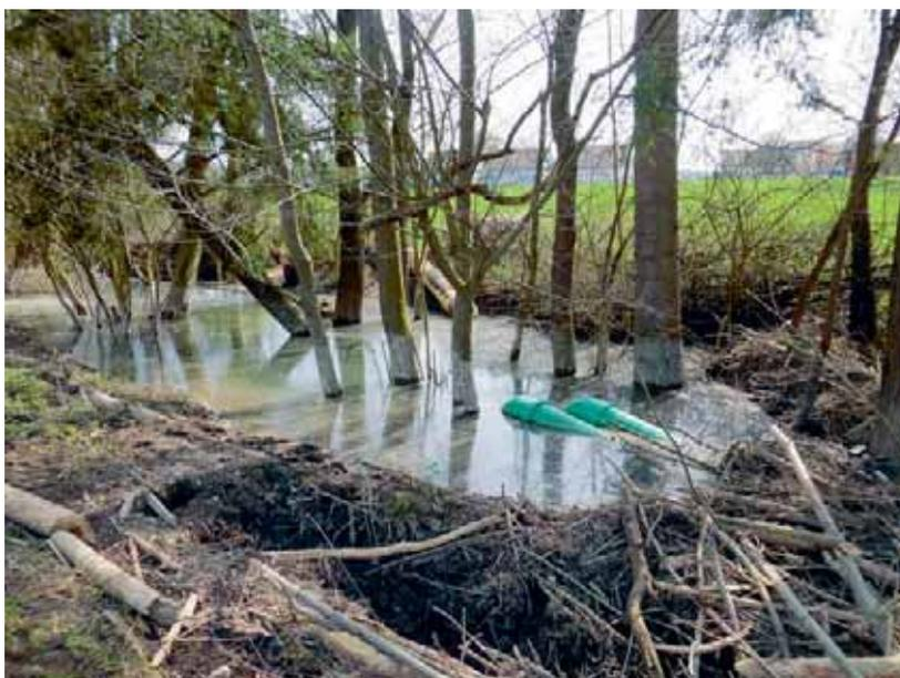
Technische Massnahmen, beispielsweise der Einbau von Entlastungsrohren in einen Biberdamm, können Schäden verhindern, sind aber bewilligungspflichtig.
