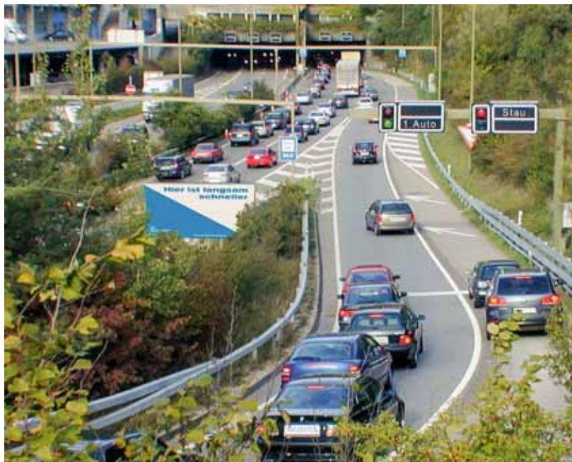
Der Lärm von Hochleistungsstrassen wirkt über grössere Distanzen, was im GIS-Browser berücksichtigt wird und in Berechnungen miteinbezogen werden muss. Quelle: Baudirektion
