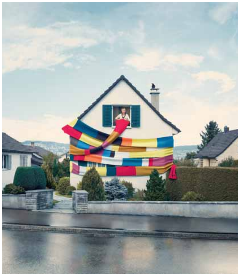
Aussenwände werden bei Modernisierungen noch zu selten besser gedämmt. Erhöhte Beitragssätze des Kantons für 2017 sollen dies ändern. Quelle: EKZ
