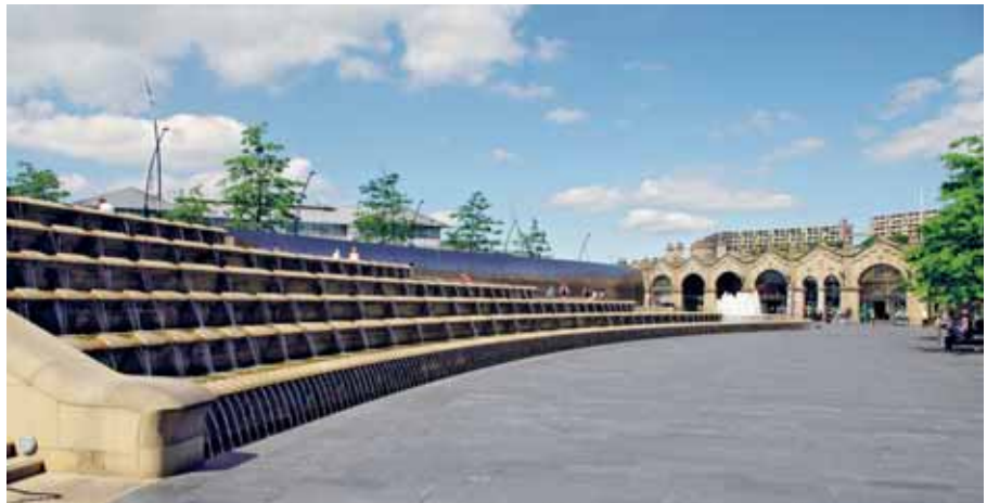
Wasseranlagen am Bahnhof Sheffield bilden im Verkehrslärm alternative Hörhorizonte.
