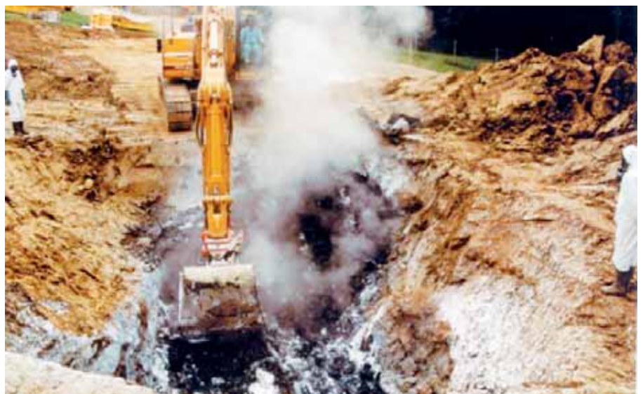
Sanierung der Säureharzdeponie Tössegg in Wildberg.
