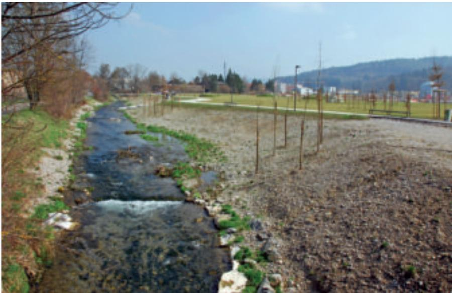
**Revitalisierte Eulach im Bereich Eulachpark, Neuhegi: Auf einer Strecke von rund 500 Metern hat die Stadt die zuvor befestigte Flusssohle entfernen lassen, die steilen Uferböschungen teilweise abgeflacht und mit standortgerechten Gehölzen, Hochstauden und einer artenreichen Wiesensaatmischung bepflanzt.**
