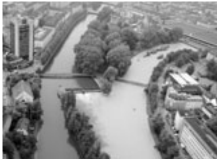
Mit dem Platzspitzwehr (links) wurde der Limmatabfluss gedrosselt, um zuerst das Sihlhochwasser (rechts) durchs Limmattal abfliessen zu lassen. Quelle: Kapo
