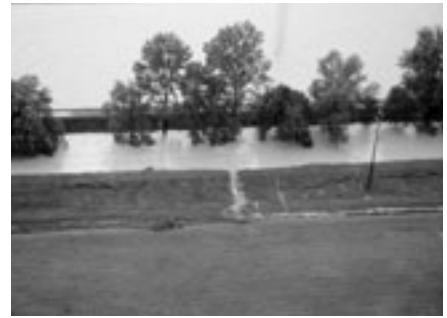
Die Dämme am Linthkanal waren im August 2005 destabilisiert, brachen aber zum Glück nicht durch.
