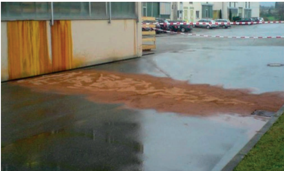
Chromsäurefreisetzung bei Dauerregen
