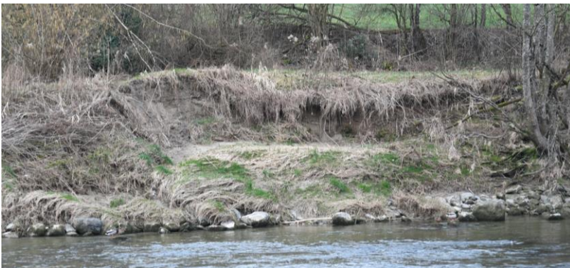
Abb. 10: Unterhalb der Ossinger Eisenbahnbrücke (Chlini Au) wurde die verfallene Steilwand wieder instand gesetzt. Das abgetragene Erdmaterial wurde rechts auf der Böschungsoberkante abgelagert. oben=vorher, unten = nachher
