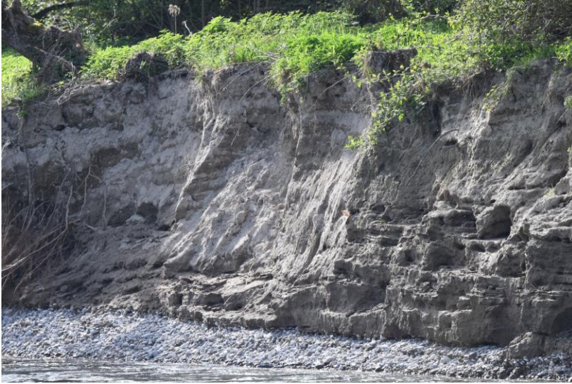
Abb. 71: Die Steilufer in der Tüfenau sind teilweise sehr brüchig und instabil. (06.04.2024)
