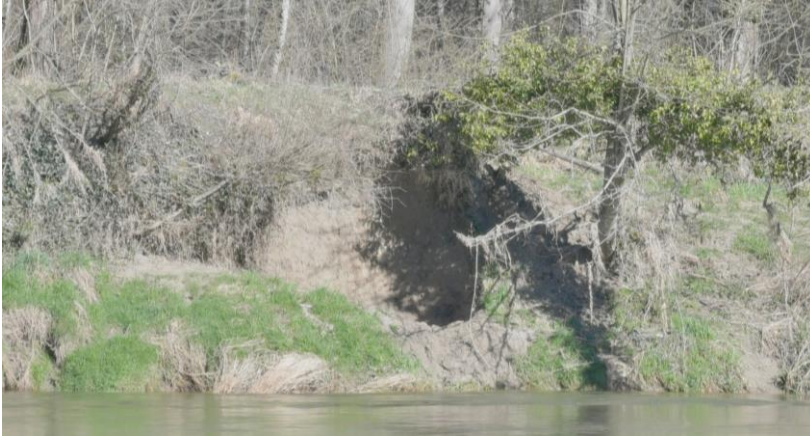
Abb. 5: Die Steilwand in der Forenhau wurde wieder instand gestellt.
