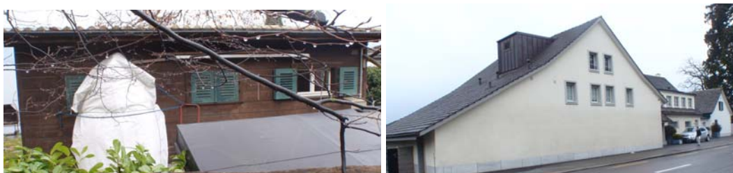
Bild 10: Kat. Nr. 1758, Holzhaus (links) und Ferienhaus (rechts).
