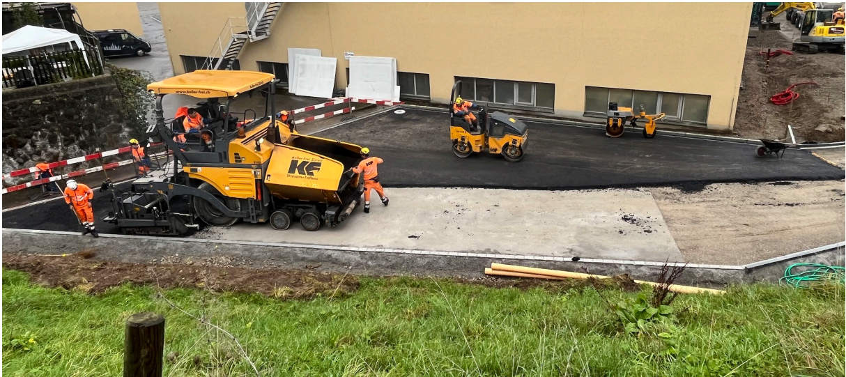
Bild 15: Die Asphalttschicht wird mit einem Strassenfertiger eingebaut.
