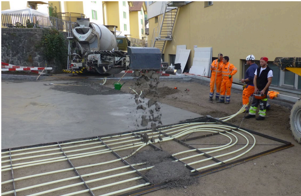
Bild 12: Einbringen des Zementmörtels mit dem Förderband
