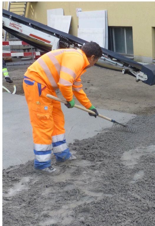
Bild 14: Sobald die Rohre überdeckt sind, müssen die Rohre zur gleichmässigen Verteilung der Mörtelschicht betreten werden.
