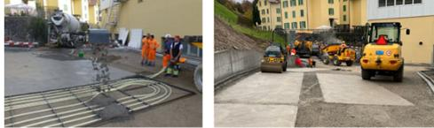
Querträger verhindern das Abfließen des Betons auf geneigten Strassenabschnitten. Die Betonschicht schützt die Rohre beim Asphaltieren und verbessert die Wärmeleitung zu den Rohren
