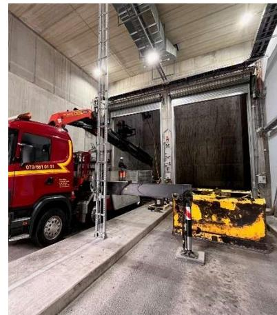
Abbildung 4: Austausch des Schlammgreifers
