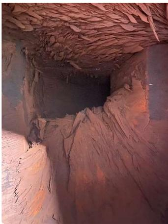
Abbildung 2: verschlackter Übergang Ofen / Abhitzekeessel
