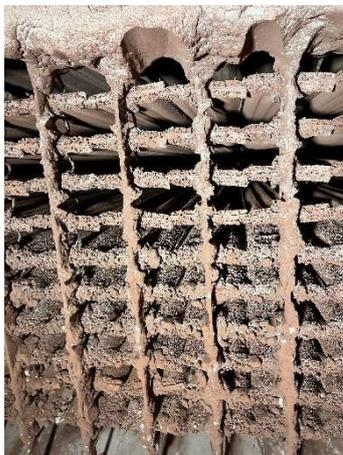
Abbildung 5: Gewebefilterkerzen Rauchgasseite. Versuch mit Teflonschläuchen zur Verminderung von Verstopfungen (erste 4 Reihen von oben)
