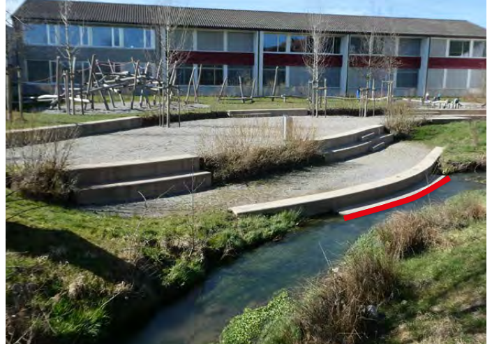
Der Übergang vom Wasser ans Land wird an der Surb in Niederweningen durch die unterste Stufe unterbrochen (rote Markierung). © André Seippel
