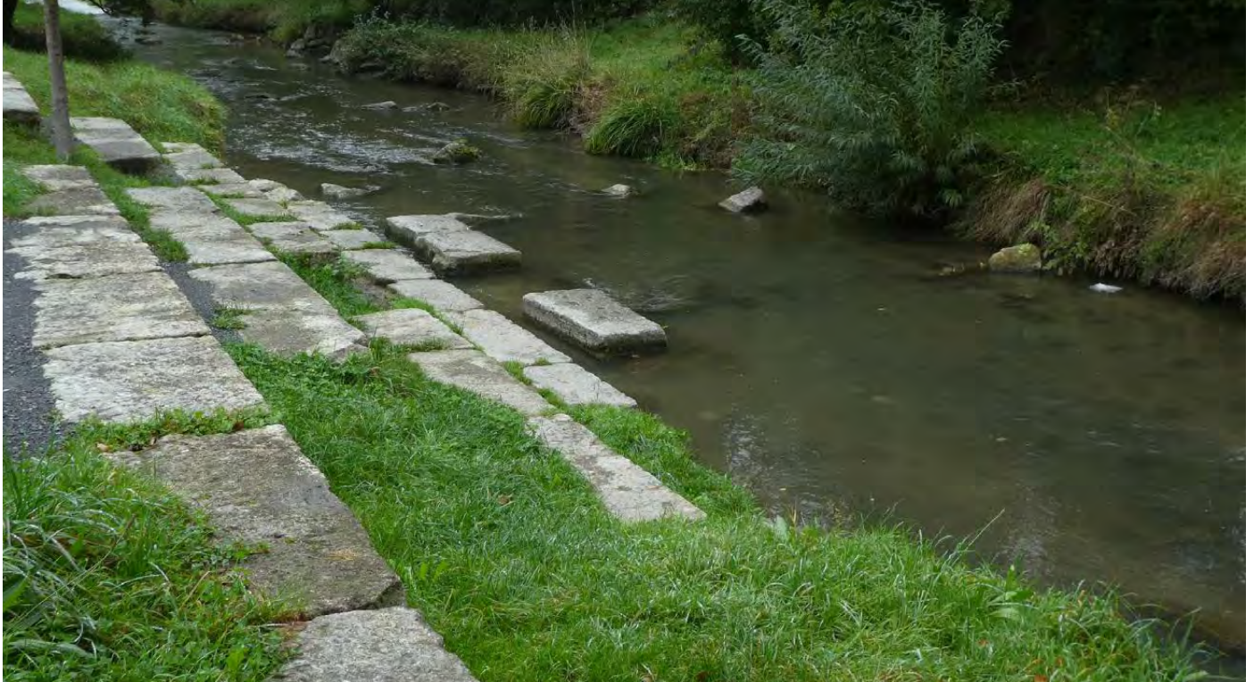
Zugang mit weichem, verzahntem Übergang von den Steinen zur Böschung an der Bünz in Wohlen. © André Seippel
