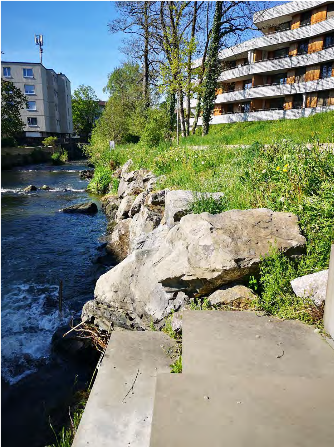
Abrupter Übergang von flacheren Sitzstufen auf steile Böschung aus Steinblöcken am Aabach in Uster. © AWEL
