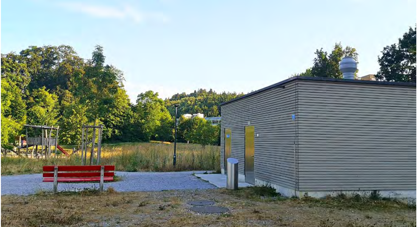
Permanente Sanitäranlage am Grändelbach in Effretikon. © AWEL
