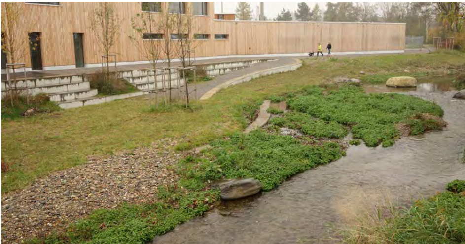
Derselbe Zugang 2020 mit verlandeter Aufweitung und verkrauteter Kiesbank. Der Zugang zum Wasser ist nicht mehr direkt gegeben. © André Seippel
