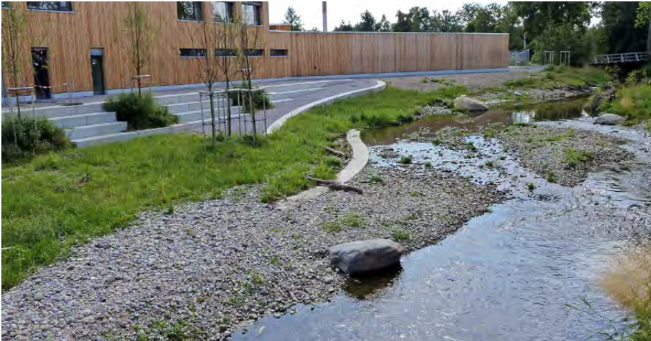
Zugang am Wildbach in Wetzikon 2013 kurz nach Inbetriebnahme mit Aufweitung und Kiesbank. Die Rampe dient der Zugänglichkeit (z. B. Kinderwagen) sowie dem Unterhalt. © André Seippel
