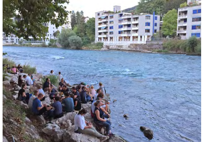
Blockteppich, eine flächige Ansammlung von Steinblöcken, als uferstrukturierendes Element, das auch als Aufenthaltsbereich genutzt wird an der Limmat in Baden. © André Seippel
