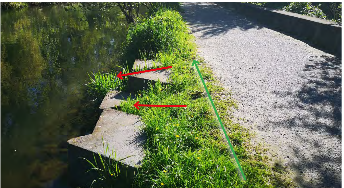
Die Vegetation zwischen den Dreieckselementen am Aabach im Stadtpark Uster lässt sich nur von Hand pflegen (rote Pfeile). Maschinen können nur im oberen Bereich dem Weg entlang eingesetzt werden (grüner Pfeil). © AWEL
