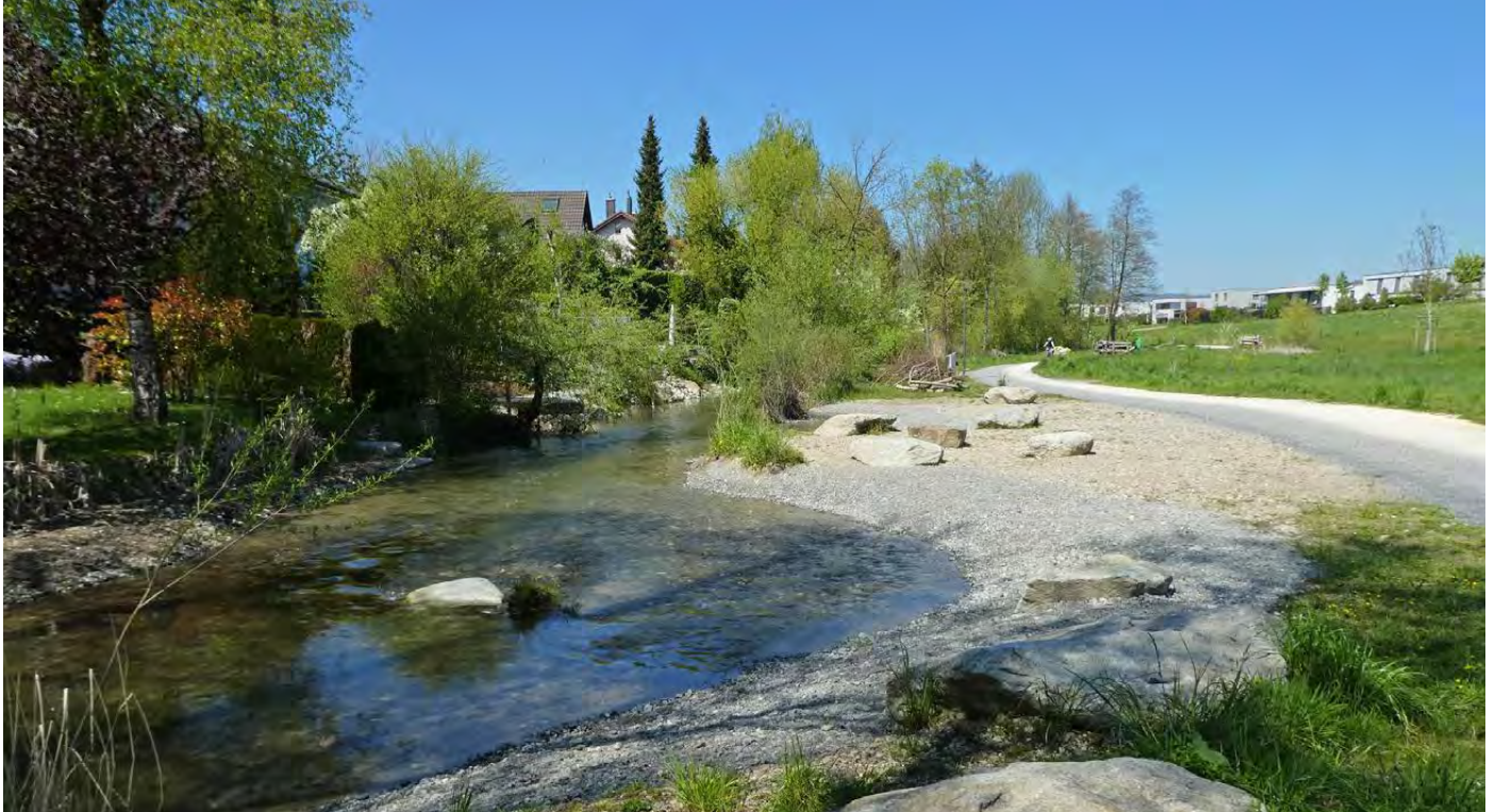
Strömungsvariabilität durch Steinblöcke, variable Sohlenbreite und Kiesbänke in der Sure in Oberkirch. © André Seippel
