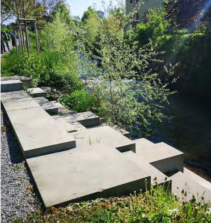
Treppenstufen aus geschliffenem Sandstein am Aabach in Uster. © AWEL
