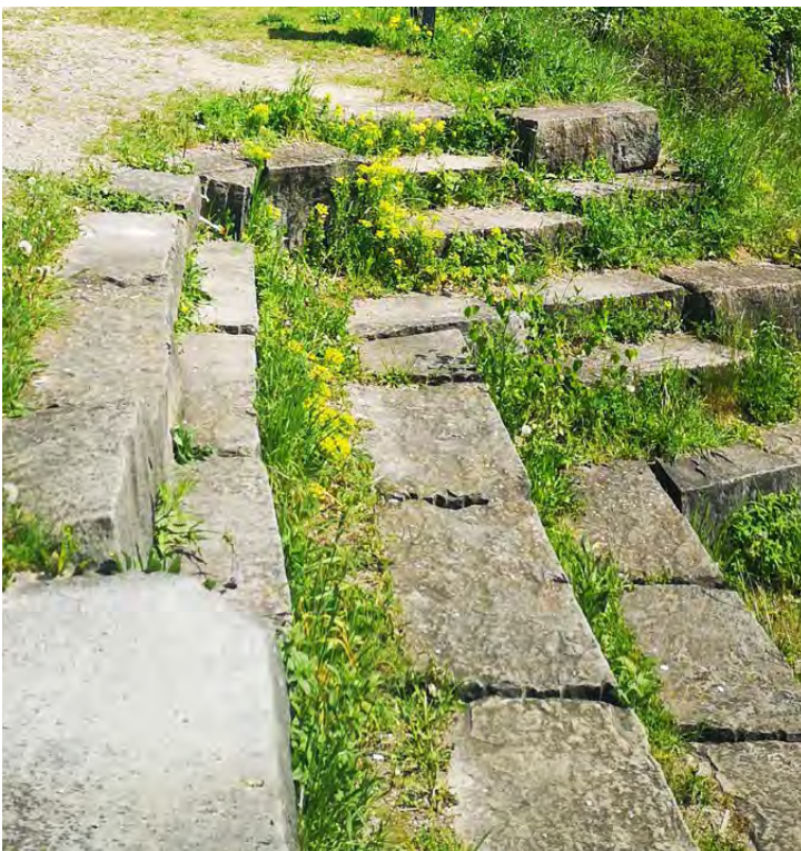
Treppenstufen aus gebrochenen/behauenen Steinblöcken am Chriesbach in Dübendorf. Der unregelmässige Abstand der Stufen und die teils geneigten Blöcke erfordern Trittsicherheit. © AWEL
