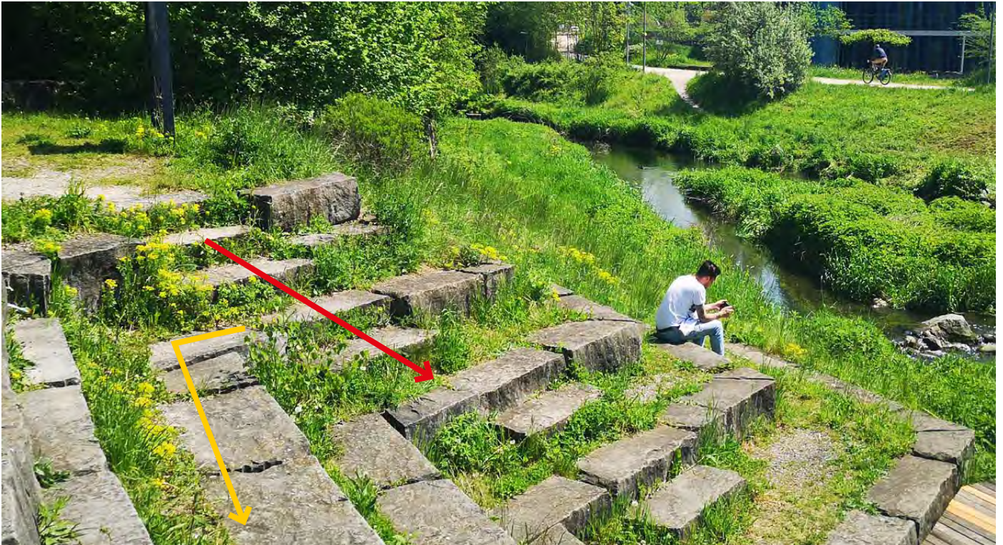
Die Stufen sind ein Hindernis für Maschinen (roter Pfeil). Die Vegetation zwischen den Stufen am Chriesbach in Dübendorf ist nur mit Kleingeräten zugänglich (gelber Pfeil). © AWEL
