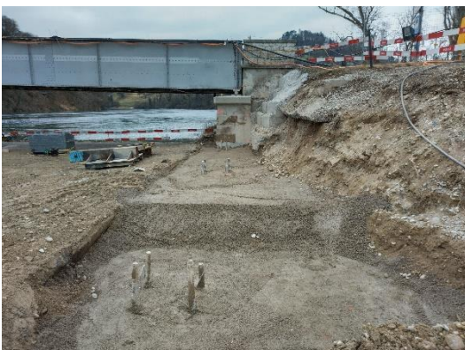
Ankerarbeiten fertiggestellt
