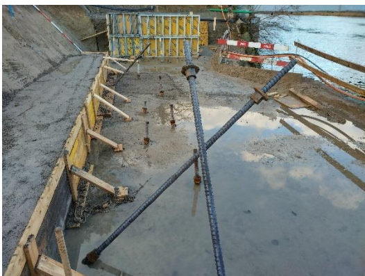
Ankerarbeiten fertiggestellt
