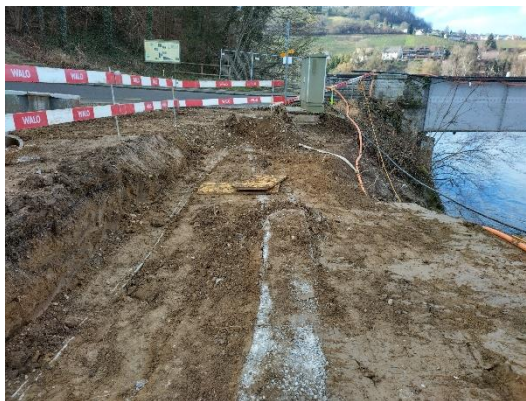
Freigelegte Werkleitungen
