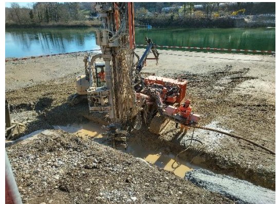
Durchführung Ankerarbeiten
