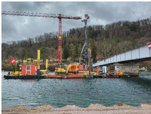
Arbeitsponton im Einsatz
