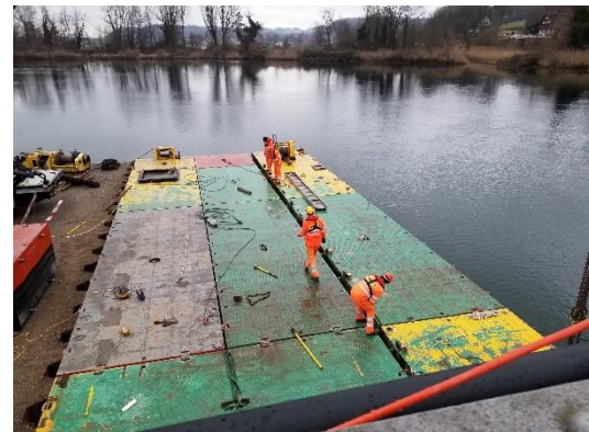
Zusammenbau Arbeitsponton
