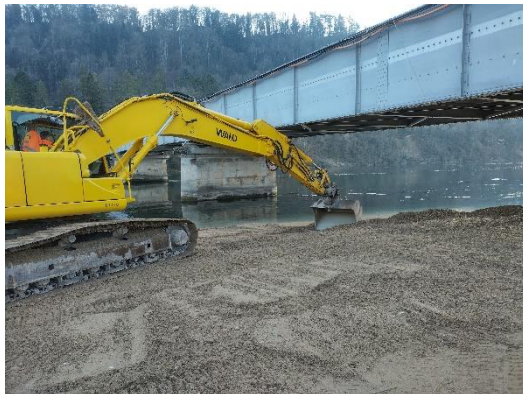
Schütten der Anlegestelle
