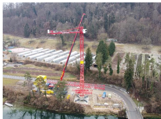
Montage Turmdrehkran
