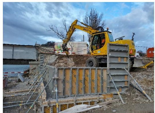
Erstellung Negativbeton
