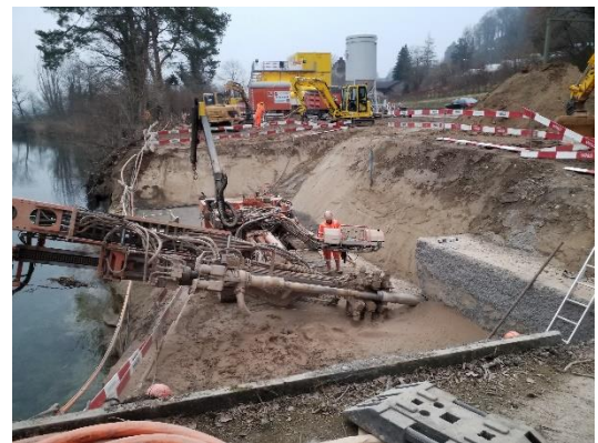
Durchführung Ankerarbeiten
