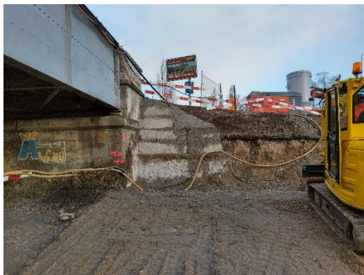
Sicherungsmassnahme Widerlager Nord
