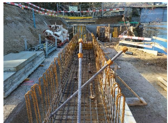
Bewehrungsarbeiten Sockel fertiggestellt
