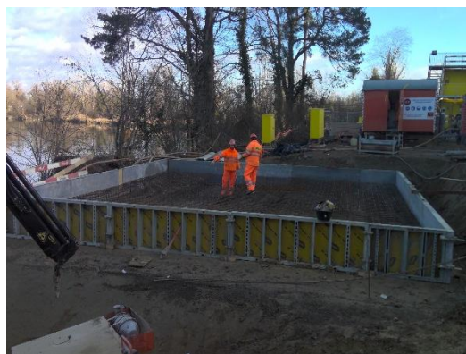
Bewehrungsarbeiten Fundamentplatte
