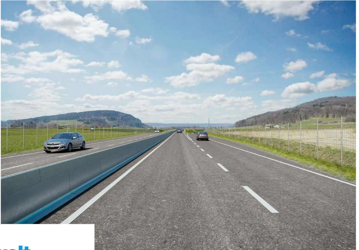
Die Schaffhauserstrasse in Bülach wird zu einer vierspurigen Miniautobahn ausgebaut. Quelle: Tiefbauamt
