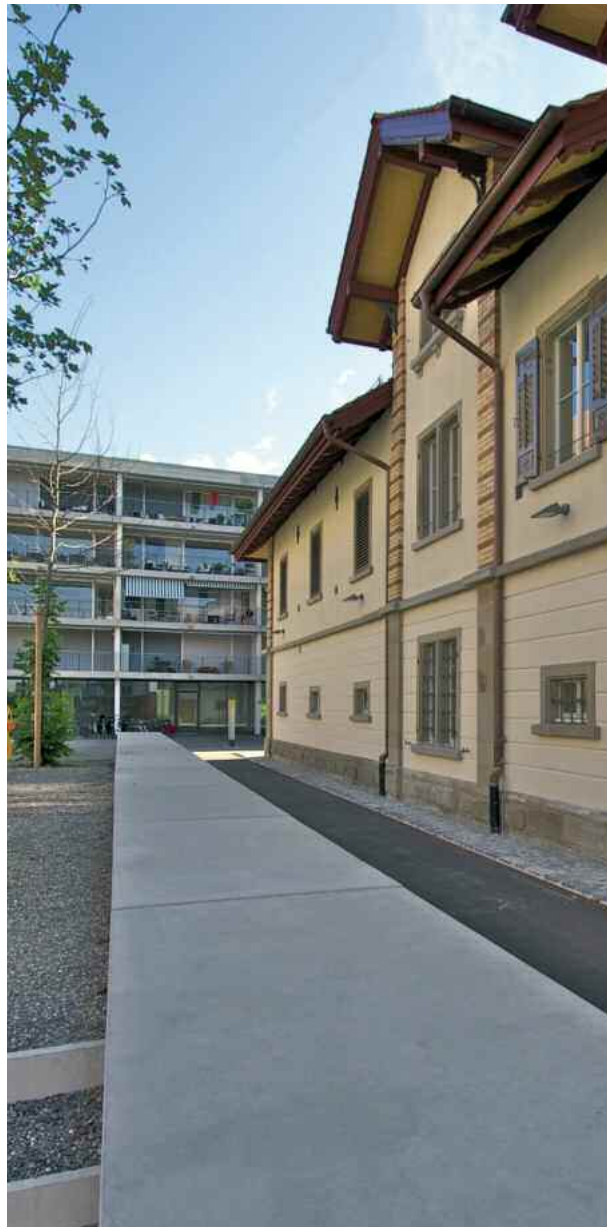
Zwicky-Areal Wallisellen Der Erhalt von historischen Merkmalen ist für die Identität der Orte und Gemeinden zentral.
