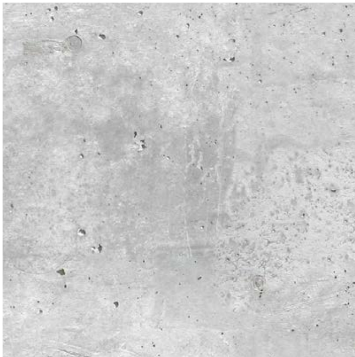
Unterzüge und Stützen Sichtbeton Bestand
