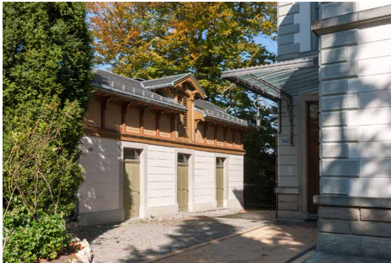
Ökonomiegebäude in polychromer Farbfassung
