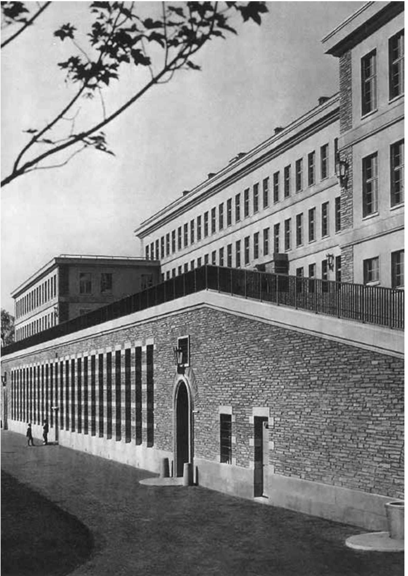
Fassade Süd, Aufnahme 1928, Werk
