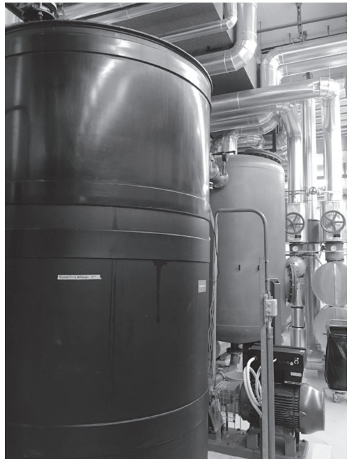
Tankanlage Sanitärzentrale
