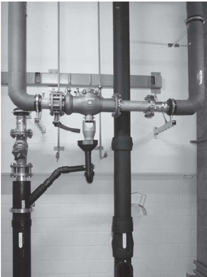
Sanierung Notkühlanlage Rechenzentrum
