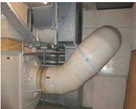
Einzelventilatoren Kapellenabluft
