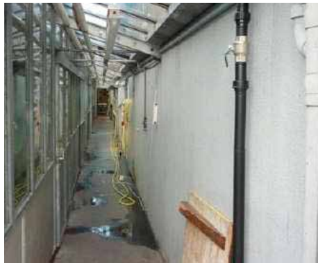
Heutiger Korridor vor Lüftungszentrale
