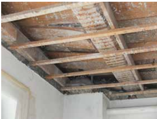
Holzbalkendecke mit Blindboden
