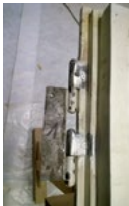
Neu: Fischband nach Umbau
