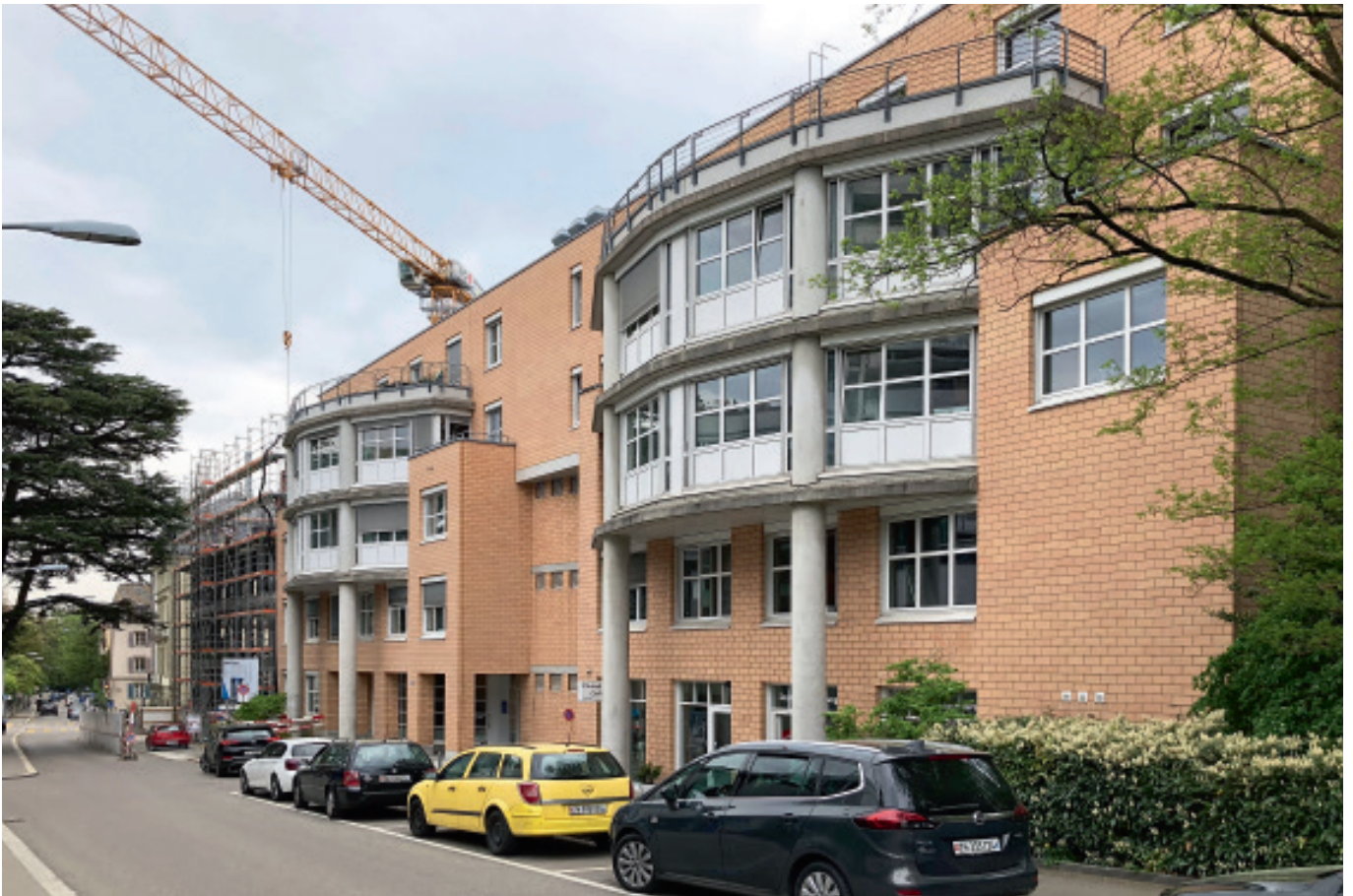
Ansicht Plattenstrasse, Richtung Erweiterungsbau
