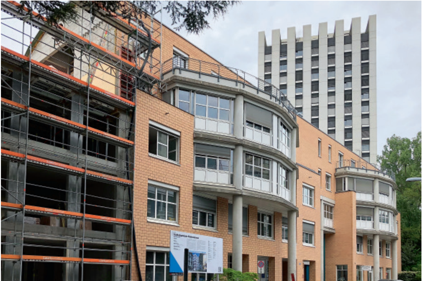
Ansicht Plattenstrasse, Richtung Schwesternhochhaus
