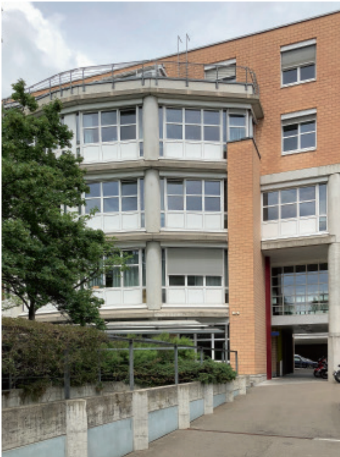
Ansicht Phönixweg mit Durchgang zu Plattenstrasse
