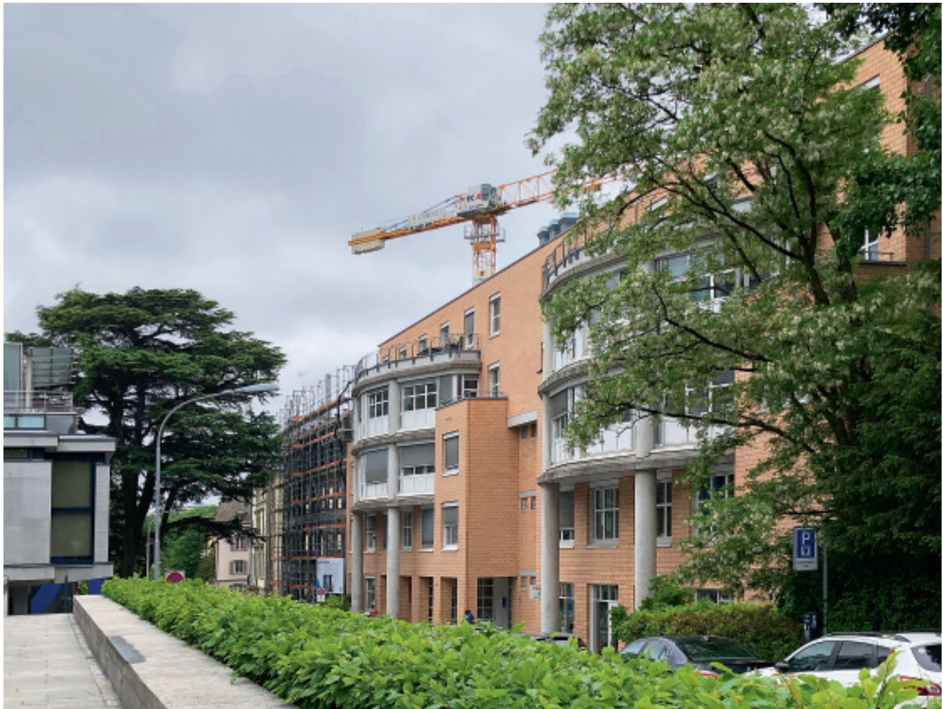
Institutsgebäude PLM an Plattenstrasse
