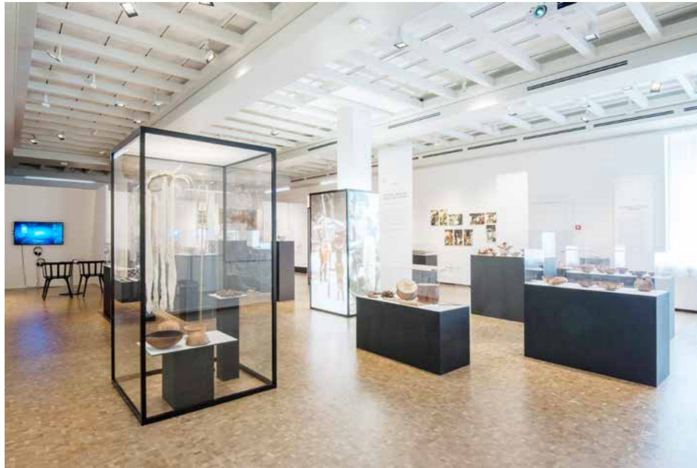
Ausstellungssaal nach Sanierung mit neue Balkendecke
