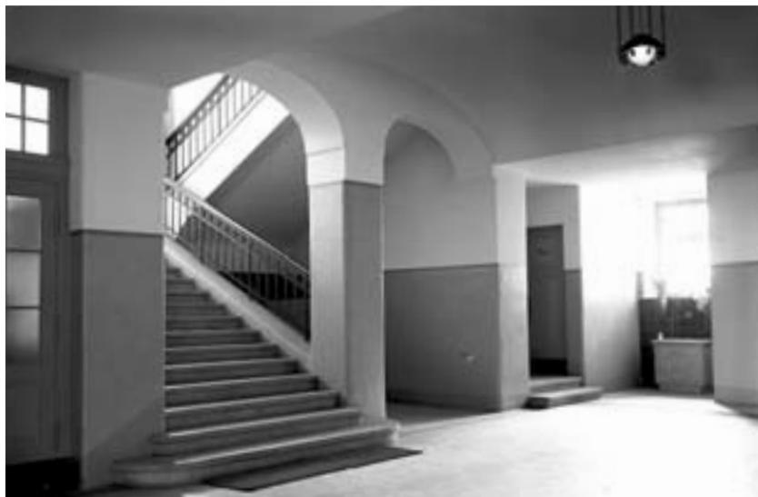
Das Bild unten zeigt das historische Treppenhaus des Fietz-Baus, das Bild oben das Treppenhaus im Zustand nach der Sanierung 1961 durch Giacometti. Im Zuge der Brandschutz- und Altlastensanierung müssen die Verkleidungen von 1961 wieder entfernt werden. Somit wird die grosszügige Grundstruktur des Fietz-Baus wieder sichtbar und seine räumlichen Qualitäten können hervortreten.
