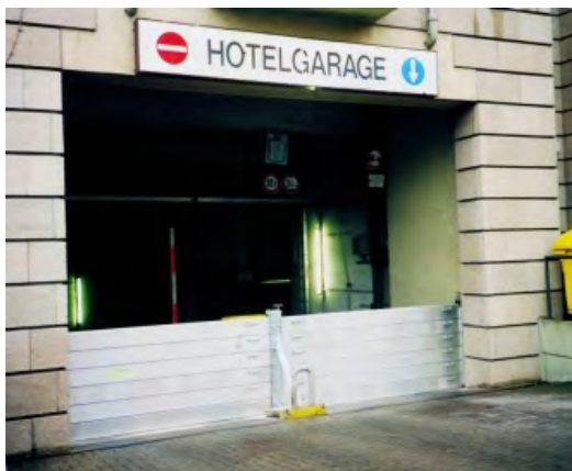
Dammbalken bei Garageneinfahrt
