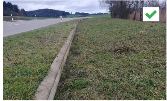
**Der Fuss des Leitwerks muss bündig mit dem umliegenden Terrain sein**
