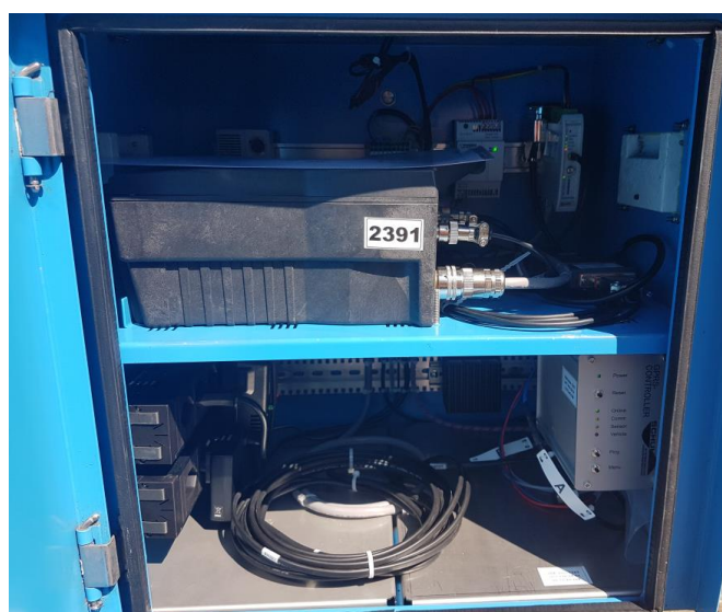
Abbildung 25: Einbau MIV- und Bike-Counter-Zählgerät in Apparateschrank
