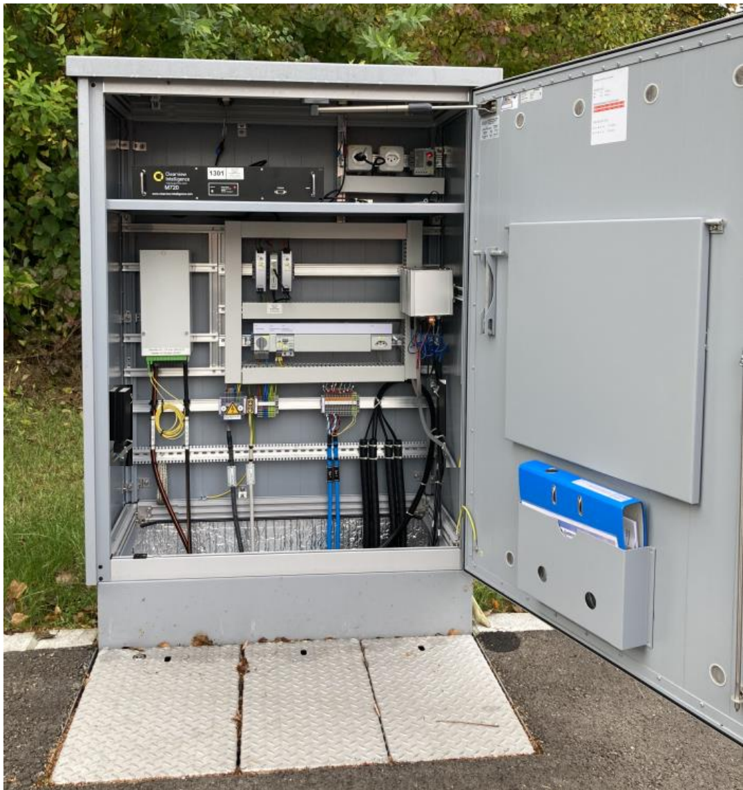
Abbildung 14: Doppelwandkabine Almatec ANK 1000 x 1250 x 550 mm
