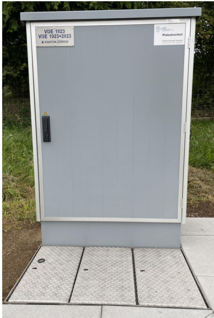
Abbildung 15: VDE-Kabine mit Beschriftung, auf Chromstahl-Erdsockel montiert
