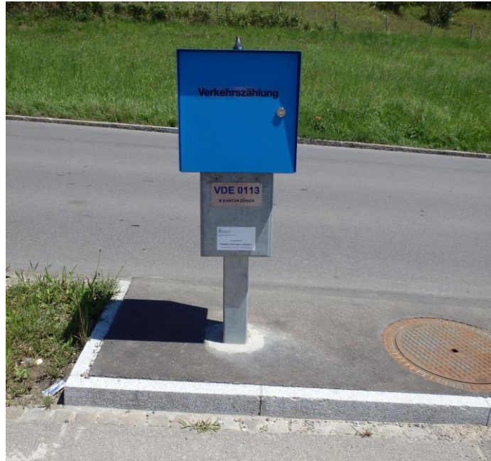
Abbildung 5: Bedienfläche mit Asphaltbelag
