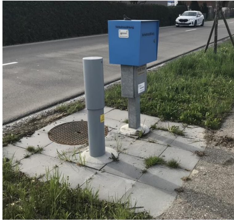
Abbildung 3: Bedienfläche mit Betonplatten
