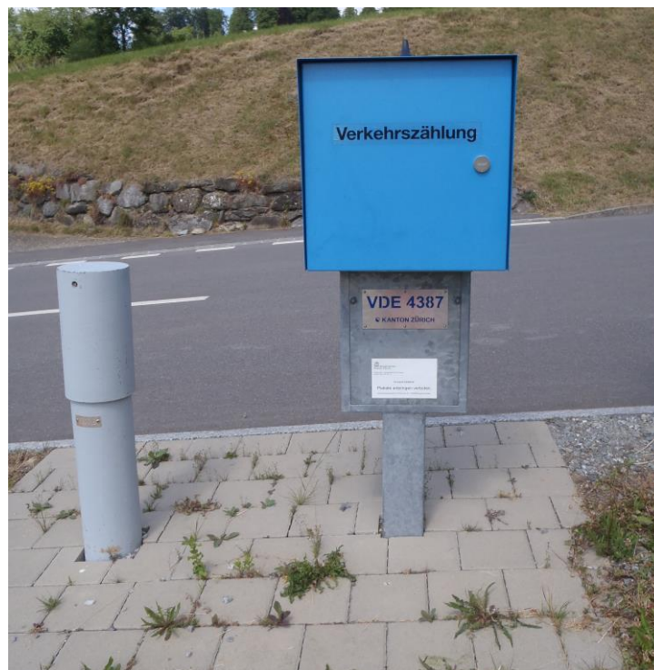
Abbildung 2: Bedienfläche mit Betonverbundsteinen
