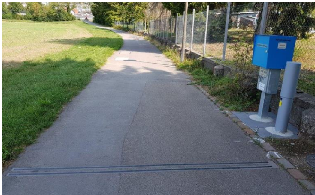
Abbildung 20: Im Strassenbelag eingebaute Sensoren (Beispiel Radweg)
