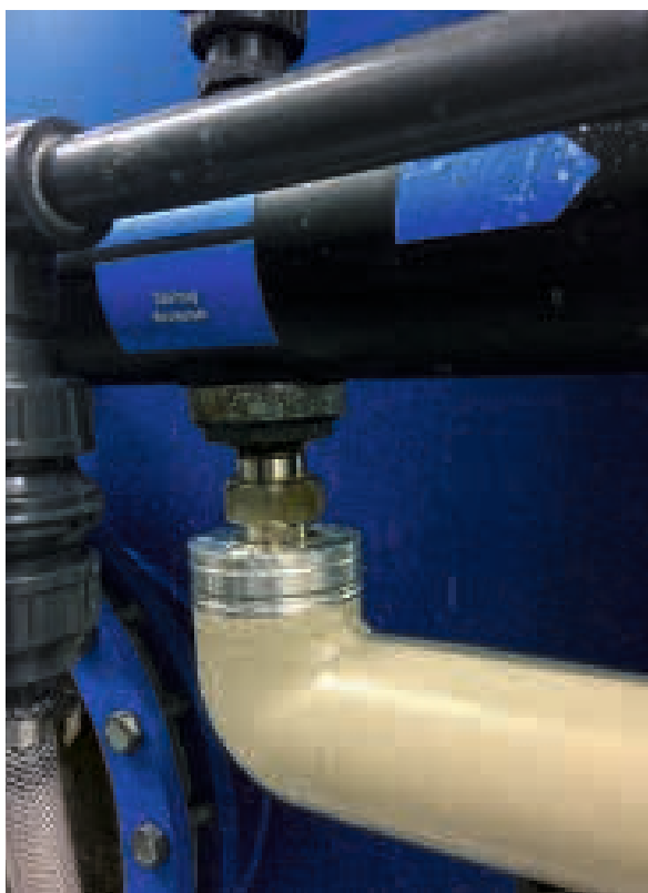
Abb. 8.3.1 Verbindung Trinkwasser und Badewasser
