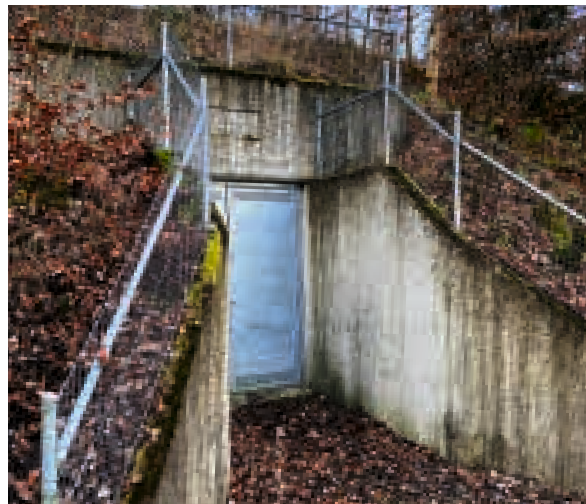
Abb. 8.2.1: Guter Zugang Reservoir
