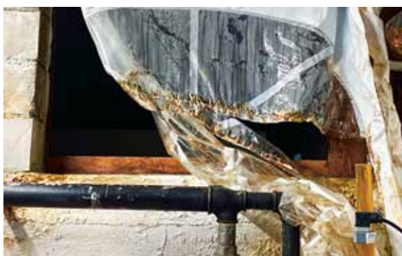
Abb. 8.3.1: Einstiegsöffnung zum Ausgleichsbecken.
