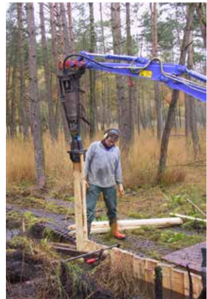
Erstellen einer Spundwand für die Moorregeneration (Foto: FNS)
