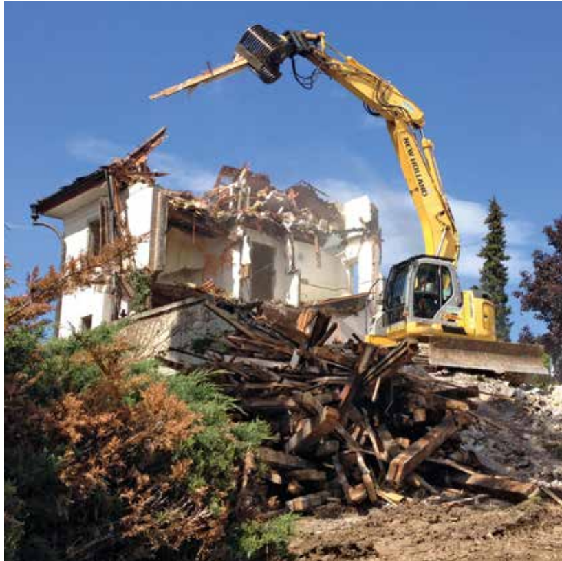
Gebäuderückbau Pfarrhaus Erlenbach
