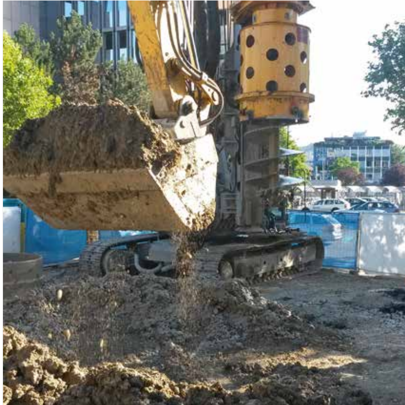
Grosslochbohrung zur Sanierung eines mit Chlorkohlenwasserstoff (CKW) belasteten Standorts.
