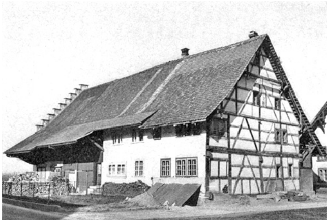
Flaach. Oberhof. Hausteil Vers.-Nr. 468 vor der Renovation.
