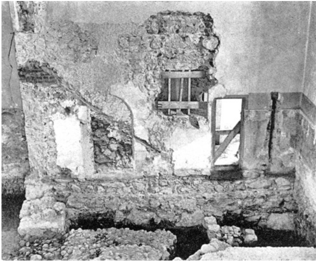
Hausen a. A. Reformierte Kirche. Turmsüdmauer während der archäologisch-bauanalytischen Untersuchungen 1968.
