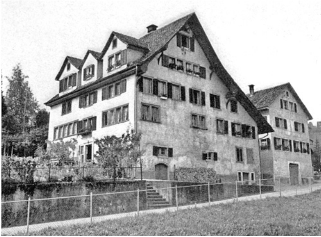
Richterswil. Erlenstrasse 17/19. Ehemaliges Weinbauernhaus Vers.-Nr. 505, abgebrochen 1969 (zu S. 119).
