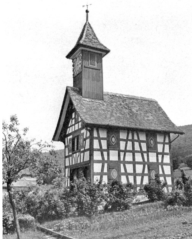
Schleinikon. «Zythusli». Nach der Restaurierung 1968/69.
