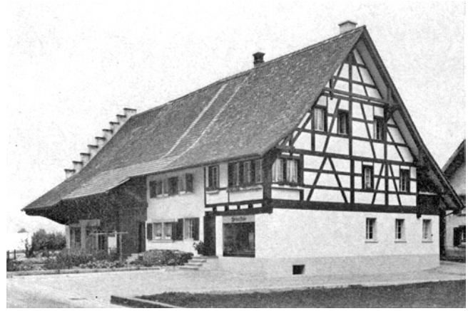
Flaach. Oberhof. Hausteil Vers.-Nr. 468 nach der Renovation 1967/68.
