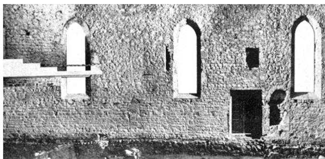
Maur. Reformierte Kirche. Nordmauer, grossenteils romanisch, nach Abschlagen des Verputzes, photogrammetrische und Normalaufnahme kombiniert.
