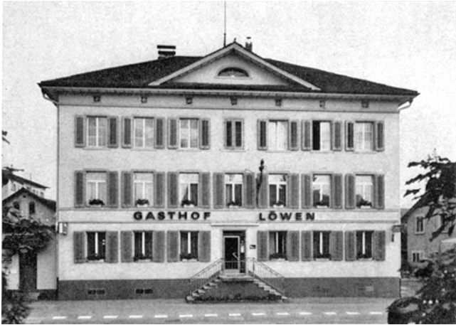
Mönchaltorf. Gasthof «Zum Löwen». Nach der Renovation 1970 (zu S. 103).
