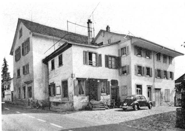
Grüningen. Haus Vers.-Nr. 869 (Färberhaus). Altbau (zu S. 53).
