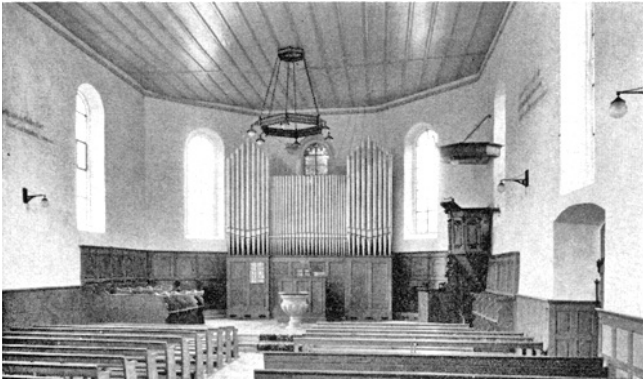
Weiach. Reformierte Kirche. Inneres vor der Restaurierung 1967/68.
