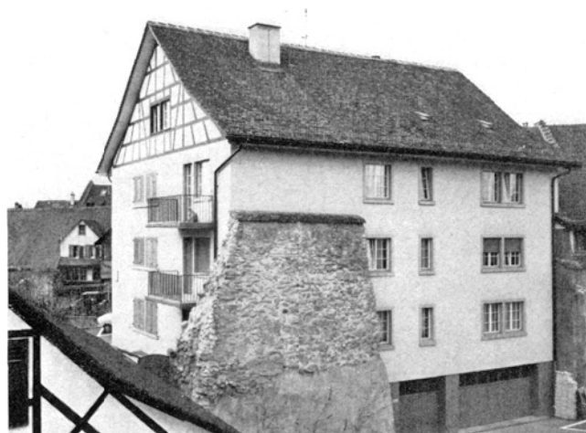
Bülach. Obergasse 3/5. Neubau 1968/69.
