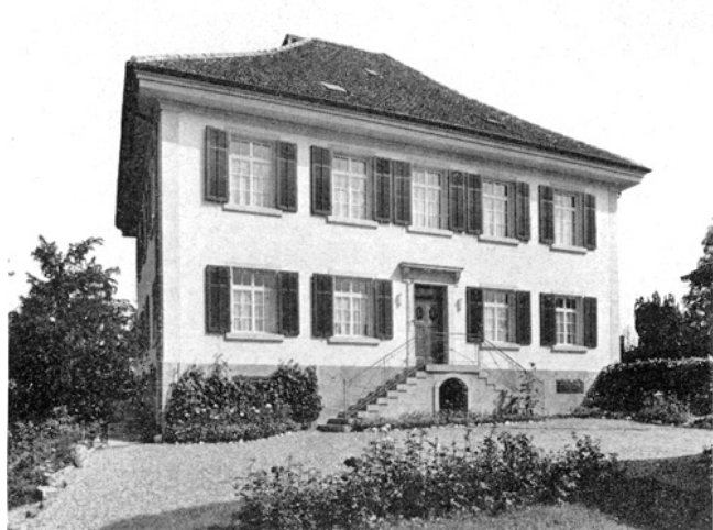
Hettlingen. Pfarrhaus. Nach der Renovation 1968/69.
