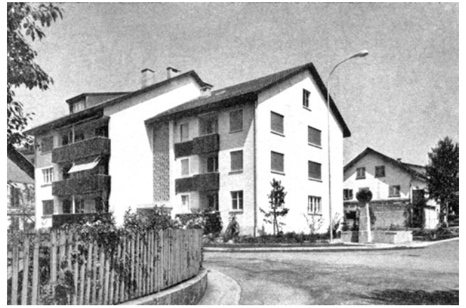
Elgg, Untergasse/Ecke Hintergasse. Neubau anstelle des Hauses «Zur Blume». 1969/70.
