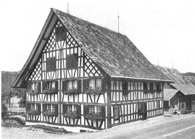
Hedingen. Restaurant «Zum Frohsinn». Nach der Renovation 1971.
