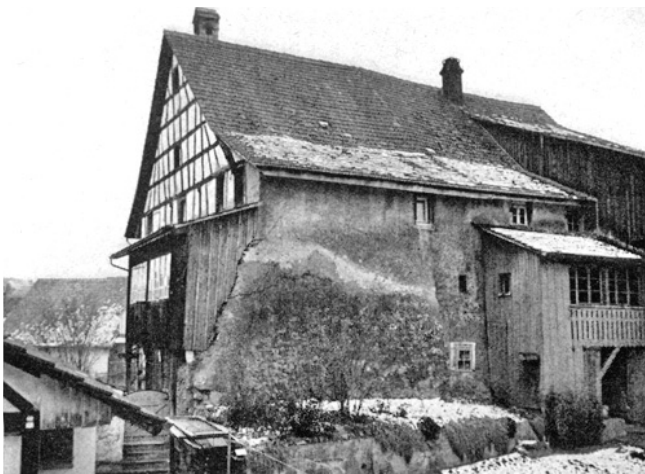
Bülach. Obergasse 3/5. Riegelhaus Vers.-Nr. 198 a/200, abgebrochen 1967.
