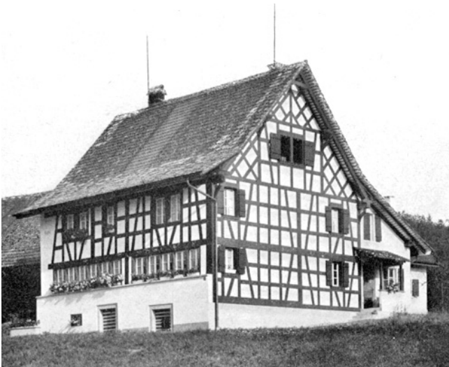
Bubikon. Talhof. Bauernwohnhaus Vers.-Nr. 567. Nach der Renovation.
