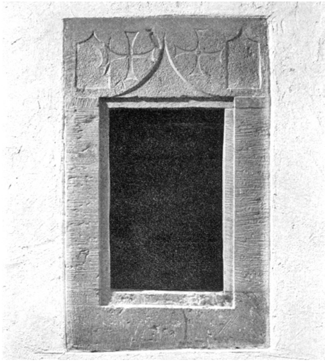
Wangen. Reformierte Kirche. Ehemaliger Turmchor. Spätgotische Sakramentsnische.
