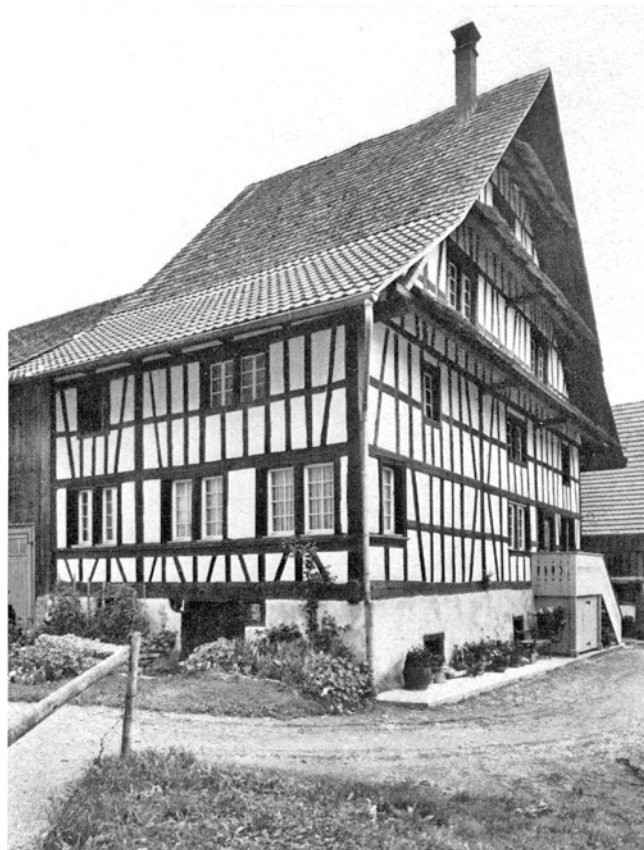
Rifferswil. Oberriefferswil. Bauernhaus Vers.-Nr. 33. Nach der Renovation 1971/72.
