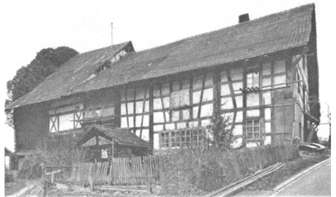
Flaach. Haus «Zum Kehlhof» vor dem Umbau.
