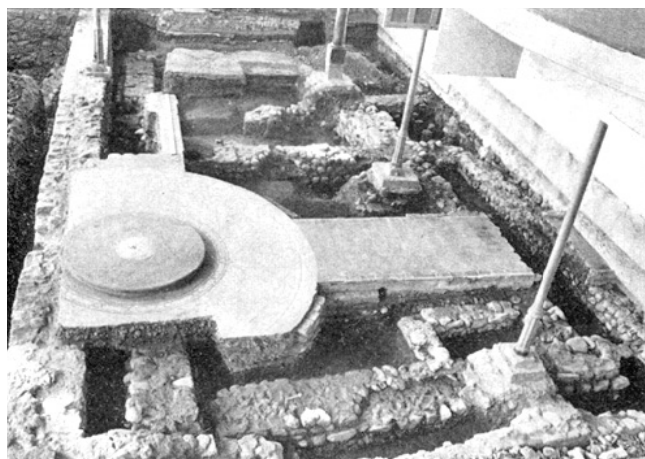
Hinwil. Reformierte Kirche. Archäologische Untersuchungen 1968. Gesamtansicht gegen Westen.
