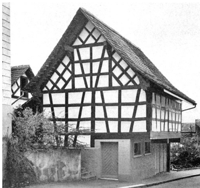
Unterstammheim. Dorfstrasse. Speicher Vers.-Nr. 161. Nach Renovation und Umbau 1968.
