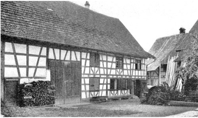
Marthalen. Oberdorf. Ehemaliges Bauernhaus Vers.-Nr. 46A vor Renovation und Umbau 1969.
