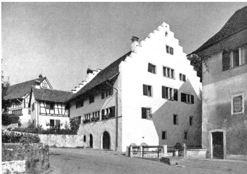
Otelfingen. Untermühle. Nach der Restaurierung 1969/70.
