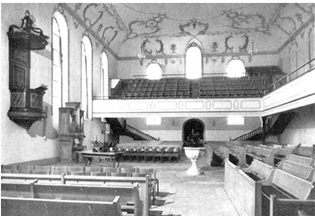
Hinwil. Reformierte Kirche. Inneres nach der Renovation 1968/70.
