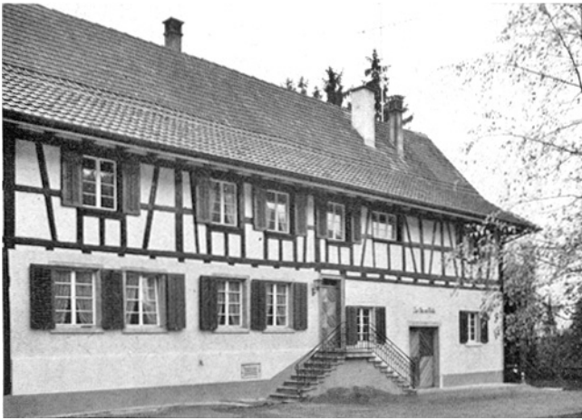
Rafz. Obere Mühle. Nach der Renovation 1969.
