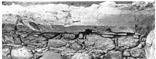
Hausen a. A. Reformierte Kirche. Detail der Südmauer der Kirche von 1494.
