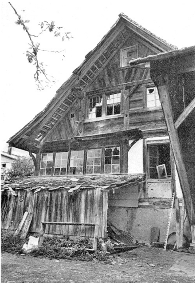
Bauma. Saland. Im Wald. Ehemaliges Bauernhaus Vers.-Nr. 567, abgebrochen 1968.
