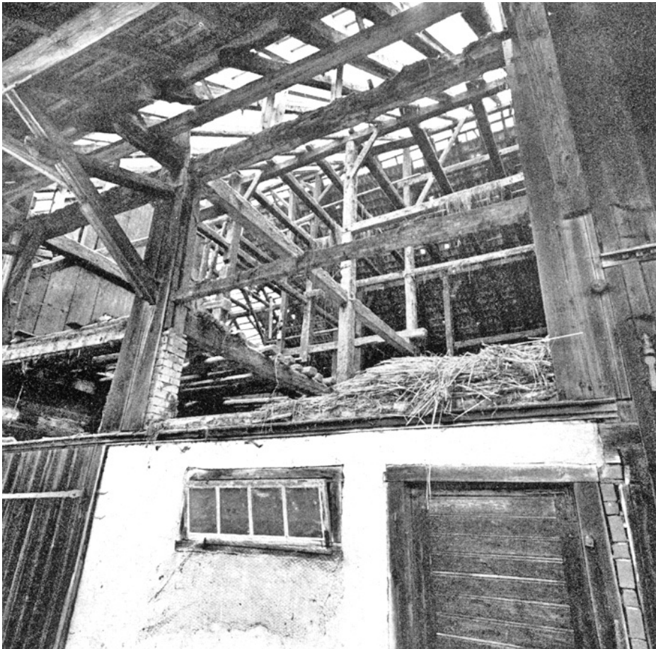
Affoltern. Im St. Blasienhof 12. Blick ins Dachgerüst über der Scheune. In der Bildmitte sind die Hochstuden gut sichtbar.
