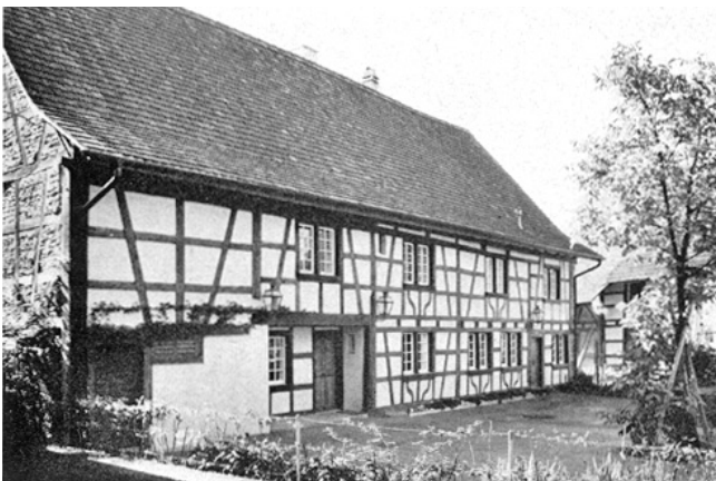
Marthalen. Oberdorf. Ehemaliges Bauernhaus Vers.-Nr. 46A nach Renovation und Umbau 1969.
