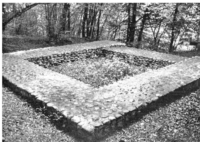
Weiach. Hardwald. Verfluchter Platz. Römischer Wachturm. Oben: Zustand 1963, Mitte: Nach der Freilegung 1969, unten: Nach der Konservierung 1969.
