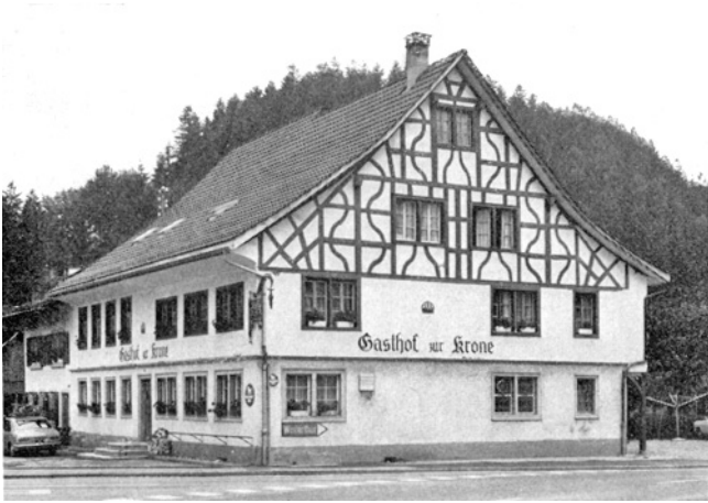
Bauma. Saland. Gasthof «Zur Krone». Nach der Renovation.
