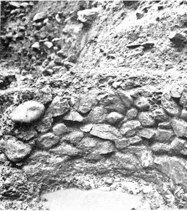
Schiffe 13 und 15. Mauerwerk des römischen Schachtes B.
