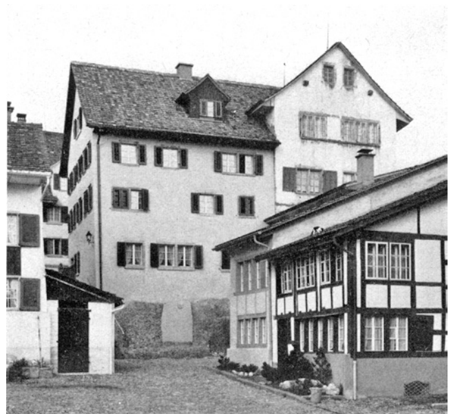
Grüningen. Haus Vers.-Nr. 843 (Mangihaus). Neubau von 1969/70.
