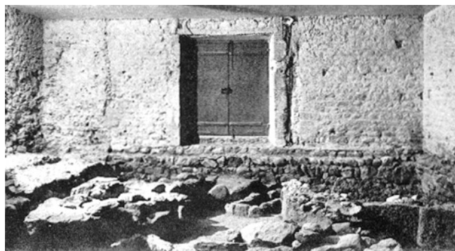
Maur. Reformierte Kirche. Westmauer, links und rechts der Türe romanisch, ganz links, durch deutliche Mauerfuge abgetrennt, gotisch.
