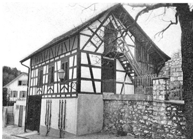
Regensberg. Unterburg. Riegelhäuschen Vers.-Nr. 53.
