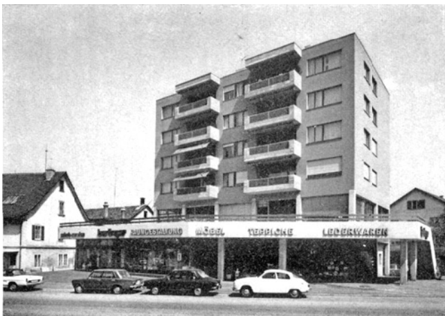
Kloten. Schaffhauserstrasse 134. Neubau 1970 anstelle des ehemaligen Hauses «Zur Gerbe».
