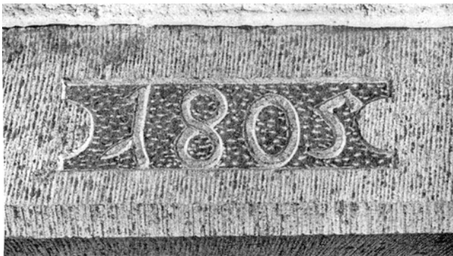
Rifferswil. Waschhaus beim Pfarrhaus. Jahrzahl am Türsturz nach der Überarbeitung 1968.
