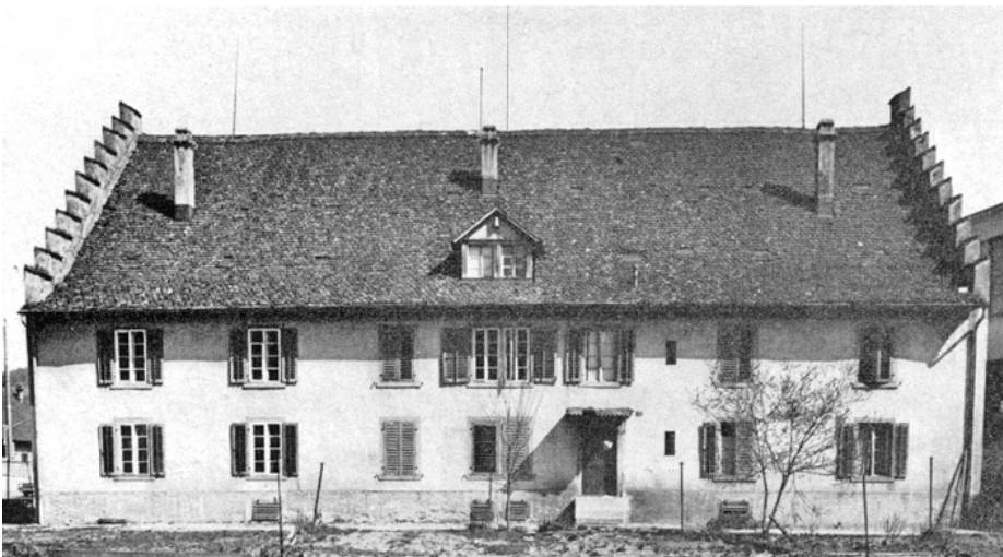
Winterthur. Töss. Bauernhaus des ehemaligen Klosters, abgebrochen 1969.
