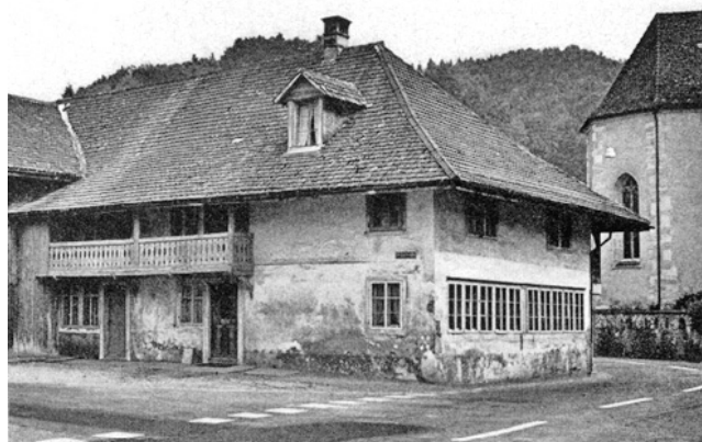
Turbenthal. St. Gallerstrasse/Chilerank. Ehemaliges Bauernhaus Vers.-Nr. 442, abgebrochen 1968.
