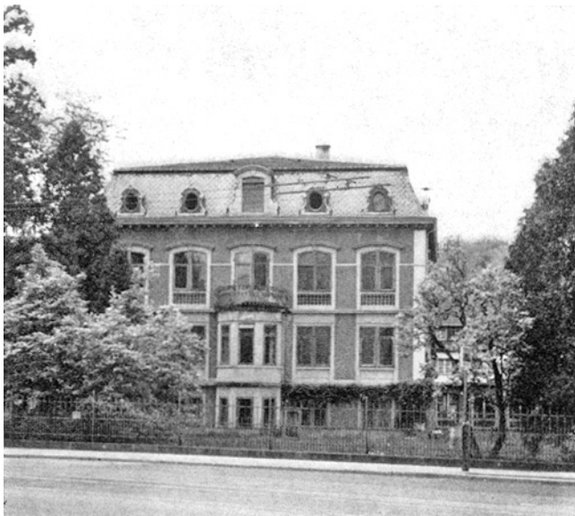
Winterthur. Altstadt. Anton-Graff-Strasse. Haus «Unterer Brühl» vor dem Abbruch.
