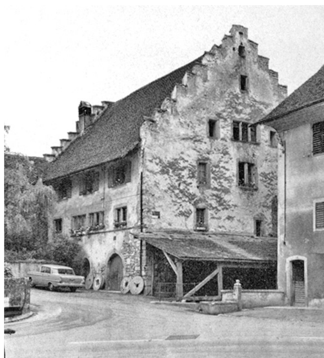
Otelfingen. Unterühle. Zustand 1964.
