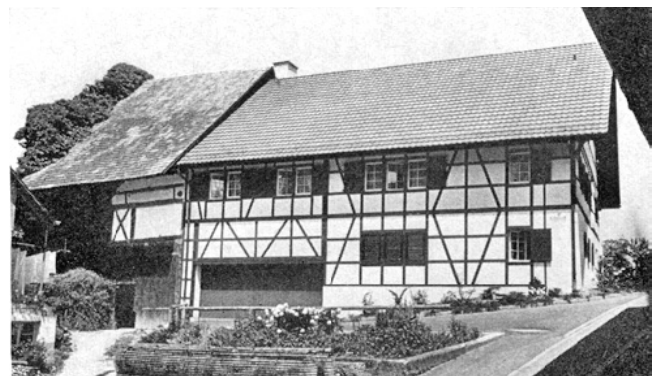
Flaach. Haus «Zum Kehlhof». Hausteil Vers.-Nr. 19 nach dem Umbau.
