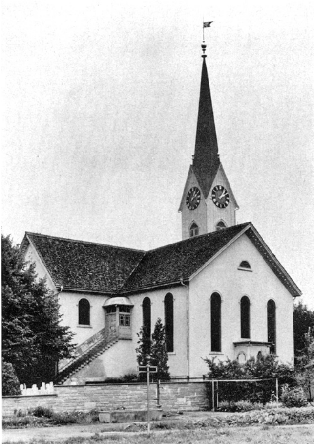
Dübendorf. Wil. Reformierte Kirche, abgebrochen im Sommer 1963. Oben: Äusseres; unten: Inneres gegen Osten.
