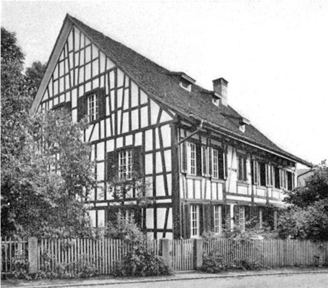
Maschwanden. Pfarrhaus. Nach der Renovation 1968/69.
