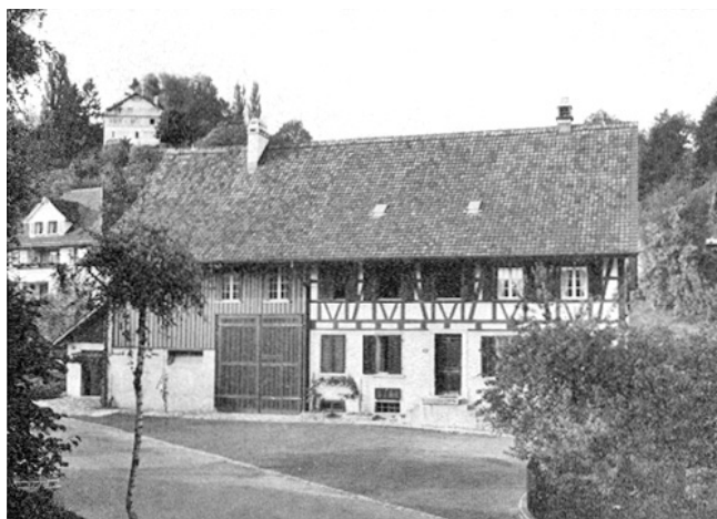
Winterthur. Veltheim. Weinbergstrasse 14. Ehemaliges Weinbauernhaus. Nach Umbau und Renovation.
