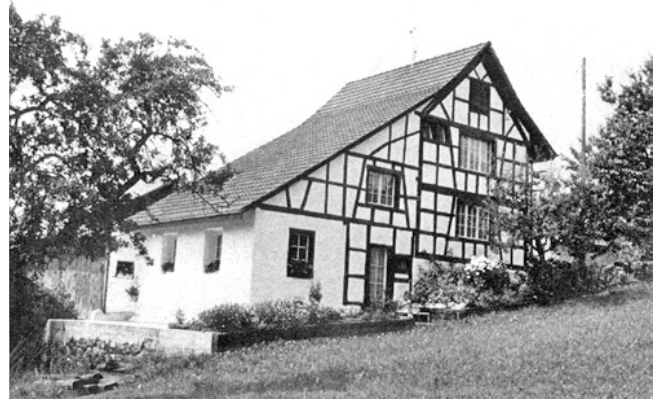
Oberweningen. Chileweg. Ehemaliger Speicher Vers.-Nr. 136. Nach dem Umbau 1969/70.
