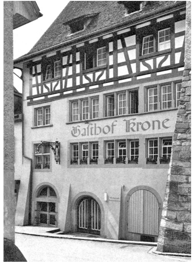
Eglisau. Untergasse. Gasthof «Zur Krone». Hauptfassade nach der Renovation 1969.
