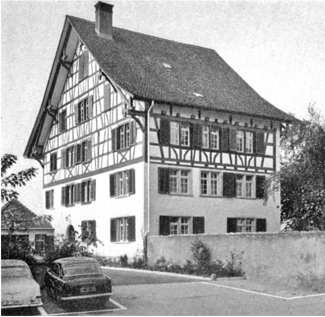
Winterthur. Oberwinterthur. Reformiertes Pfarrhaus nach der Renovation von 1967.
