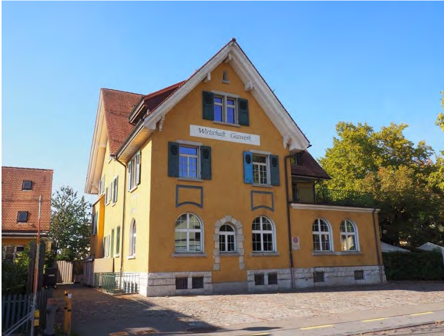
Gaswerkareal, Ehem. Wohlfahrtsgebäude (Vers. Nr. 00462), Ansicht von O, 07.10.2018 (Bild Nr. D101142_13)
