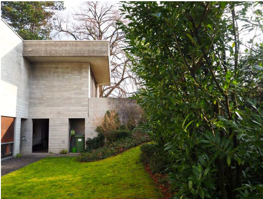
Architekteneigenheim, Detail Südfassade mit Vorsprung nach Osten mit Vorsprung nach Osten, 11.01.2018 (Bild Nr. D101140_58)
