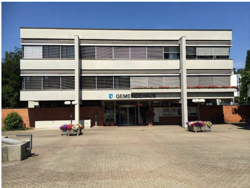
Gemeindehaus mit Wohnhaus, Gemeindehaus (Vers. Nr. 00585), Ansicht von O, 14.04.2014 (Bild Nr. D100661_56)
