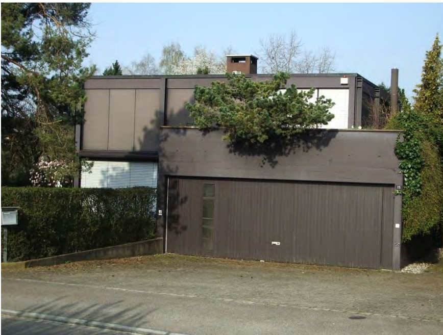
Wohn- und Atelierhaus, Ansicht von O, 01.04.2014 (Bild Nr. D100666_80)
