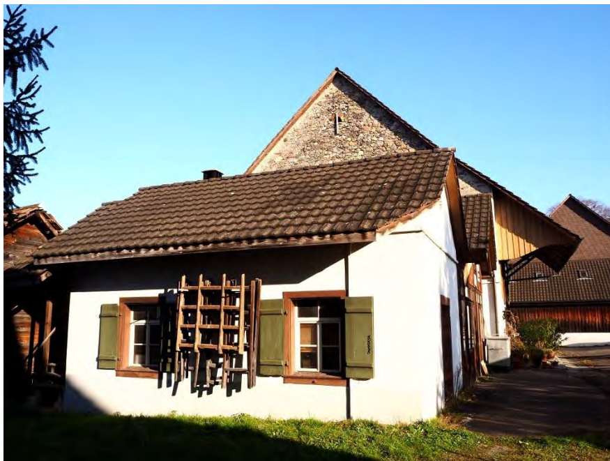
Hofgruppe Badenerstrasse, Ehem. Waschhaus (247WASCH00144), Ansicht von SW, 07.12.2017 (Bild Nr. D101086_13)
