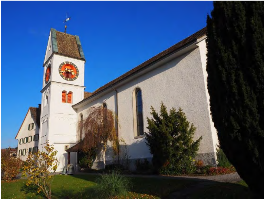
Ref. Kirche St. Martin, Ansicht von SW, 31.10.2017 (Bild Nr. D101131_70)
