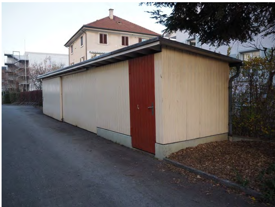
Turnhalle und Kindergarten Im Moos, Velo-Unterstand (247VELO01160), Ansicht von SW, 08.12.2017 (Bild Nr. D101086_21)
