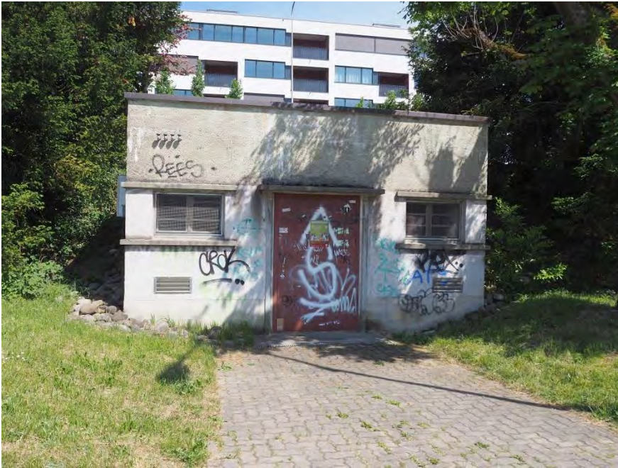
Gasreglerstation, Ansicht von W, 08.05.2018 (Bild Nr. D100677_01)
