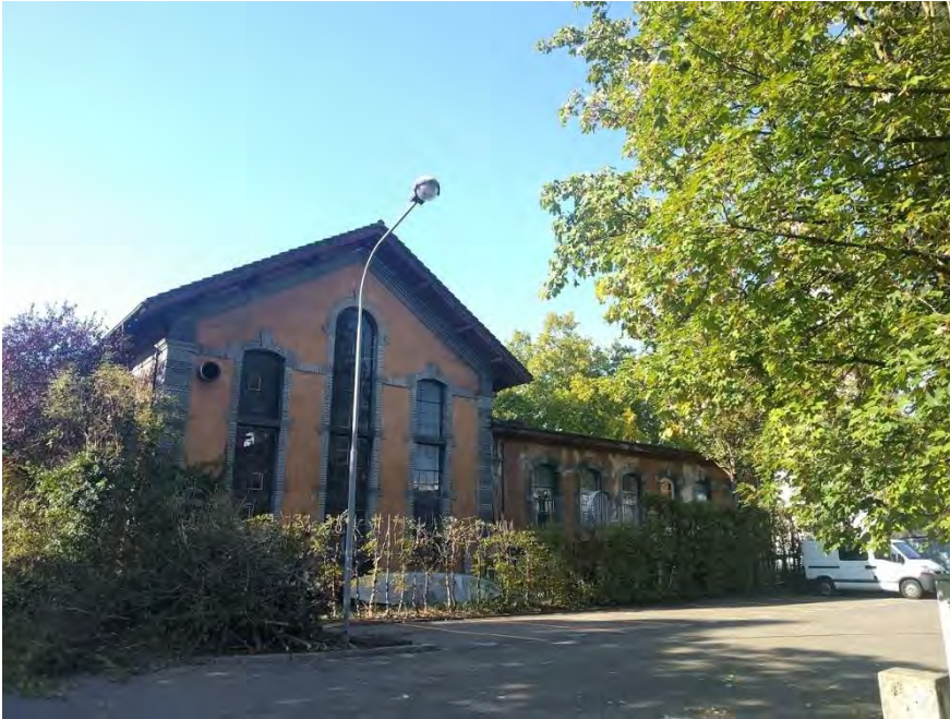
Gaswerkareal, Betriebsbauten, Ehem. Apparatehaus I (Vers. Nr. 00336), Ansicht von SO, 07.10.2018 (Bild Nr. D101141_61)
