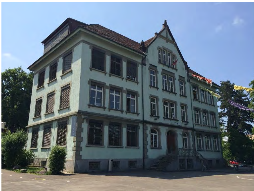
Primarschulanlage Schulstrasse, Schulhaus Grabenstrasse (Vers. Nr. 00366), Ansicht von NO, 12.06.2014 (Bild Nr. D100659_69)
