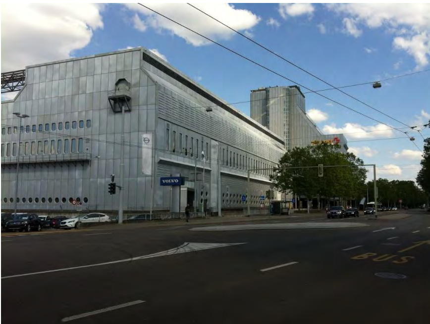
Postbetriebszentrum Mülligen, Ansicht von SW, 16.06.2014 (Bild Nr. D100662_95)
