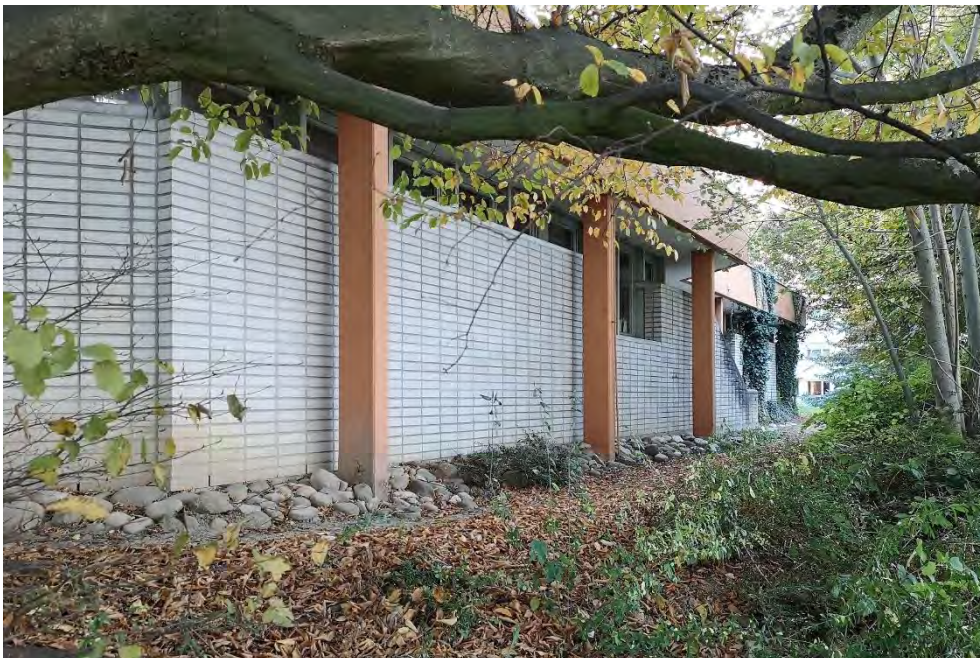
Überbauung «Halde», Kindergarten (Vers. Nr. 01560), Nordfassade (Detail), 20.10.2018 (Bild Nr. D101148_63)
