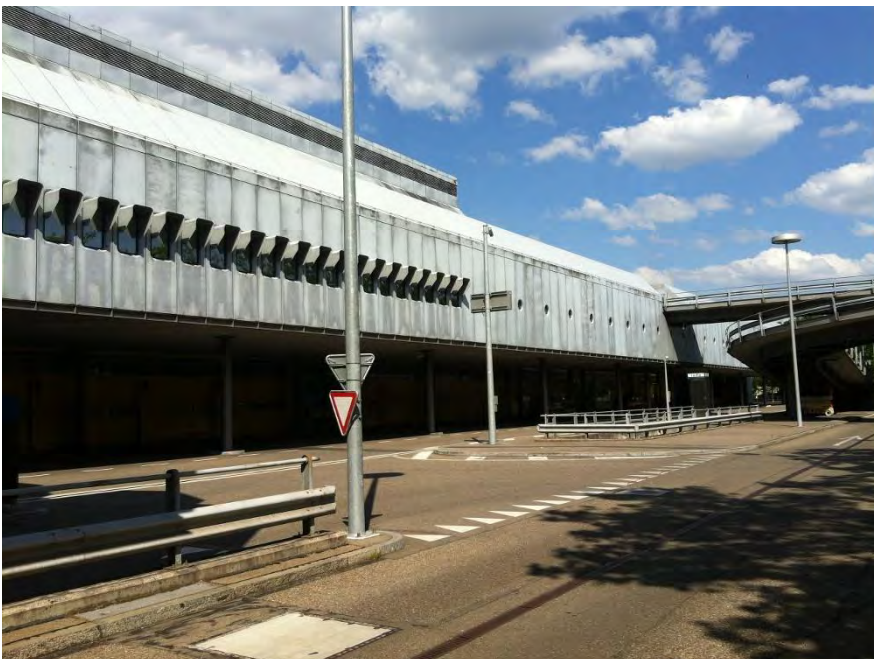
Postbetriebszentrum Mülligen, Betriebsgebäude, östlicher Teil, Ansicht von SW, 16.06.2014 (Bild Nr. D100662_91)
