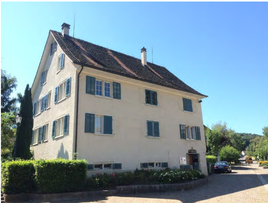
Ehem. Pfarrhaus mit Waschhaus, Ehem. Pfarrhaus (Vers. Nr. 00292), Ansicht von NW, 08.08.2016 (Bild Nr. D1000677_22)
