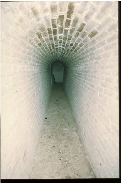
Sperrstelle 5053, Zugsunterstand A04929, 19.03.1998 (Bild Nr. D100538_73).
