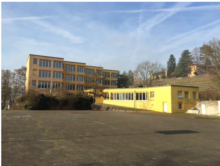
Oberstufenschulanlage Allmend und Sportzentrum Brunewiis, Schulzimmertrakt (Vers. Nr. 00675) und Singsaaltrakt mit Abwartwohnung (Vers. Nr. 00676), Ansicht von SO, 06.01.2015 (Bild Nr. D100659_86)
