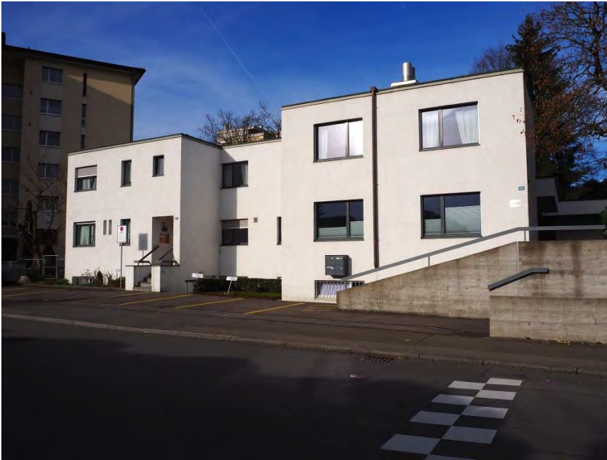
Kath. Kirche St. Josef, Pfarr- und Sigristenhaus (Vers. Nr. 02465), Ansicht von NO, 05.04.2018 (Bild Nr. D100592_04)
