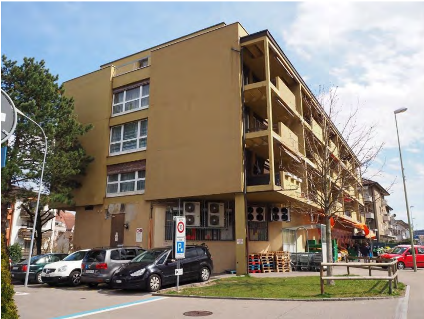
Wohn- und Geschäftshaus, Ansicht von W, 05.04.2018 (Bild Nr. D100538_43)
