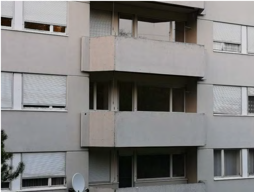
Überbauung «Halde», Hochhaus (Vers. Nr. 01573), Südfassade (Detail), 01.01.1988 (Bild Nr. D101149_03)
