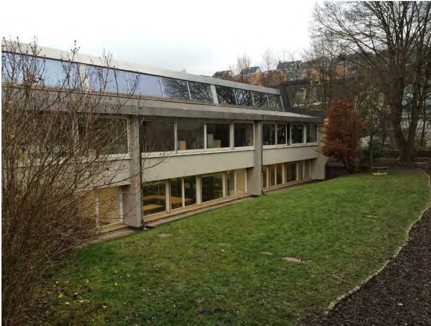
Schulhaus Reppisch, Pavillon B, Ansicht von S, 08.12.2014 (Bild Nr. D100657_16)
