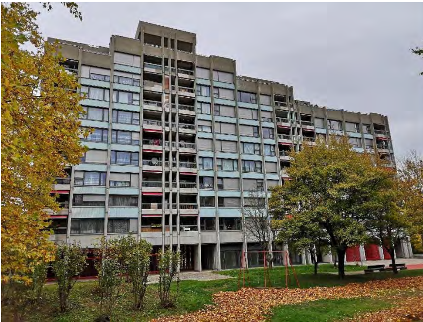
Wohnhochhäuser, Block II (Vers. Nr. 01693), Ansicht von S, 31.10.2018 (Bild Nr. D101149_86)
