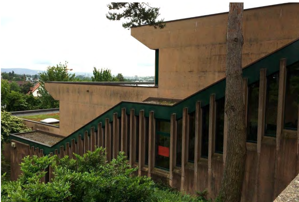
Schulhaus Büel B, Ansicht von N, 28.05.2014 (Bild Nr. D100661_09)
