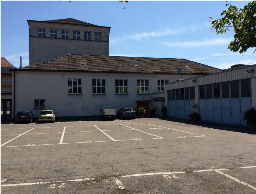
Zentralschulanlage, Turnhalle II (243TURNHALLE01505), Ansicht von NW, 05.08.2015 (Bild Nr. D101131_04)
