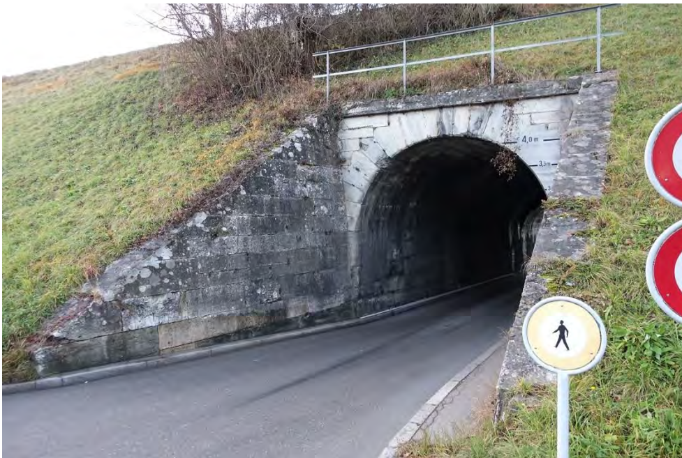
Unterführung Bahndamm, Ansicht von SO, 11.12.2017 (Bild Nr. D101141_41)
