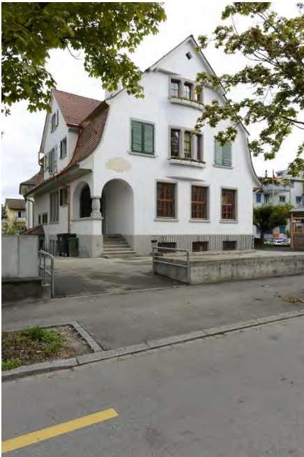
Kindergarten sog. «Nähüsli», Ansicht von SW, 21.08.2016 (Bild Nr. D101521_22)
