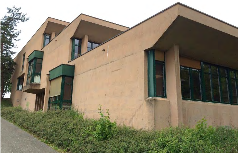
Schulhaus Büel B, Ansicht von S, 28.05.2014 (Bild Nr. D100661_12)
