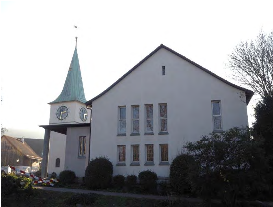
Ref. Kirche St. Agatha mit ehem. Militärbunker, neue Kirche von 1936/1937 (247BEI00294), Ansicht von NO, 08.12.2017 (Bild Nr. D100591_03)
