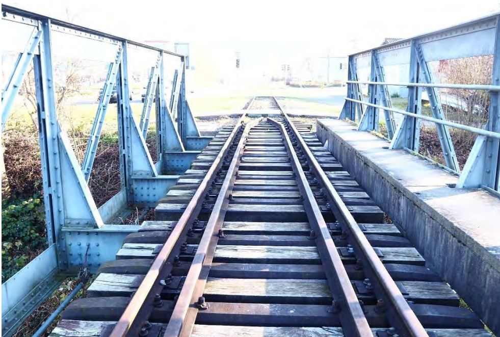
Eisenbahnbrücke, aus Holzschwellen bestehende Fahrbahn, rechts der vermutlich jüngere, mit Betonplatten belegte Servicesteg, 16.06.2014 (Bild Nr. P1011822)
