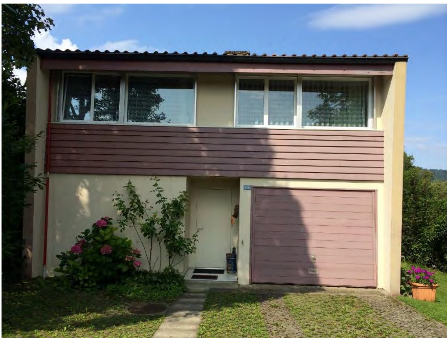
Wohnhausgruppe Windhalb, Wohnhaus Nr. 138 (Vers. Nr. 01993), Ansicht von O, 01.09.2014 (Bild Nr. D100658_17)
