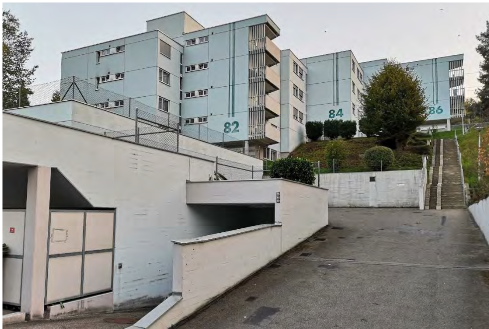
Überbauung «Halde», Kettenhaus (Vers. Nr. 01561), Ansicht von NW, im Vordergrund Bauten des gemeinsamen Sockelgeschosses, 20.10.2018 (Bild Nr. D101148_72)
