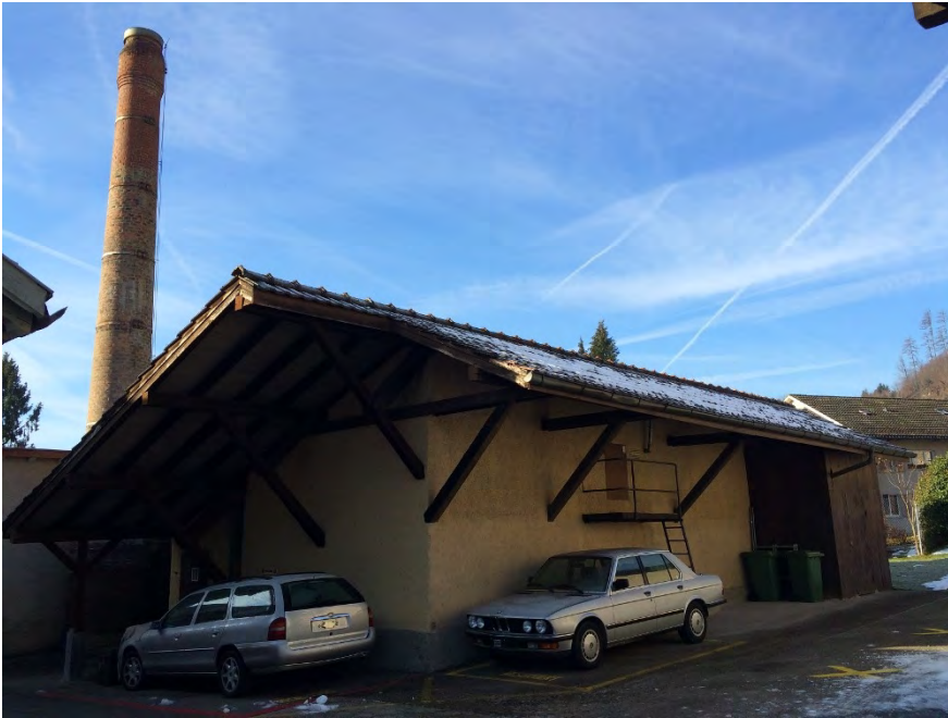
Ehem. Glühlampenfabrik, Dampfkesselhaus mit Hochkamin (Vers. Nr. 00353), Ansicht von NO, 06.01.2015 (Bild Nr. D100657_52)
