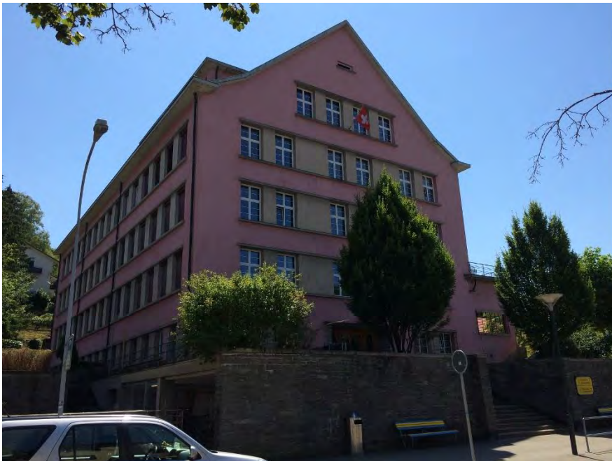
Primarschulanlage Schulstrasse, Rotes Schulhaus (Vers. Nr. 00802), Ansicht von NO, 12.06.2014 (Bild Nr. D101131_93)
