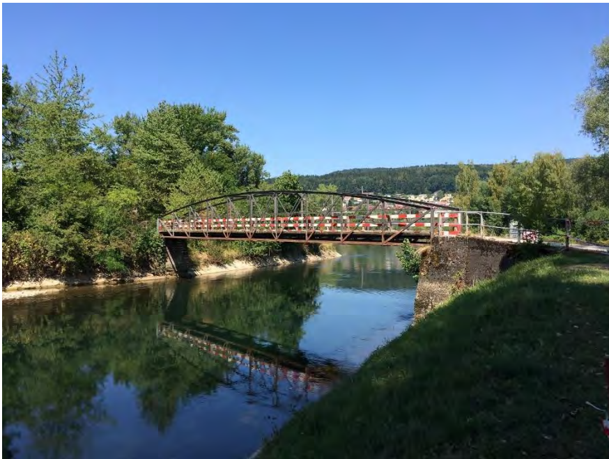
Reppischbrücke, Unterlauf (Mündung in Limmat), Ansicht Gesamt von SW, 05.08.2015 (Bild Nr. D100662_57)
