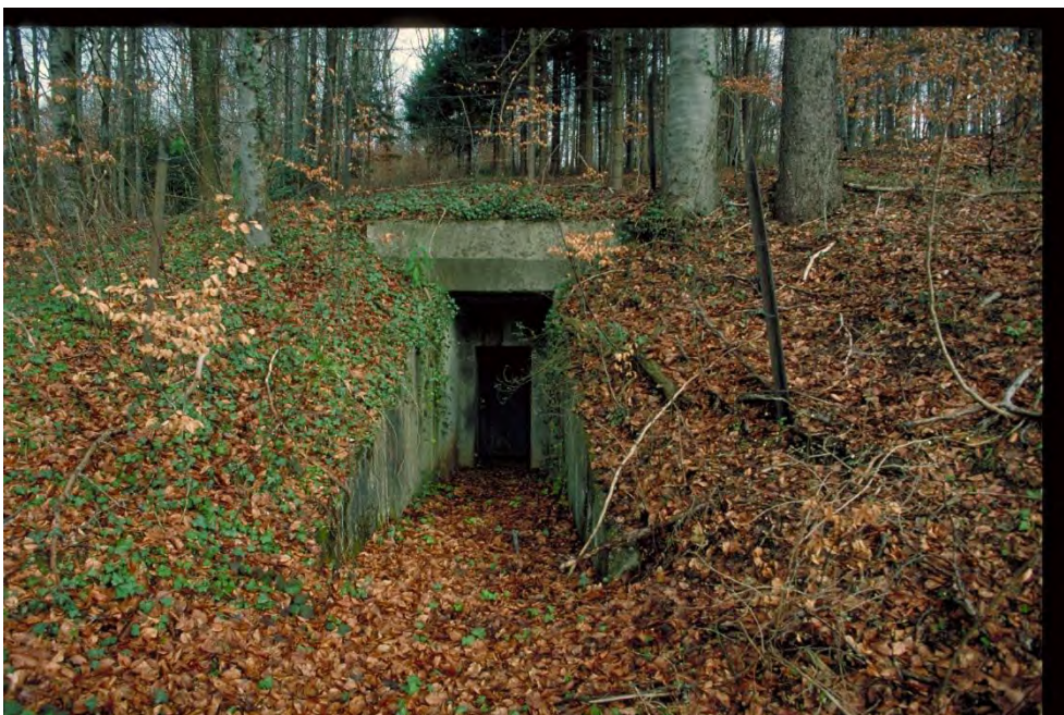
Sperrstelle 5053, Zugsunterstand A04931, 19.03.1998 (Bild Nr. D100538_79).
