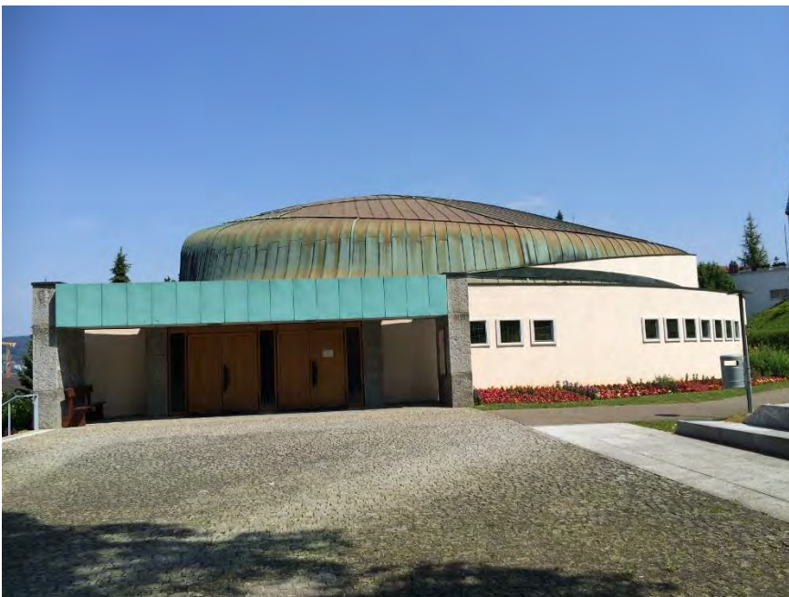
Kath. Kirche St. Josef, Kirchengebäude (Vers. Nr. 01340), Ansicht von S, 10.03.2015 (Bild Nr. D100667_82)
