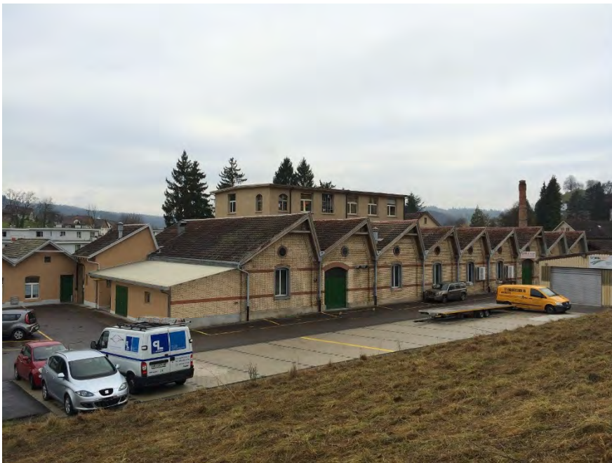
Ehem. Glühlampenfabrik, Ansicht von NO, 08.12.2014 (Bild Nr. D100657_36)
