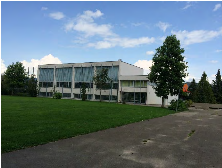
Primarschulanlage Fondli, Turnhalle (Vers. Nr. 02418), Ansicht von S, 05.08.2014 (Bild Nr. D100657_75)
