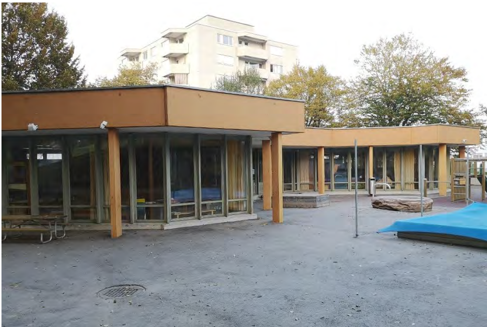
Überbauung «Halde», Kindergarten (Vers. Nr. 01560), Ansicht von SW, 20.10.2018 (Bild Nr. D101148_56)
