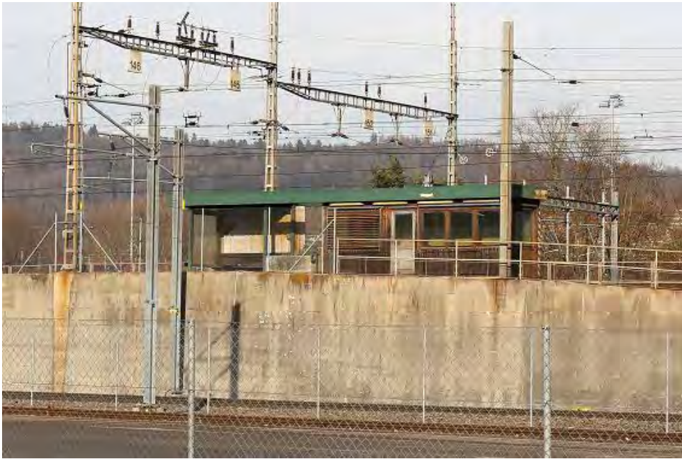
«Schnellgut-Stammbahnhof» Zürich Altstetten, Bergmeisterposten (247BERGME0001), Ansicht von S, 25.10.2018 (Bild Nr. D101353_28).
