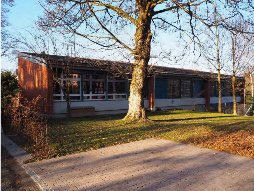
Primarschulanlage Hofacker, Schulpavillon 2 (Vers. Nr. 1255), Ansicht von SO, 07.12.2017 (Bild Nr. D101131_56)
