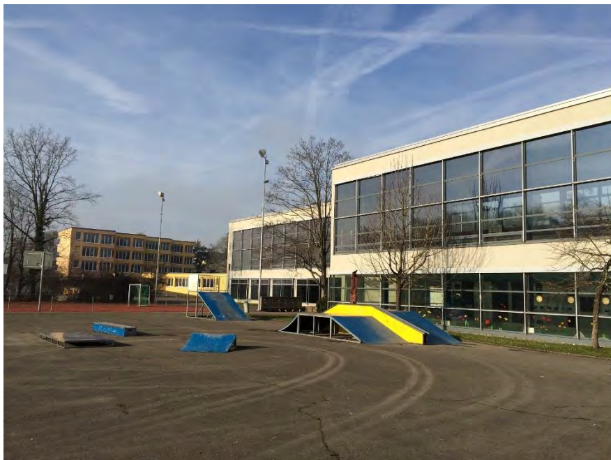
Oberstufenschulanlage Allmend und Sportzentrum Brunewiis, Gesamtansicht von SO, 06.01.2015 (Bild Nr. D100659_88)
