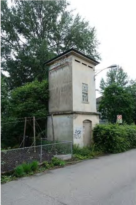
Transformatorstation, Ansicht von SW, 13.06.2018 (Bild Nr. D101085_32)
