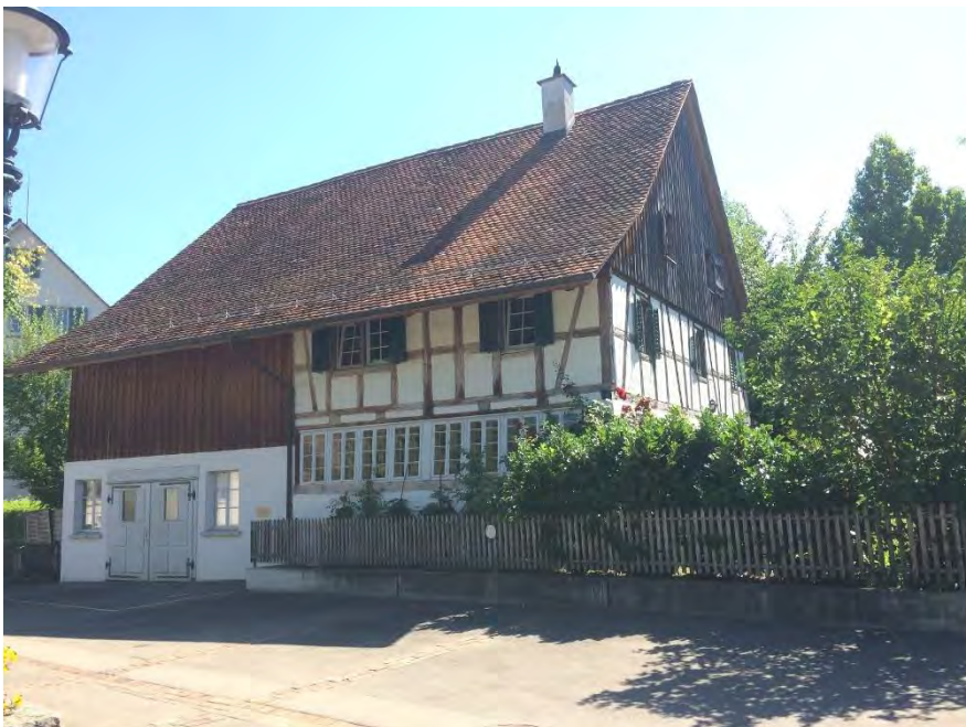
Vielzweckbauernhaus, sog. «Felchlinhaus», Ansicht von SW, 08.08.2016 (Bild Nr. D100665_01)
