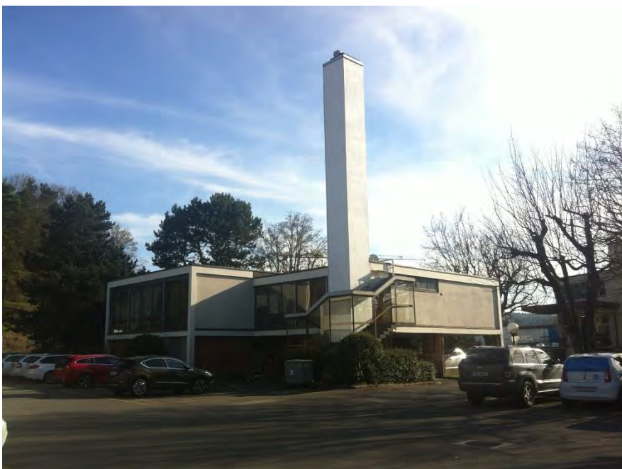
Ehem. Kantine der Siemens EAG, Ansicht von N, 20.03.2014 (Bild Nr. D100667_58)
