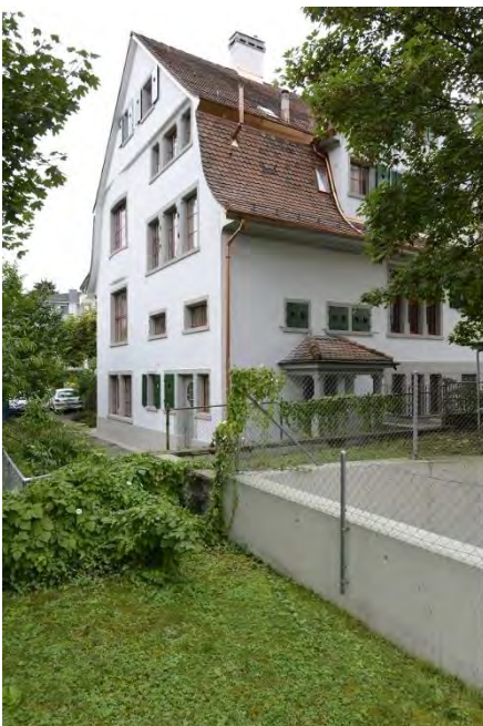
Kindergarten sog. «Nähüsli», Ansicht von W, 21.08.2016 (Bild Nr. D101521_39)
