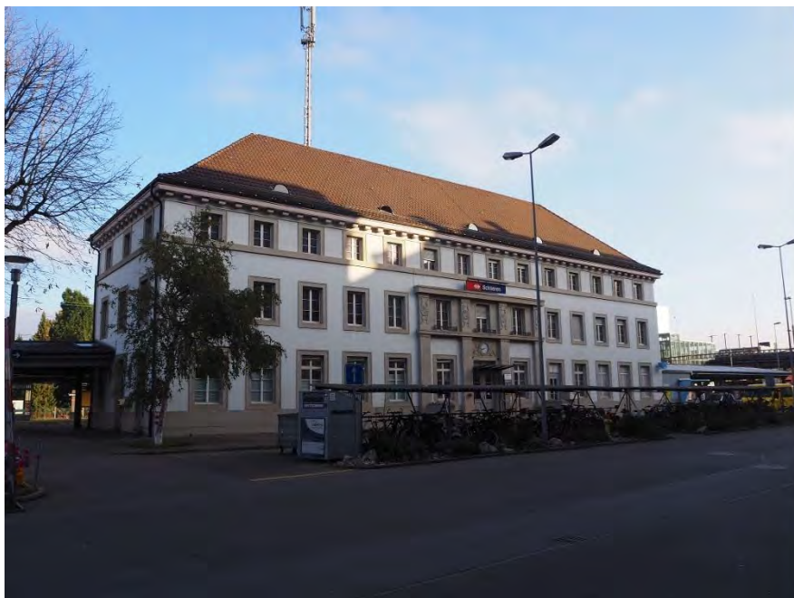
Bahnhof Schlieren, Aufnahmegebäude (Vers. Nr. 00113), Ansicht von SW, 07.12.2017 (Bild Nr. D101086_04)
