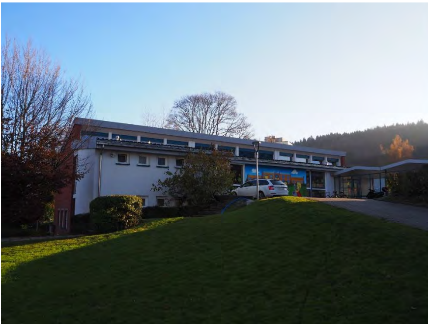
Primarschulanlage Hofacker, Schulpavillon 1 (Vers. Nr. 1254), Ansicht von NW, 07.12.2017 (Bild Nr. D101131_51)
