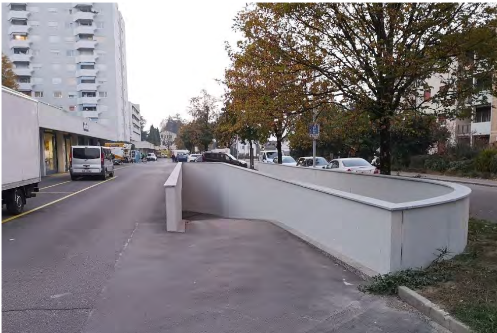
Überbauung «Halde», Umgebungsgestaltung (247UMGEBU01550), Tiefgaragenein- und ausfahrt auf dem Vorplatz des Sockelgeschosses, Ansicht von O, 20.10.2018 (Bild Nr. D101148_97)
