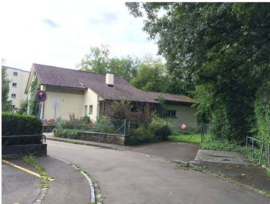
Kindergarten Max-Müller-Strasse, Ansicht von NW, 05.08.2014 (Bild Nr. D100658_36)
