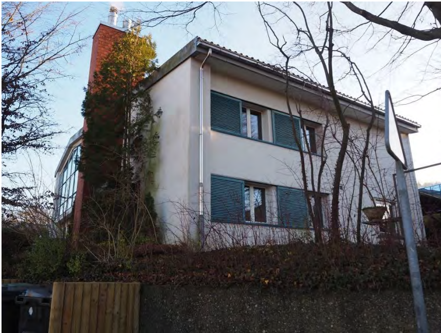
Primarschulanlage Hofacker, Mehrzwecktrakt (Vers. Nr. 01253), Ansicht von NW, 07.12.2017 (Bild Nr. D101131_67)
