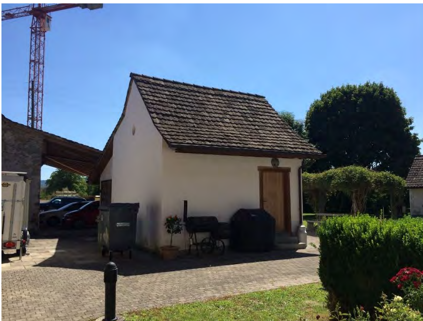
Weinbauernhaus mit Waschhaus, Waschhaus (Vers. Nr. 00158), Ansicht von N, 08.08.2016 (Bild Nr. D100665_22)
