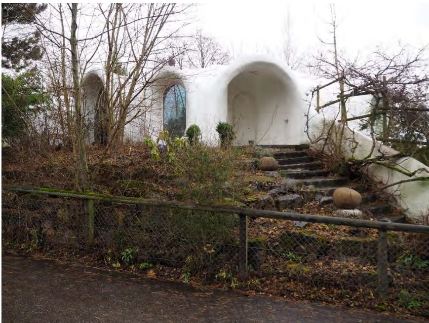
Wohnhaus, Ansicht von S, 22.01.2018 (Bild Nr. D101085_22)
