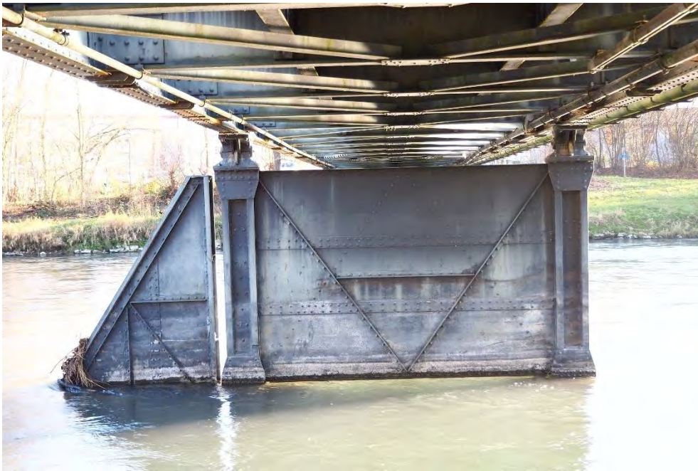
Eisenbahnbrücke, Flusstütze (Detail), 01.01.2015 (Bild Nr. D101148_02)
