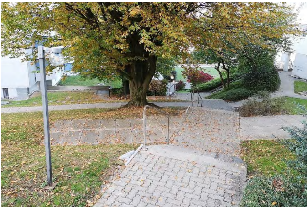
Überbauung «Halde», Umgebungsgestaltung (247UMGEBU01550), Wegsystem auf Kat. Nr. 7210 beim Kettenhaus (Vers. Nr. 01561) mit bauzeitlichen Ausstattungselementen (Leuchten, Betonplatten, Verbundsteine, Treppenelemente, Handläufe usw.), 20.10.2018 (Bild Nr. D101148_95)
