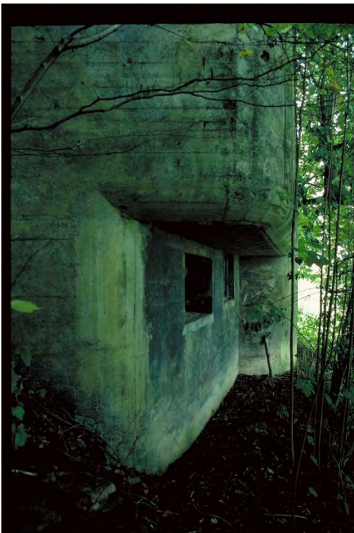
Sperrstelle 5050, Geschützstand A05207, 23.09.1997 (Bild Nr. D100538_92).
