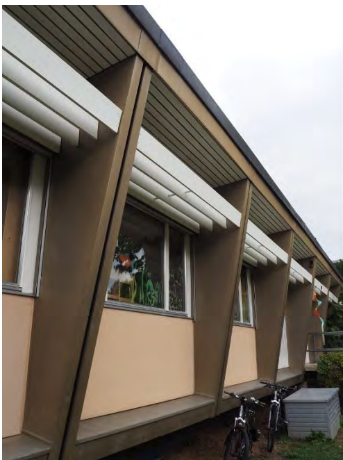
Kindergarten Wolfsmatt, Ansicht von SW, 06.10.2017 (Bild Nr. D101085_12)
