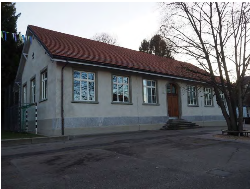
Primarschulanlage Schulstrasse, Turnhalle (Vers. Nr. 00367), Ansicht von N, 07.12.2017 (Bild Nr. D100659_72)
