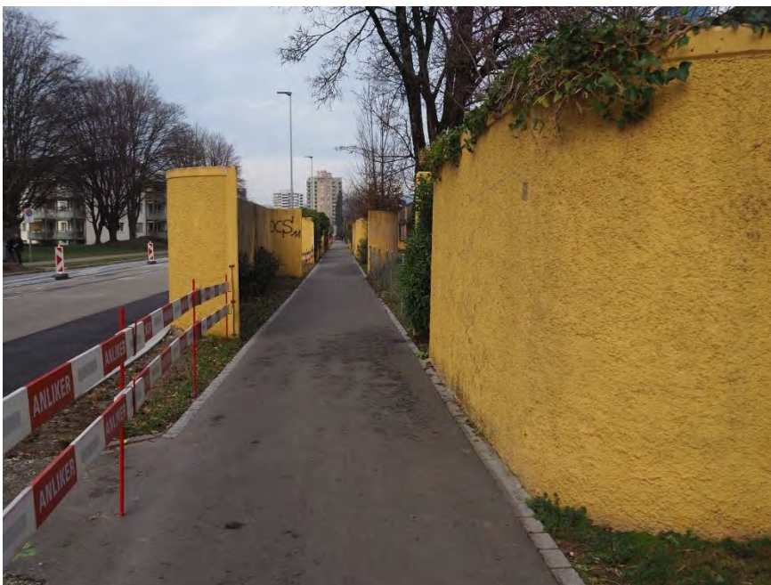
Oberstufenschulhaus Moosmatt, Umgebungsgestaltung (250UMGEBUNG01162), von Mauern flankiertes Trottoir, 11.01.2018 (Bild Nr. D100669_24)
