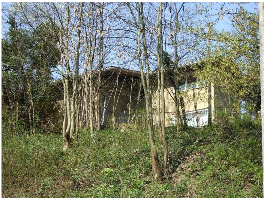
Atelierhaus Gubler, Ansicht von SO, 15.07.2014 (Bild Nr. D100663_33)
