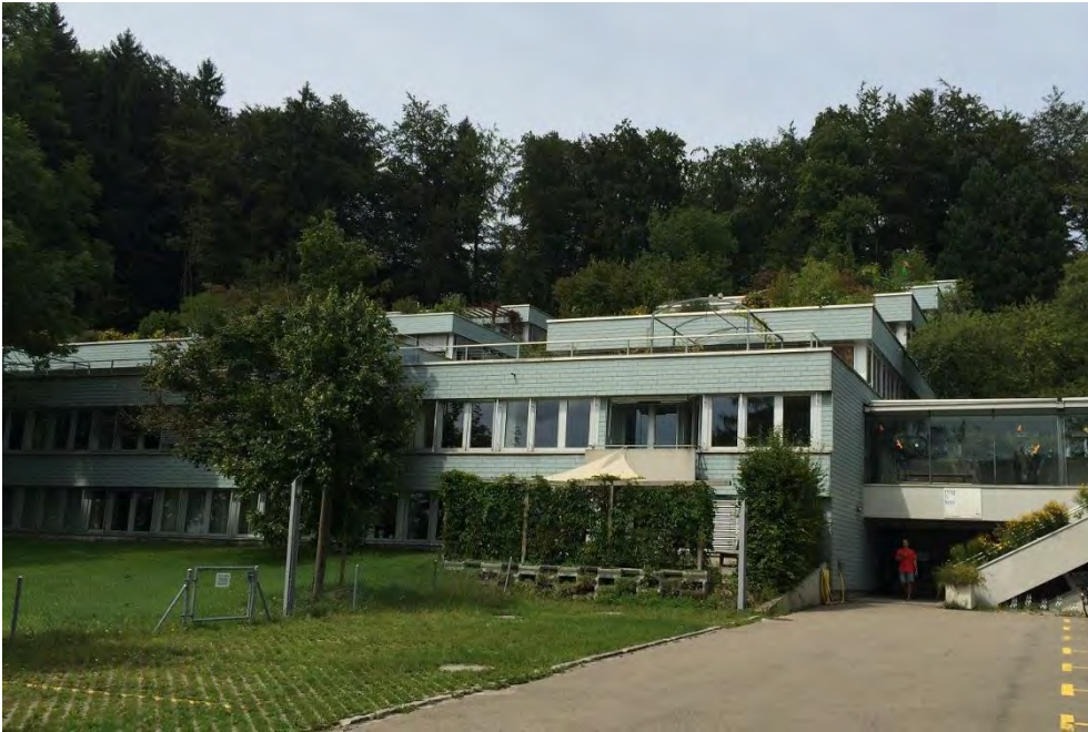
Schulinternat Ringlikon, Wohn- und Verwaltungsbau (Vers. Nr. 00668), Ansicht von SO, 12.08.2014 (Bild Nr. D100660_09)
