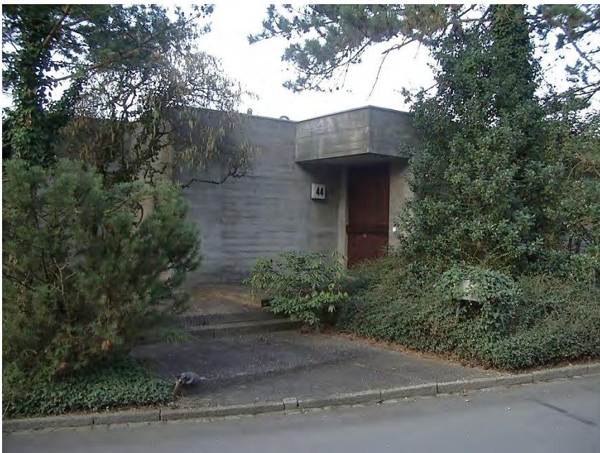
Architekteneigenheim, Ansicht von NO, 06.01.2014 (Bild Nr. D100667_43)
