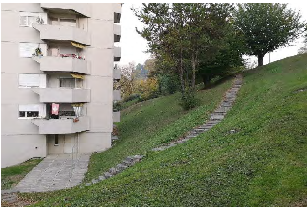
Überbauung «Halde», Hochhaus (Vers. Nr. 01573), Südwestecke und Umgebungsgestaltung (247UMGEBU01550), 01.01.1988 (Bild Nr. D101149_04)
