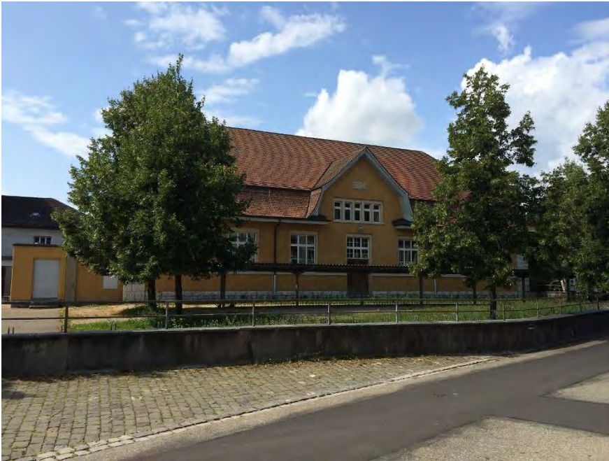
Zentralschulanlage, Turnhalle I (243ALT00769), Ansicht von NO, 05.08.2014 (Bild Nr. D100658_97)
