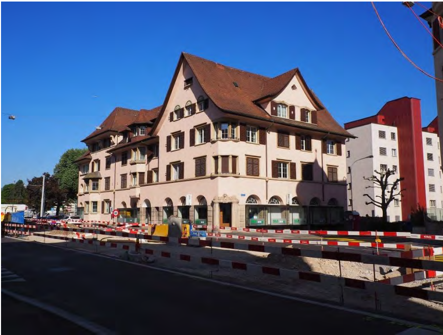
Angestelltenwohnhäuser, Ansicht von SO, 12.06.2014 (Bild Nr. D100538_31)
