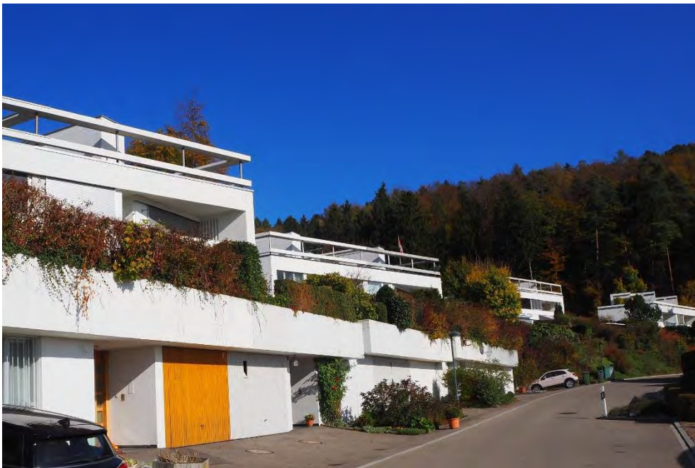
Wohnhäuser im Büel, Ansicht von SW, 01.11.2017 (Bild Nr. D101089_02)
