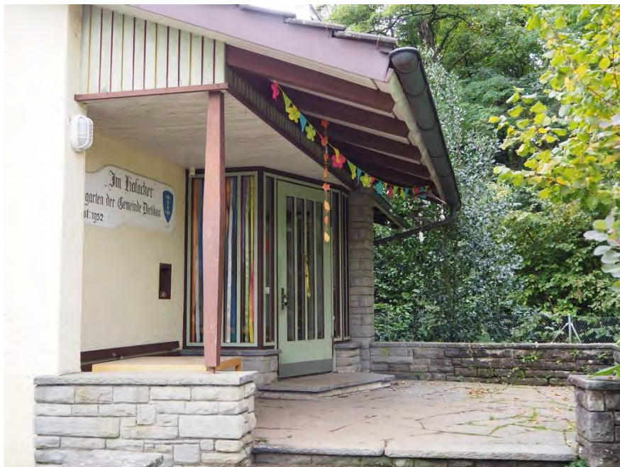
Kindergarten Max-Müller-Strasse, Eingangsbereich, 06.10.2017 (Bild Nr. D101132_84)
