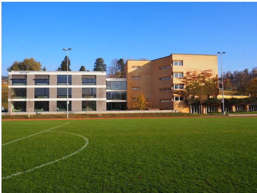
Oberstufenschulanlage Allmend und Sportzentrum Brunewiis, Schulzimmertrakt (Vers. Nr. 00675) mit Neubau, Ansicht von S, 31.10.2017 (Bild Nr. D100665_80)
