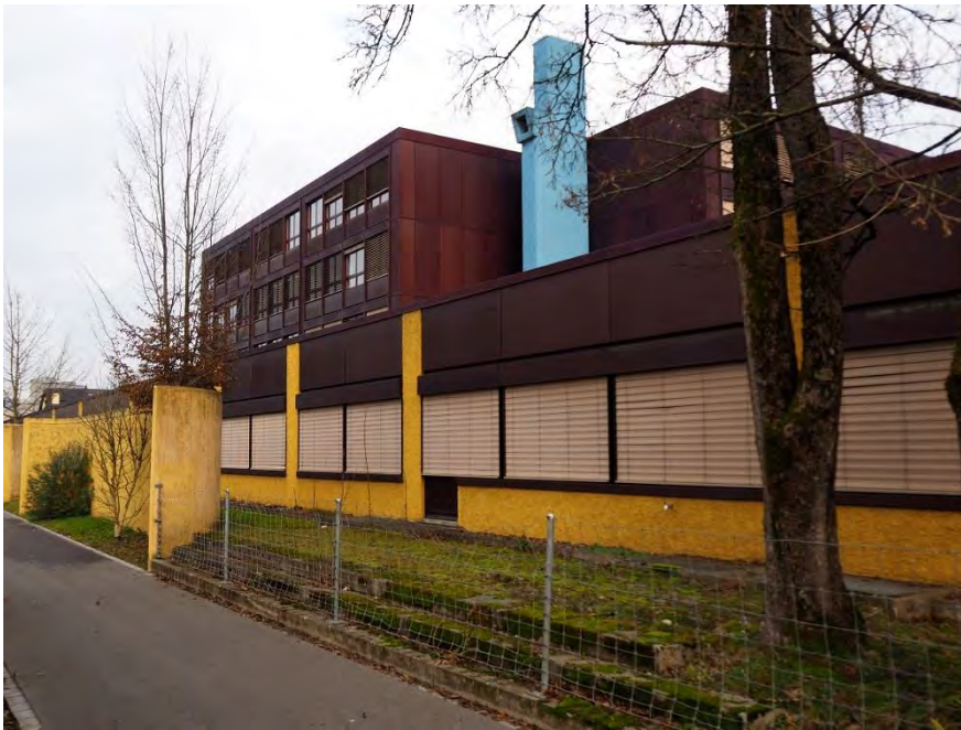
Oberstufenschulhaus Moosmatt, Ansicht von SW, im Vordergrund Verbindungstrakt mit Handarbeits- und Werkräumen, 11.01.2018 (Bild Nr. D100669_25)
