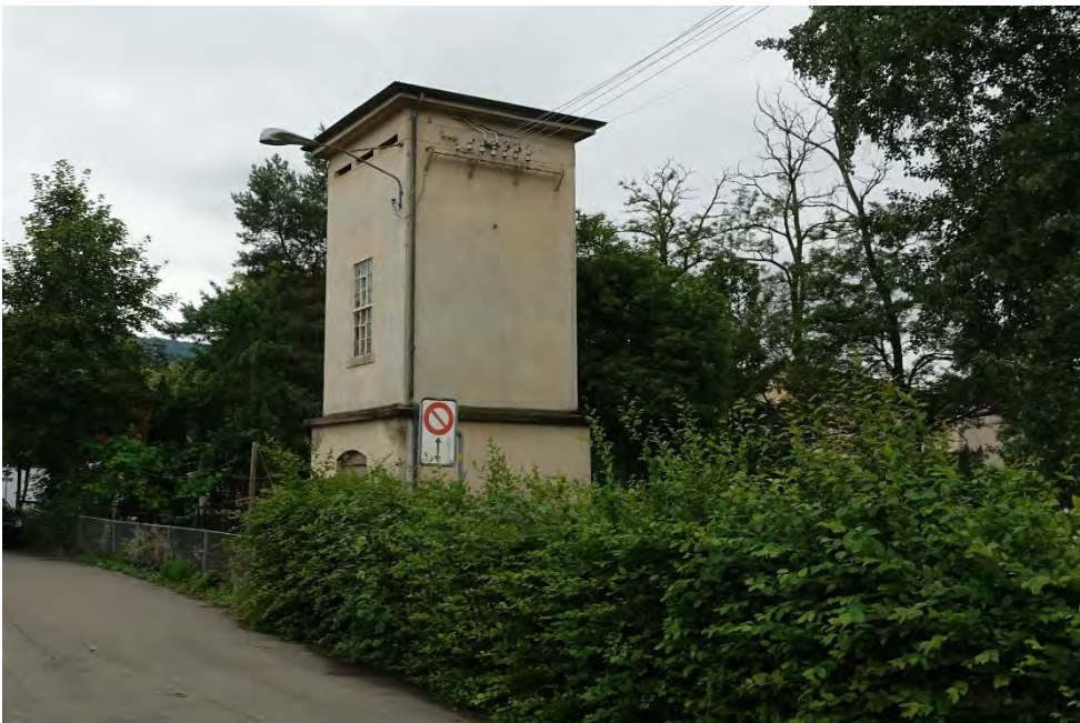
Transformatorstation, Ansicht von O, 13.06.2018 (Bild Nr. D101085_33)
