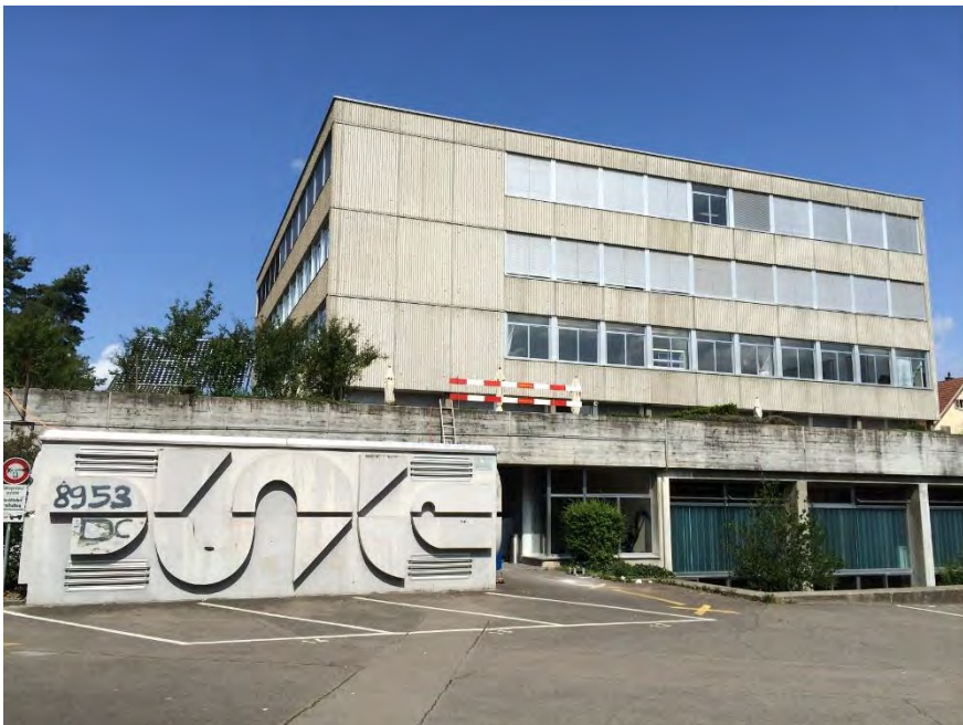
Gewerbeschulhaus, Ansicht von O, 05.08.2014 (Bild Nr. D100658_42)
