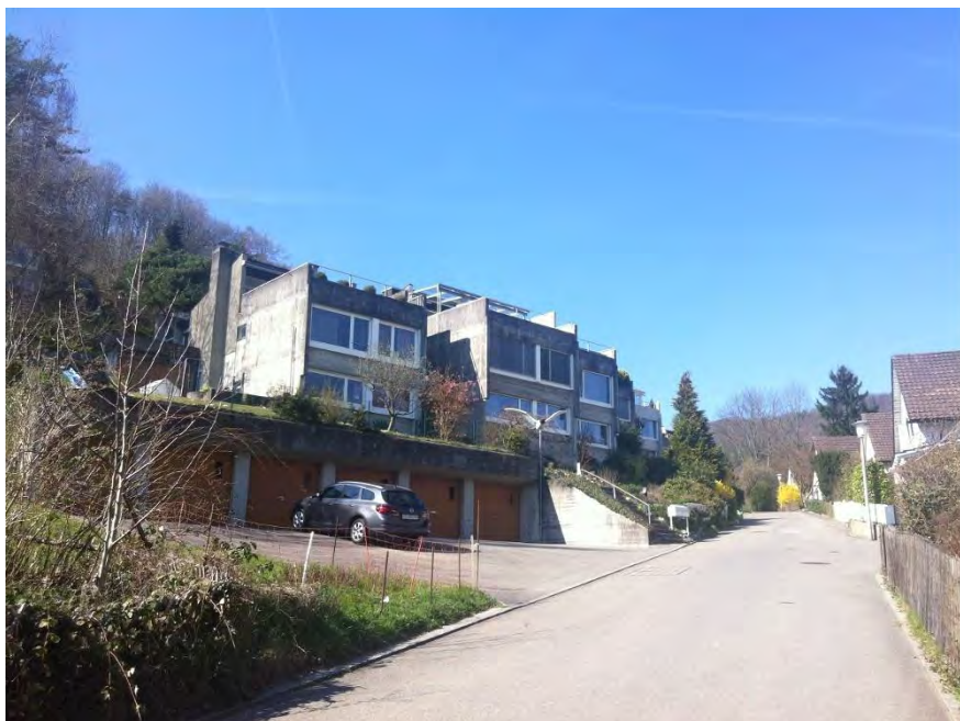
Dozentensiedlung Im Hettler, Wohnhäuser (Vers.Nr. 00580, 00583, 00582) und Garagen (Vers. Nr. 00526, 00624–00628), Ansicht von SO, (Bild Nr. D100666_67)
