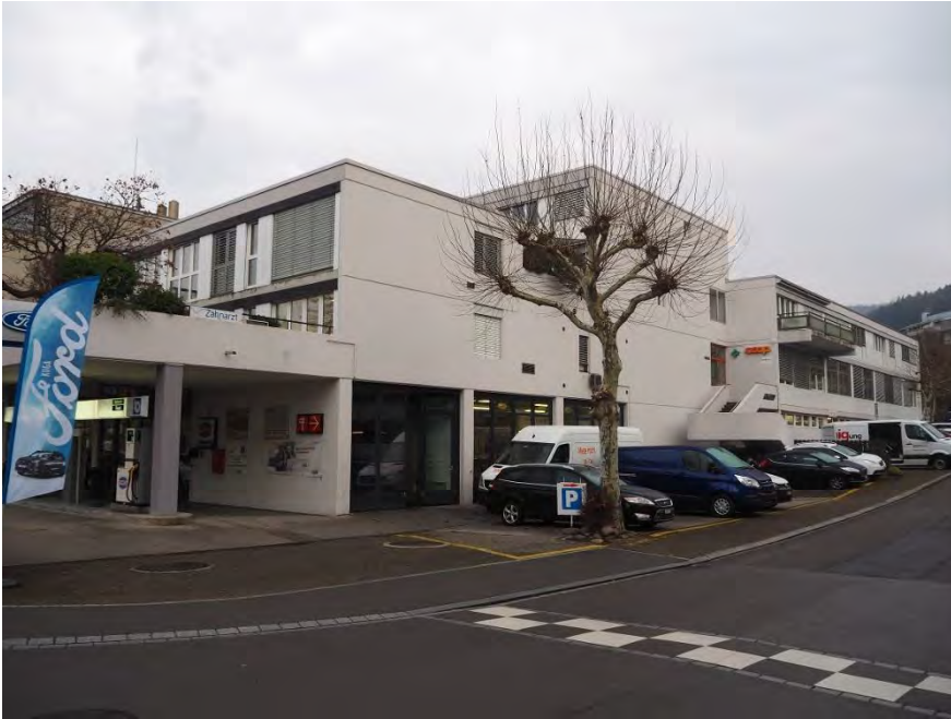
Gemeindezentrum, Wohn- und Geschäftshaus (Vers. Nr. 00250), Ansicht von S, 11.01.2018 (Bild Nr. D101132_01)
