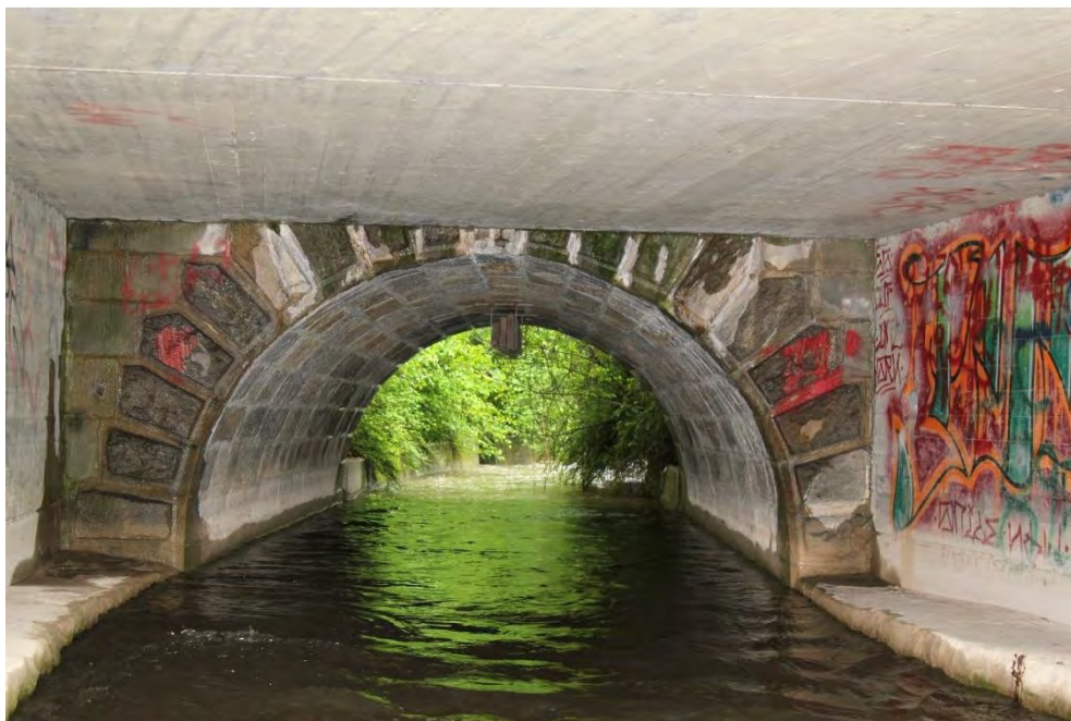
Durchlass Schäflibach, Ansicht von N, 28.04.2017 (Bild Nr. D101085_61)
