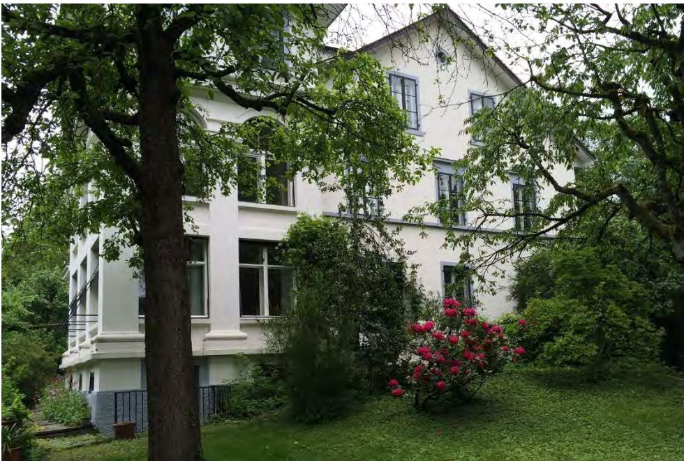
Fabrikantenwohnhaus mit Garten, Ansicht von S, 26.05.2015 (Bild Nr. D101088_13)
