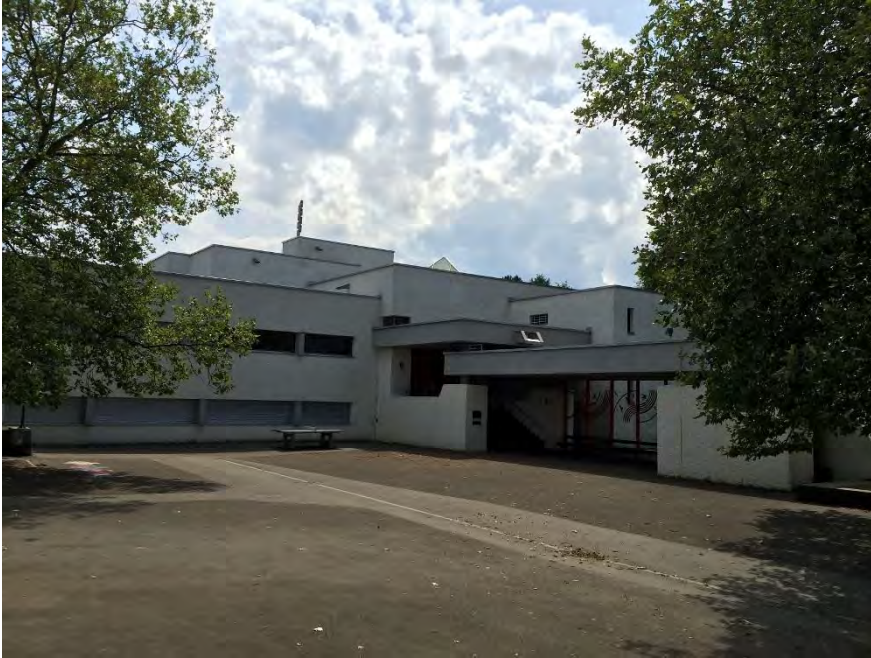
Primarschulanlage Fondli, Klassenzimmertrakt 2 (Vers. Nr. 02385), Ansicht von N, 05.08.2014 (Bild Nr. D100657_90)
