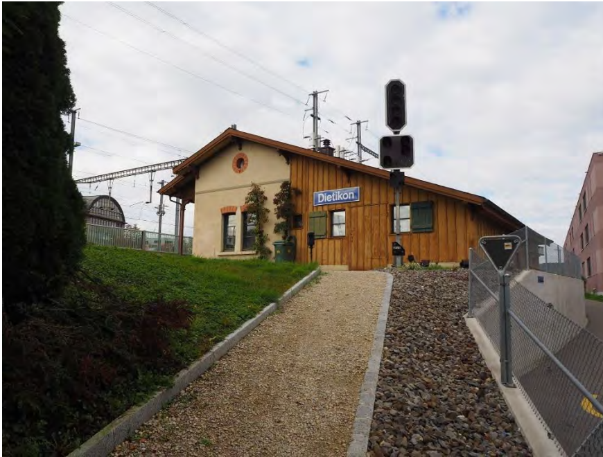
Stationsgebäude, Ansicht von SO, 06.10.2017 (Bild Nr. D100668_31)
