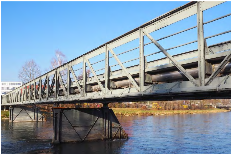
Eisenbahnbrücke, Ansicht von SW, 01.01.2015 (Bild Nr. D101148_04)
