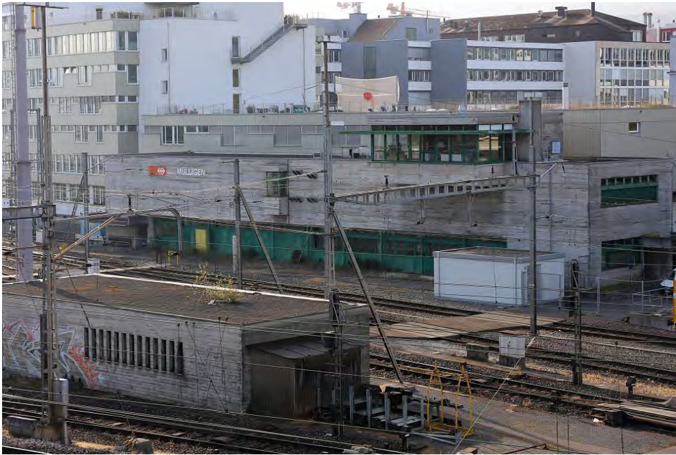
«Schnellgut-Stammbahnhof» Zürich Altstetten, Stellwerk (Vers. Nr. 00080), im Vordergrund das Rangiergebäude (Vers. Nr. 00081), Ansicht von NW, 25.10.2018 (Bild Nr. D101353_20).
