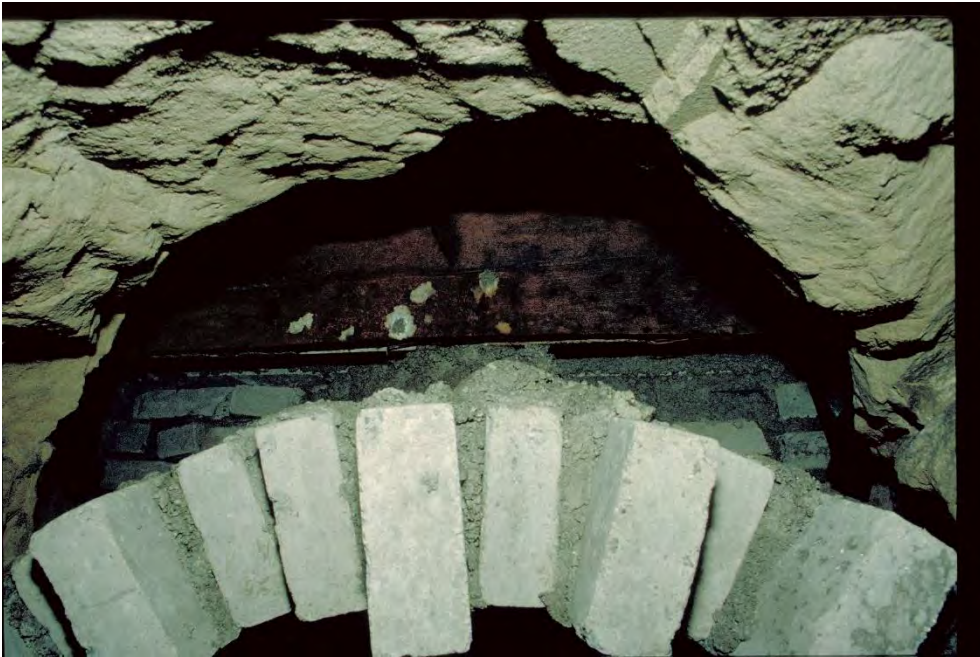
Sperrstelle 5053, Zugsunterstand A04929, 19.03.1998 (Bild Nr. D100538_74).
