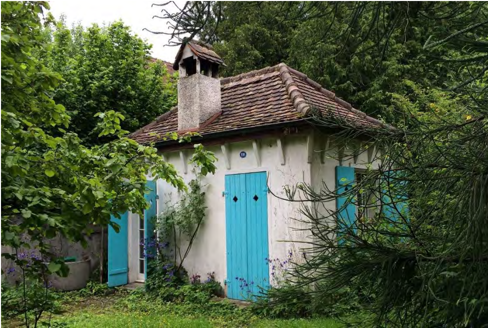
Fabrikantenwohnhaus mit Garten, Gartenhaus (Vers. Nr. 01803), Ansicht von SO, 26.05.2015 (Bild Nr. D101088_08)
