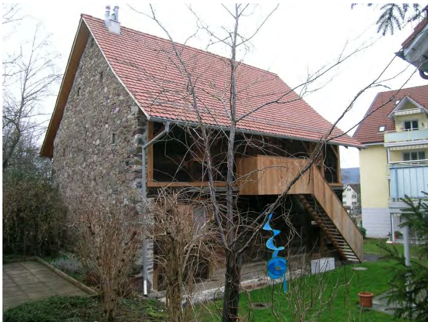
Ehem. Speicher- und Trottbäude, Ansicht von SO, 01.02.2007 (Bild Nr. D101086_52)
