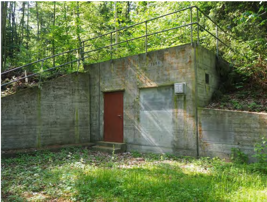
Reservoirensemble Lölmoos, Reservoir und Schieberhaus Lölmoos 3 (247Reservoir00003), Ansicht von N, 08.05.2018 (Bild Nr. D100677_17)
