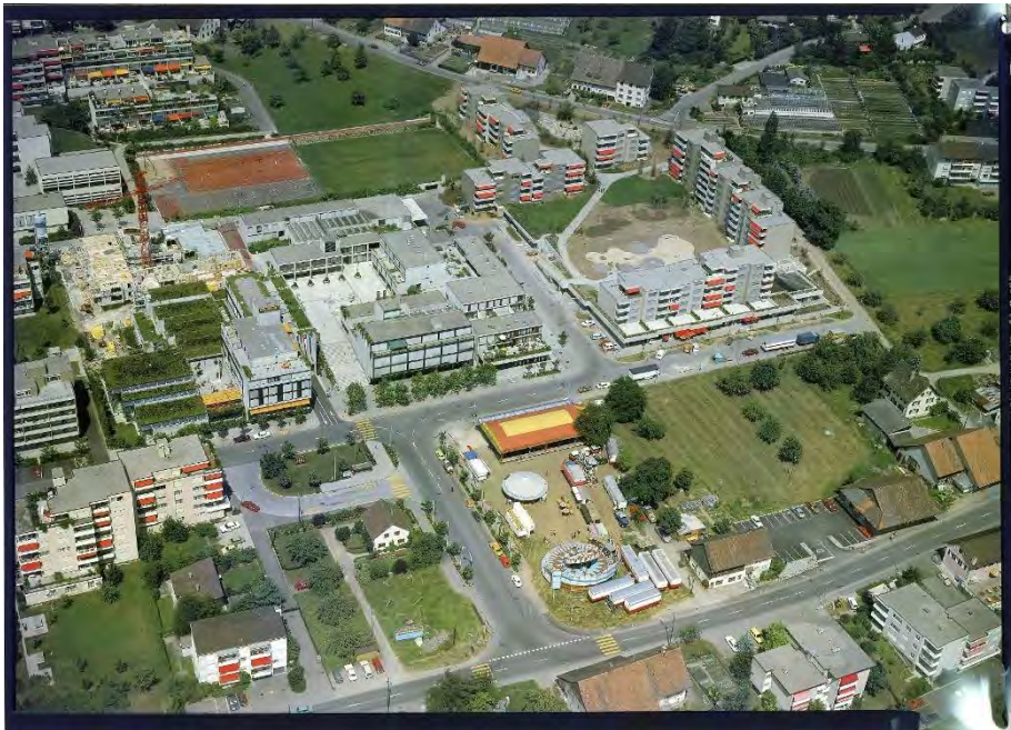
Gemeindezentrum, Luftaufnahme Gesamtanlage im Bau, 01.01.1976 (Bild Nr. D100655_30)
