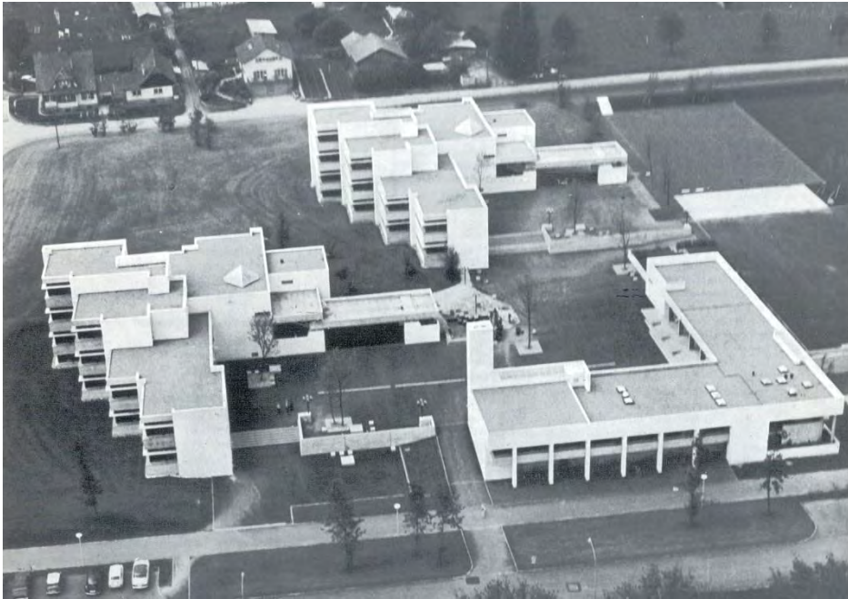
Primarschulanlage Fondli, Luftaufnahme Klassentrakte (Vers. Nr. 02384, 02385) und Spezialtrakt (Vers. Nr. 02386), Ansicht von NO, 01.01.1967 (Bild Nr. D100665_60)
