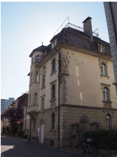
Mehrfamilienwohnhaus «Römerschlössli», Ansicht von NW, 08.05.2018 (Bild Nr. D100677_09)
