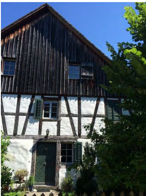
Vielzweckbauernhaus, sog. «Felchlinhaus», Ansicht von S, 08.08.2016 (Bild Nr. D100665_07)
