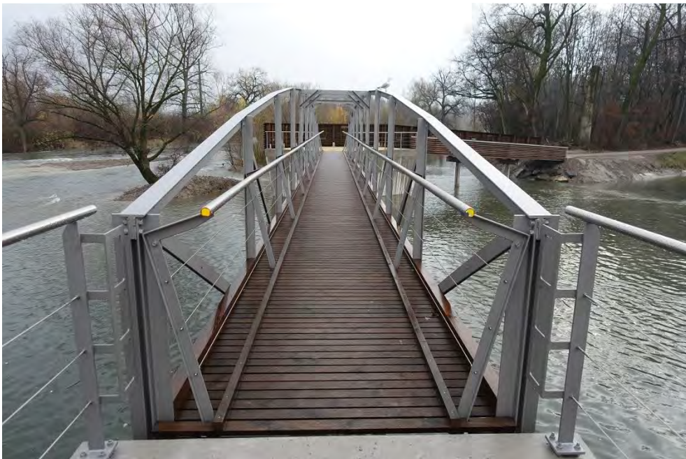
Reppischbrücke, Unterlauf (Mündung in Limmat), Ansicht von NW, 06.12.2018 (Bild Nr. D101093_00)
