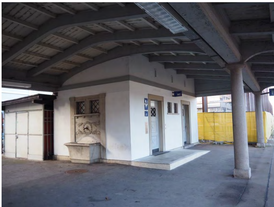
Bahnhof Schlieren, WC-Gebäude (247WC00113) mit Perronüberdachung, Ansicht von NO, 07.12.2017 (Bild Nr. D101086_03)
