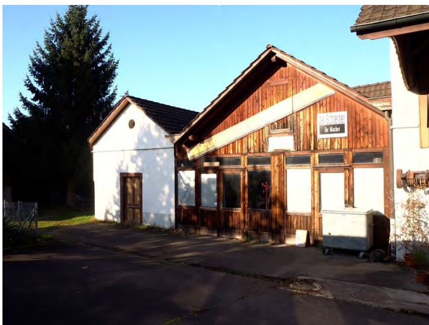
Hofgruppe Badenerstrasse, Ehem. Waschhaus (247WASCH00144), Ansicht von SO, 07.12.2017 (Bild Nr. D101086_14)
