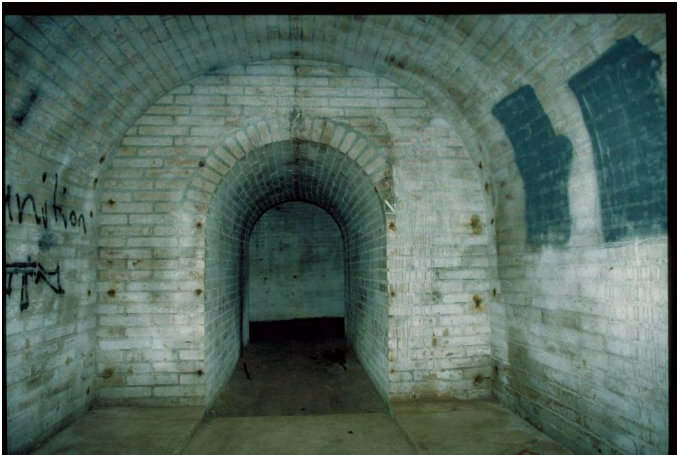
Sperrstelle 5053, Zugsunterstand A04930, 19.03.1998 (Bild Nr. D100538_78).
