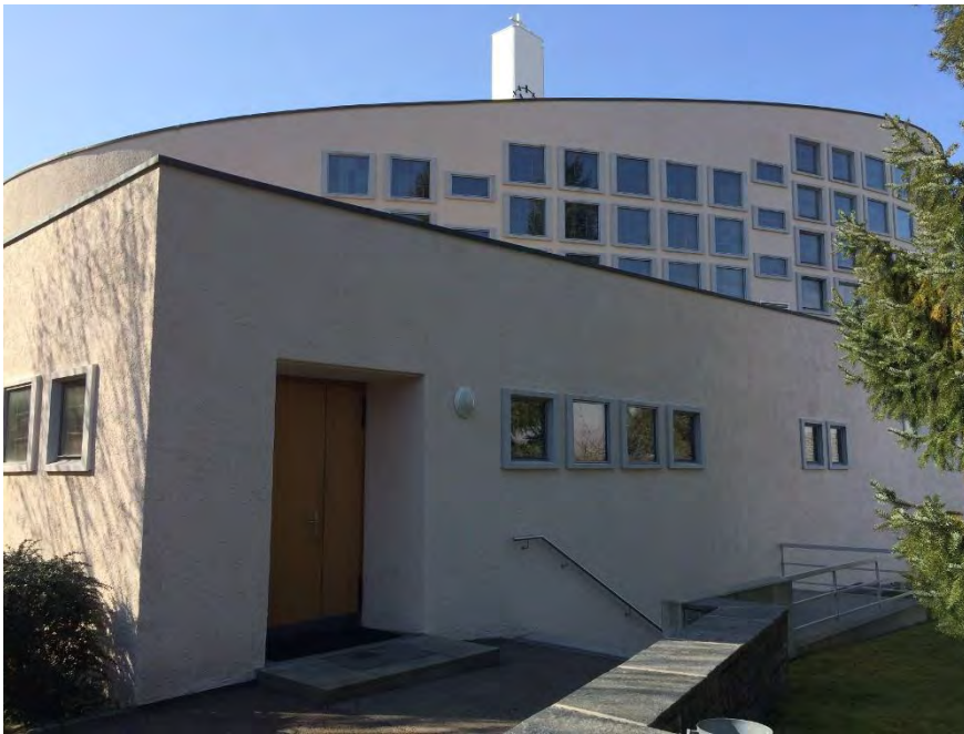
Kath. Kirche St. Josef, Kirchengebäude (Vers. Nr. 01340), Ansicht von NO, 10.03.2015 (Bild Nr. D100667_83)
