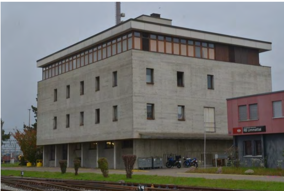
Rangierbahnhof Limmattal, Stellwerk Ost (Vers. Nr. 00377), Ansicht von SO, 20.10.2017 (Bild Nr. D101088_36)
