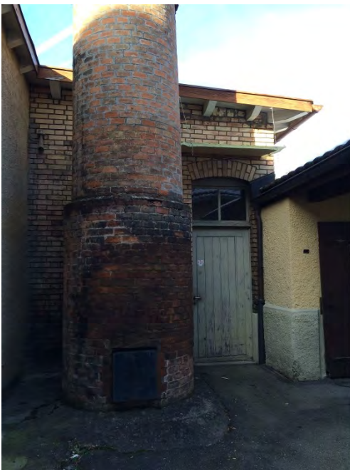
Ehem. Glühlampenfabrik, Dampfkesselhaus mit Hochkamin (Vers. Nr. 00353), Ansicht von NO, 06.01.2015 (Bild Nr. D100657_55)
