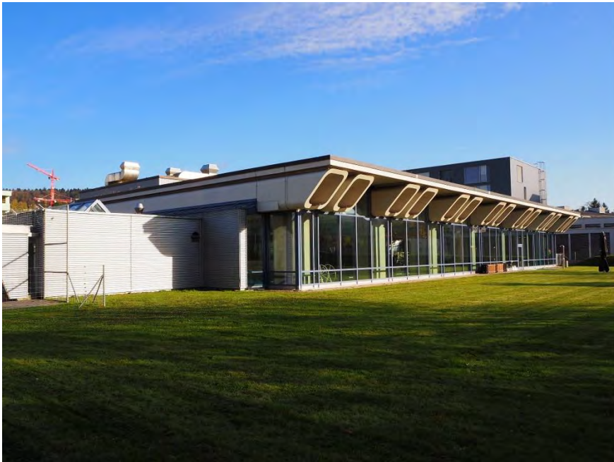
Sport- und Schwimmhalle, Westfassade, Ansicht von NW, 31.10.2017 (Bild Nr. D101618_20)
