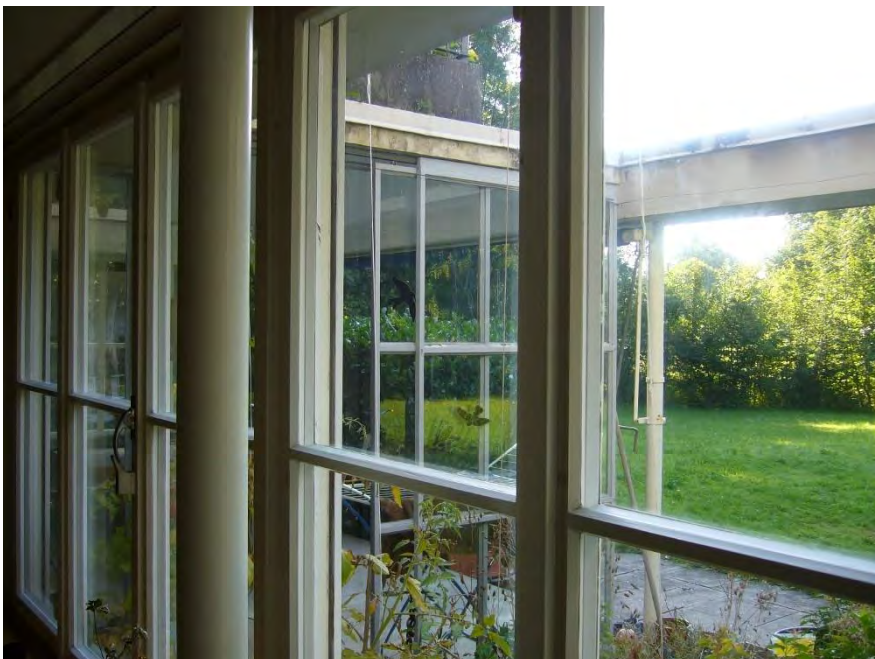
Haus Korkstein AG, Blick vom Esszimmer auf die Terrasse, 31.08.2011 (Bild Nr. D101131_25)
