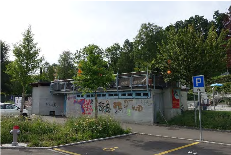
Freibad Im Moos, Ehem. Filtergebäude (Vers. Nr. 02132), Ansicht von NW, 27.05.2018 (Bild Nr. D101086_88)
