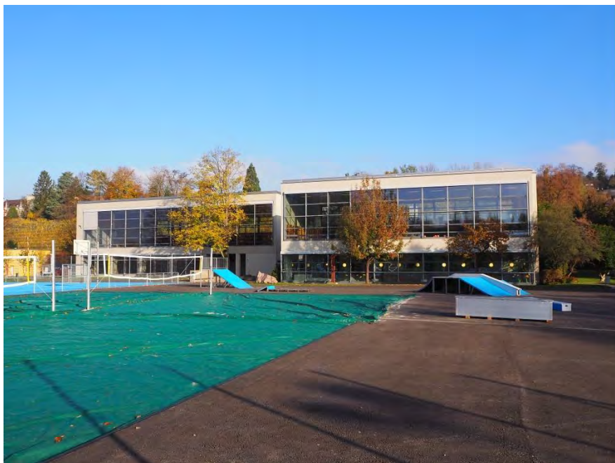
Oberstufenschulanlage Allmend und Sportzentrum Brunewiis, Sportzentrum mit Abwartwohnung (Vers. Nr. 00604), Ansicht von S, 31.10.2017 (Bild Nr. D100665_83)
