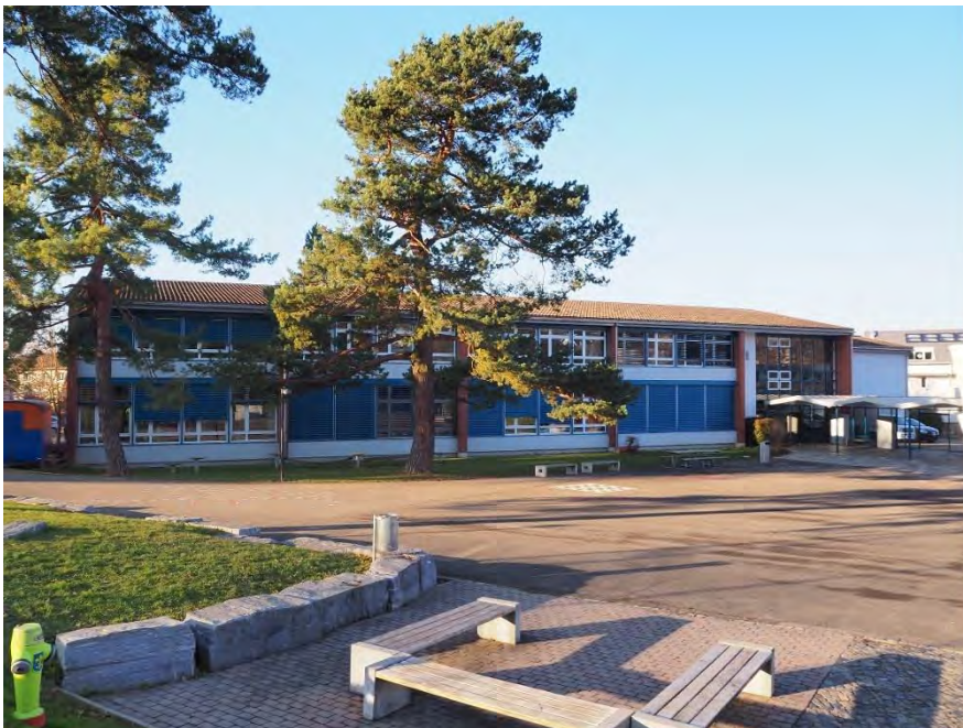
Primarschulanlage Hofacker, Mehrzwecktrakt (Vers. Nr. 01253), Ansicht von SO, 07.12.2017 (Bild Nr. D101131_65)
