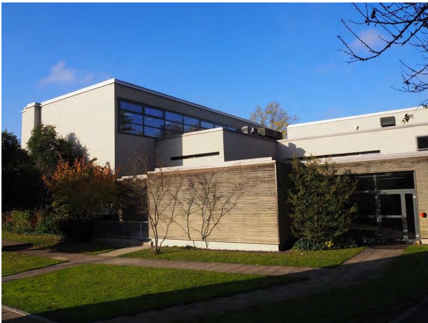
Oberstufenschulanlage Allmend und Sportzentrum Brunewiis, Sportzentrum mit Abwartwohnung (Vers. Nr. 00604), Ansicht von NO, 31.10.2017 (Bild Nr. D100659_90)
