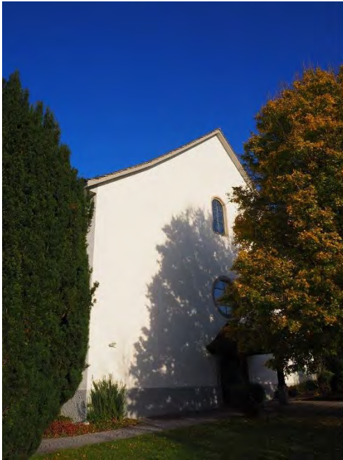
Ref. Kirche St. Martin, Südwestfassade, Ansicht von SW, 31.10.2017 (Bild Nr. D101131_71)
