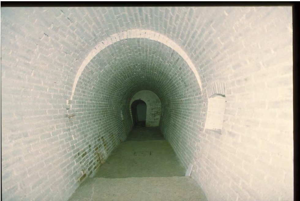
Sperrstelle 5053, Zugsunterstand A04929, 19.03.1998 (Bild Nr. D100538_75).
