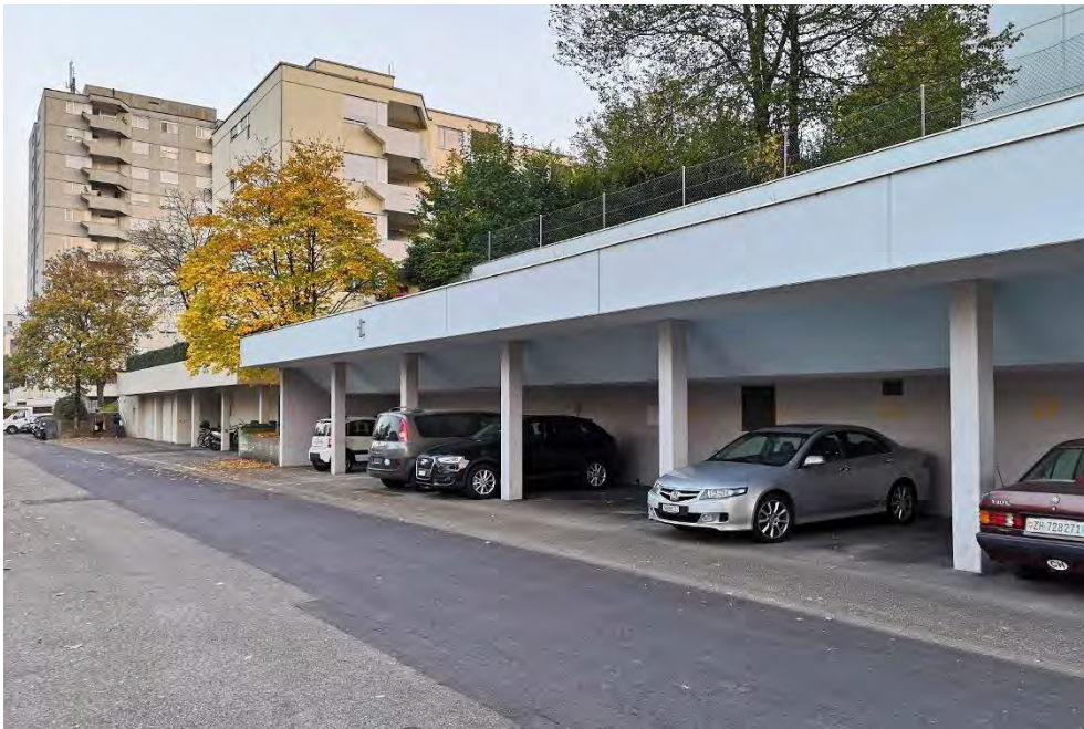
Überbauung «Halde», Umgebungsgestaltung (247UMGEBU01550), teilweise gedeckte Parkplätze im gemeinsamen Sockelgeschoss, 20.10.2018 (Bild Nr. D101148_96)
