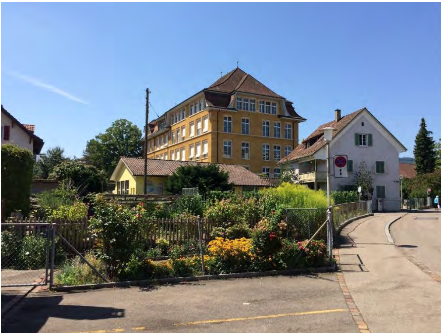
Zentralschulanlage, Schulhaus I (243ZUSA01505), Ansicht von NO, 05.08.2015 (Bild Nr. D101132_72)
