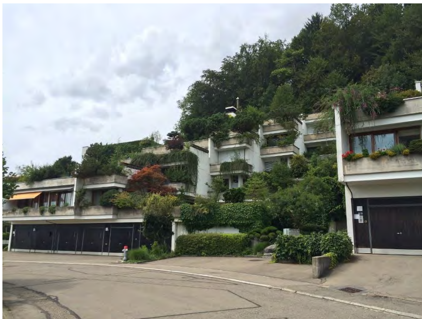
Terrassenhaussiedlung Chilacher, Block 2 und 3, Ansicht von SO, 13.08.2014 (Bild Nr. D101140_25)
