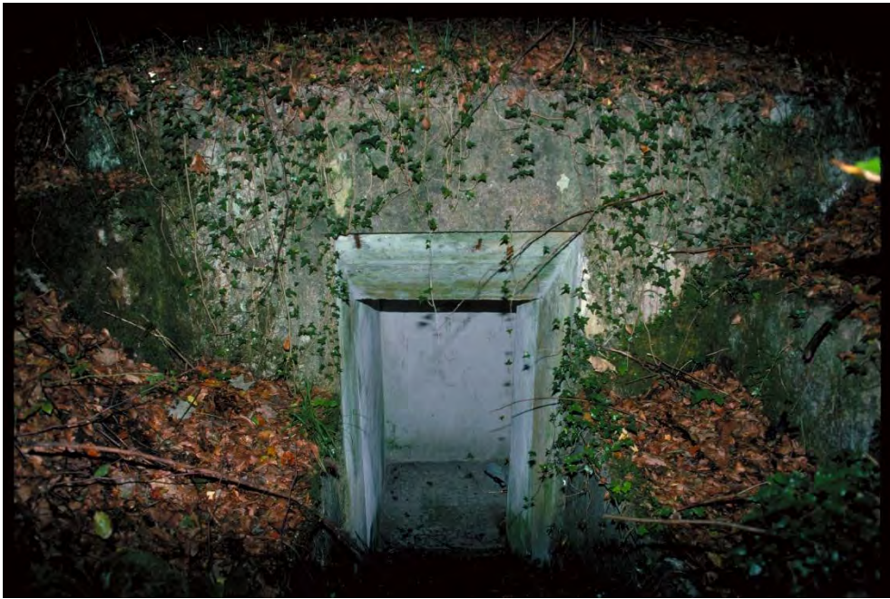
Sperrstelle 5082, Kleinunterstand A04911, 17.09.1996 (Bild Nr. D100538_64).
