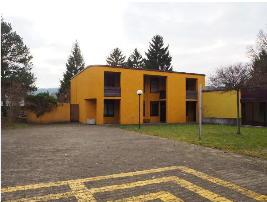
Oberstufenschulhaus Moosmatt, Abwartswohnhaus, Ansicht von NO, 11.01.2018 (Bild Nr. D100669_22)
