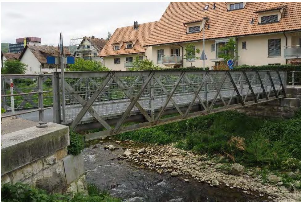
Vorstadtbrücke, Ansicht von NO, 13.06.2018 (Bild Nr. D101085_53)
