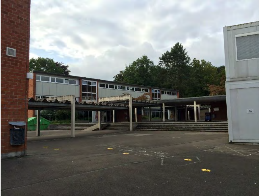
Primarschulanlage Wolfsmatt, Kleiner Schulhof, im Hintergrund Klassentrakt O (Vers. Nr. 02280), Ansicht von N, 05.08.2014 (Bild Nr. D100658_56)
