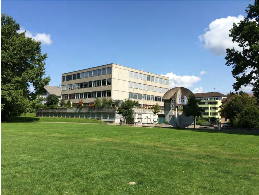
Gewerbeschulhaus, Ansicht von SO, 05.08.2014 (Bild Nr. D100658_40)
