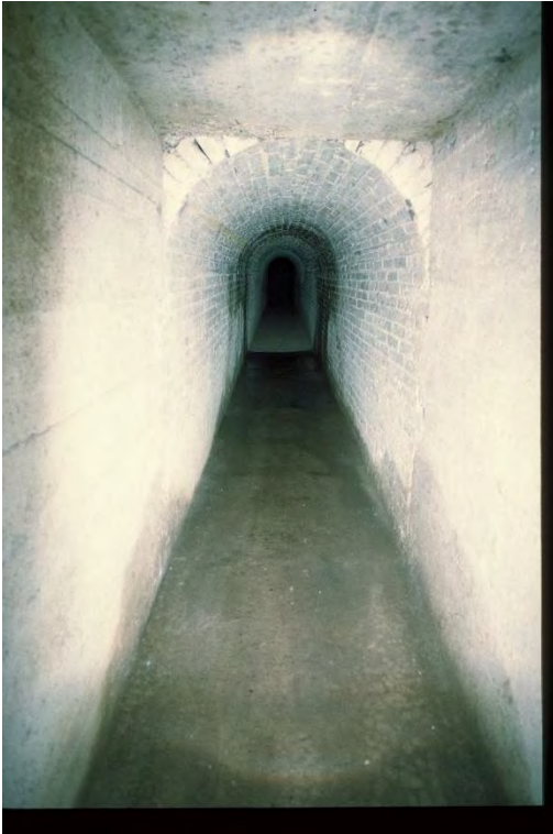
Sperrstelle 5053, Zugsunterstand A04930, 19.03.1998 (Bild Nr. D100538_80).
