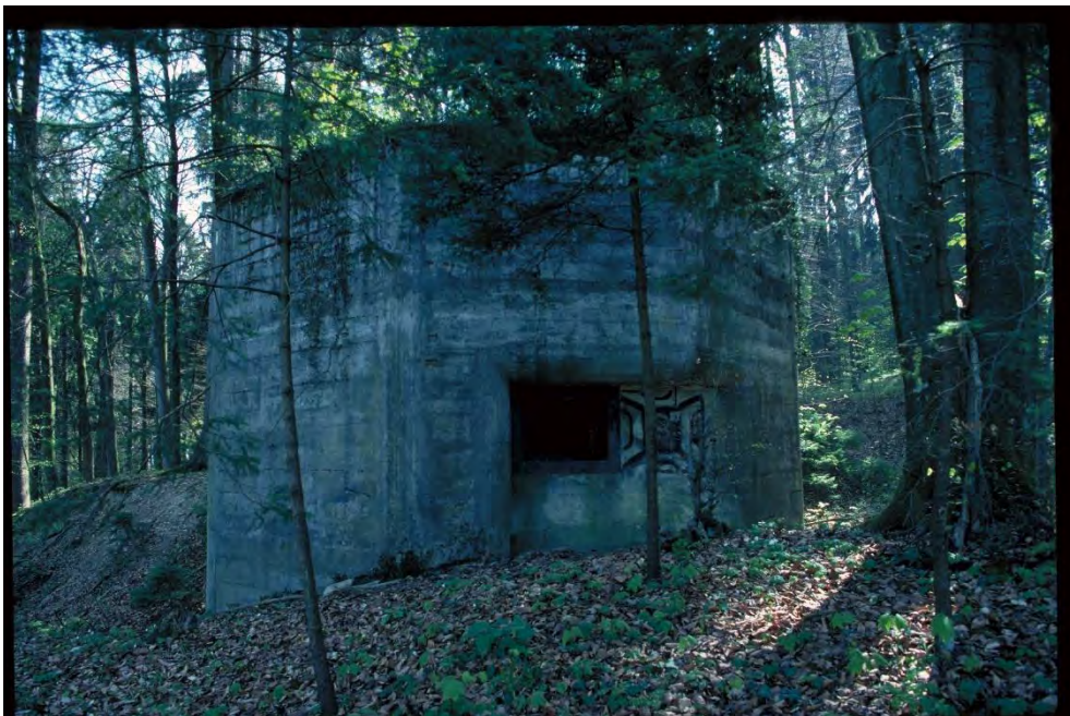
Sperrstelle 5048, Geschützstand A05222, 09.04.1997 (Bild Nr. D100538_55).
