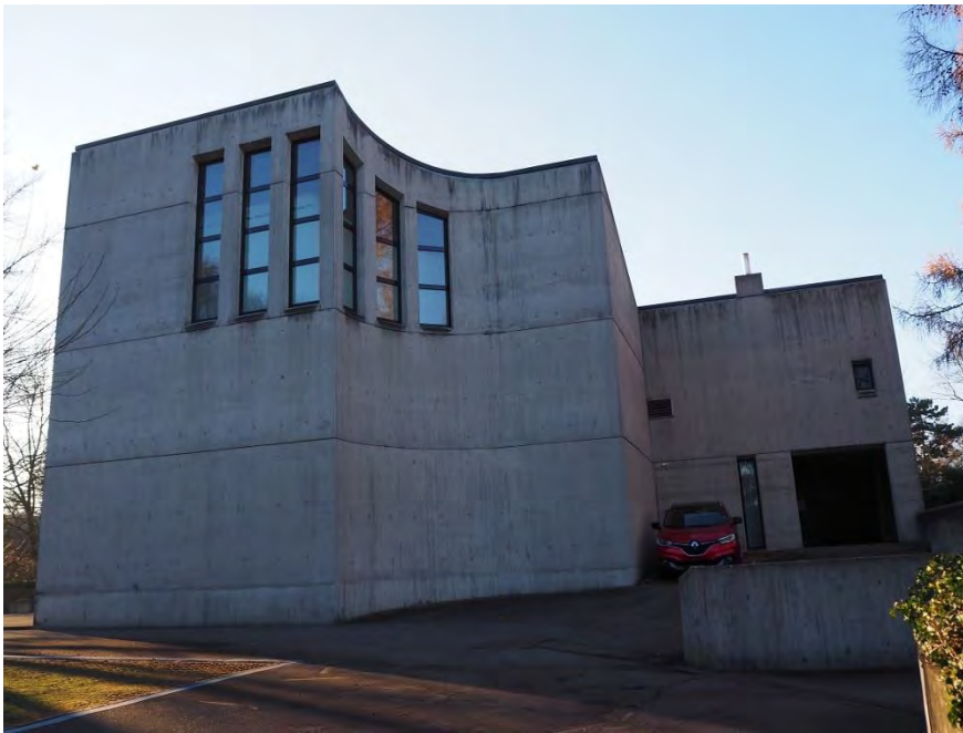
Abdankungshalle, Ansicht von NO, rechts die Zufahrt für den Leichenwagen, 11.12.2017 (Bild Nr. D100538_12)
