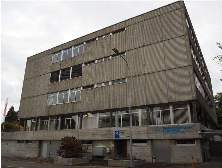
Gewerbeschulhaus, Ansicht von NO, 06.10.2017 (Bild Nr. D100668_26)
