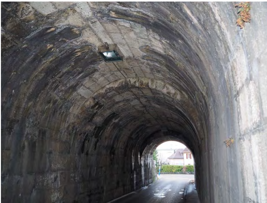
Unterführung Bahndamm, Tunnelgewölbe mit Abtreppung, 11.12.2017 (Bild Nr. D101141_45)
