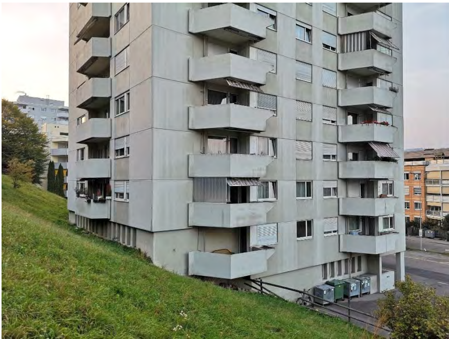
Überbauung «Halde», Hochhaus (Vers. Nr. 01559), Ansicht von SO, 20.10.2018 (Bild Nr. D101148_68)
