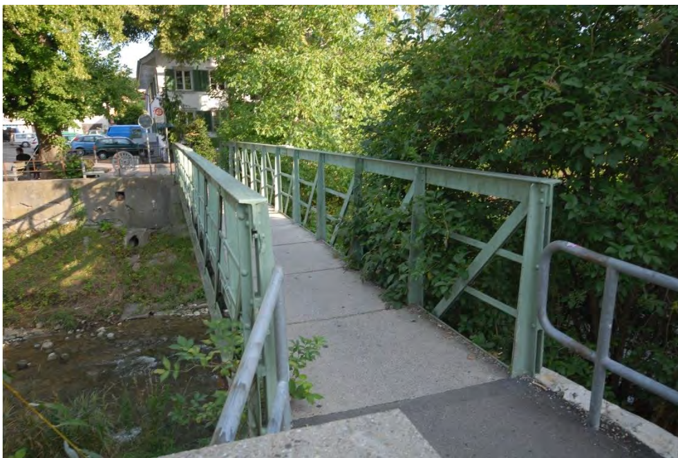
Fussgängersteg, Ansicht von NW, 13.06.2018 (Bild Nr. D101085_44)
