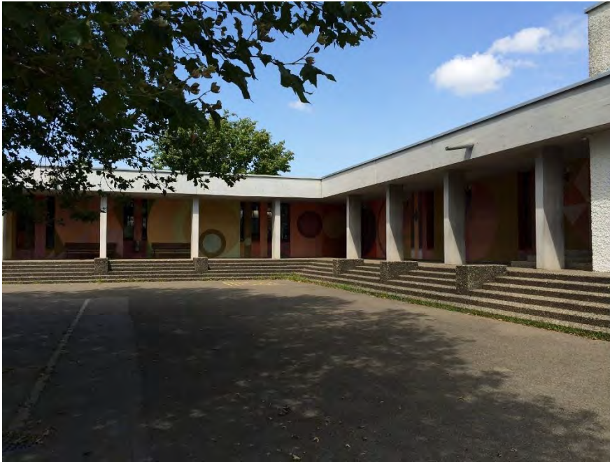
Primarschulanlage Fondli, Spezialtrakt (Vers. Nr. 02386), Ansicht von S, 05.08.2014 (Bild Nr. D100657_61)
