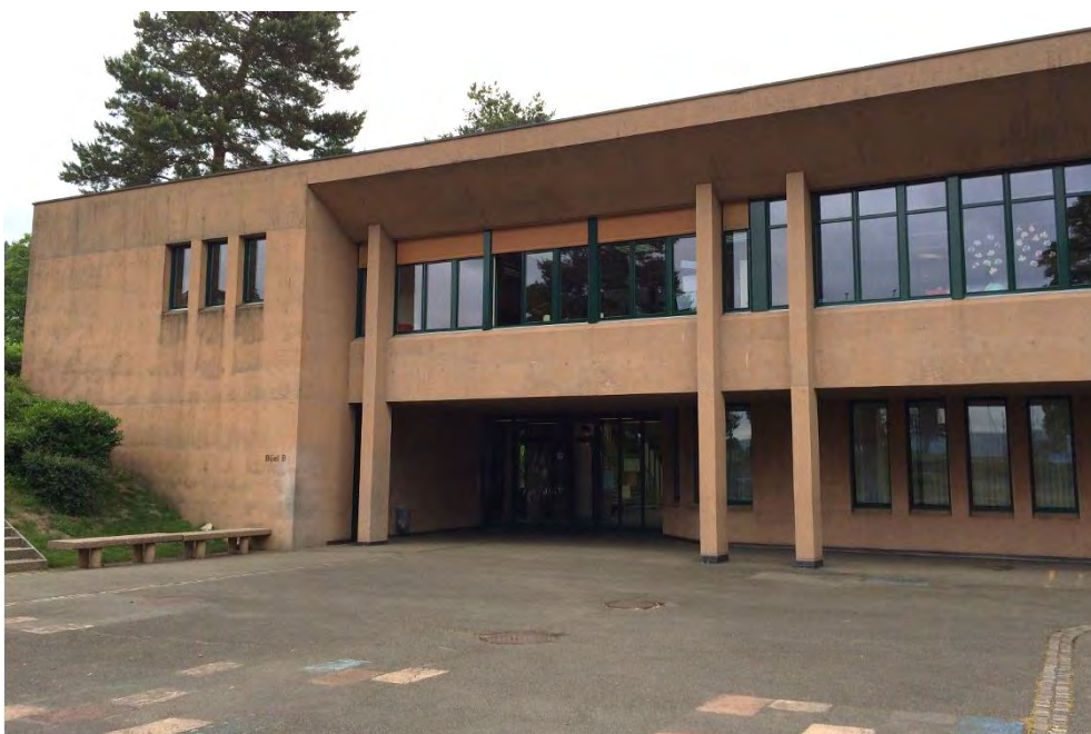
Schulhaus Büel B, Ansicht von W, 28.05.2014 (Bild Nr. D100661_06)
