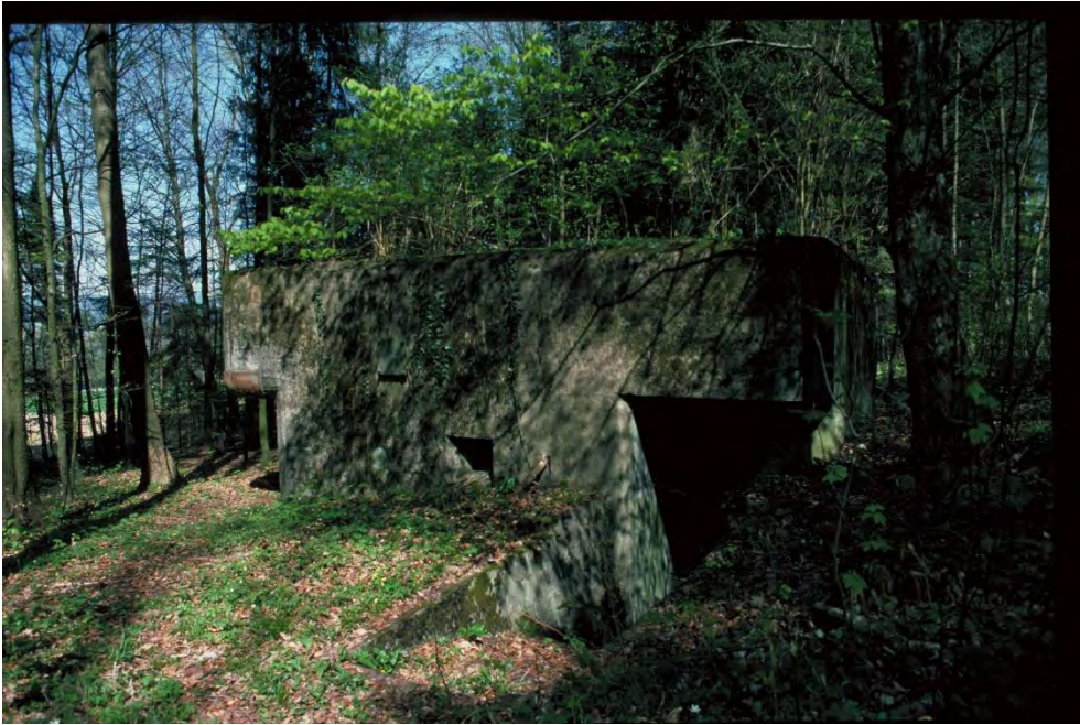
Sperrstelle 5048, Geschützstand A05224, 09.04.1997 (Bild Nr. D100538_57).
