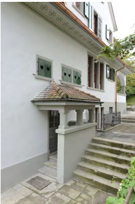
Kindergarten sog. «Nähhusli», Westfassade, Ansicht von NW, 21.08.2016 (Bild Nr. D101521_38)
