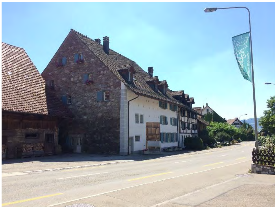
Weinbauernhaus mit Waschhaus, Weinbauernhaus (Vers. Nr. 00157), Ansicht von O, 08.08.2016 (Bild Nr. D100665_14)
