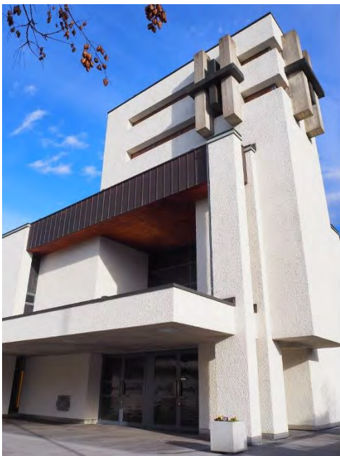
Kath. Kirche St. Josef, Kirche (Vers. Nr. 02466), Eingangsfassade mit Glockenträger, Ansicht von SO, 05.04.2018 (Bild Nr. D100592_03)
