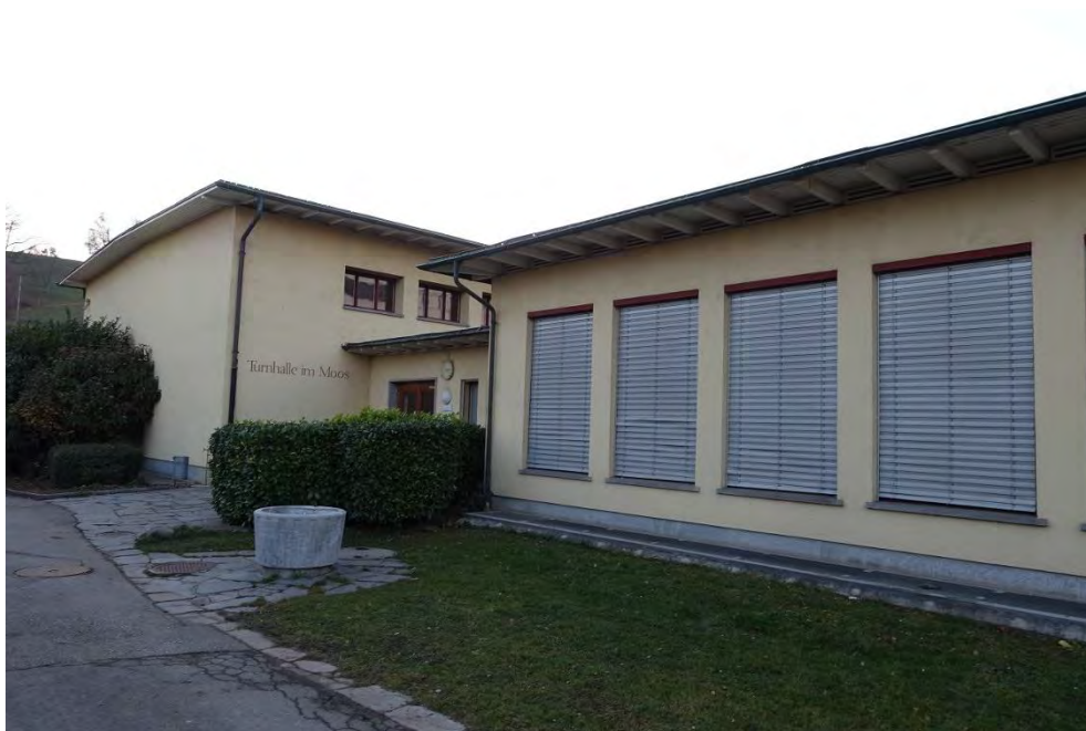
Turnhalle und Kindergarten Im Moos, Turnhalle- und Kindergartenbau (Vers. Nr. 01160) mit Brunnen (247BRUNNEN01160), Ansicht von NO, 08.12.2017 (Bild Nr. D101086_24)
