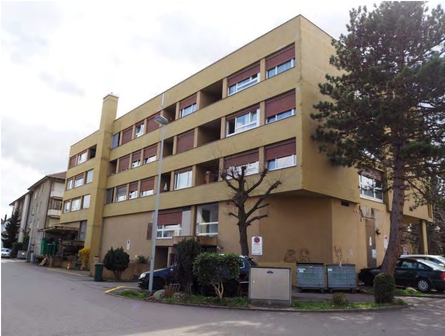
Wohn- und Geschäftshaus, Ansicht von NW, 05.04.2018 (Bild Nr. D100538_44)
