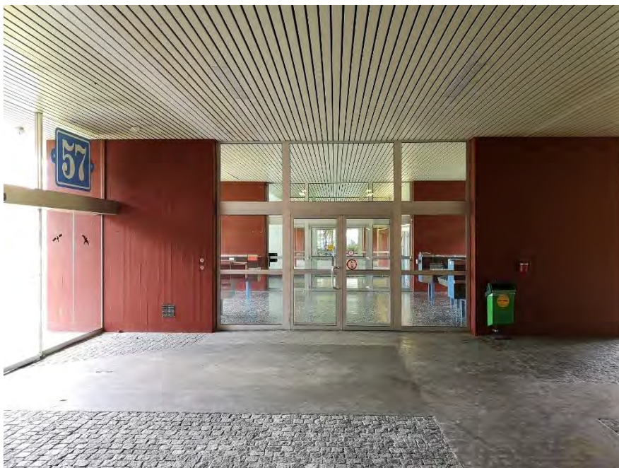
Scheibenhochhaus «Zelgli», Blick aus dem öffentlichen Durchgang im EG auf die Eingangshalle und den dahinterliegenden Erschliessungskern, 18.10.2018 (Bild Nr. D1011148_16)
