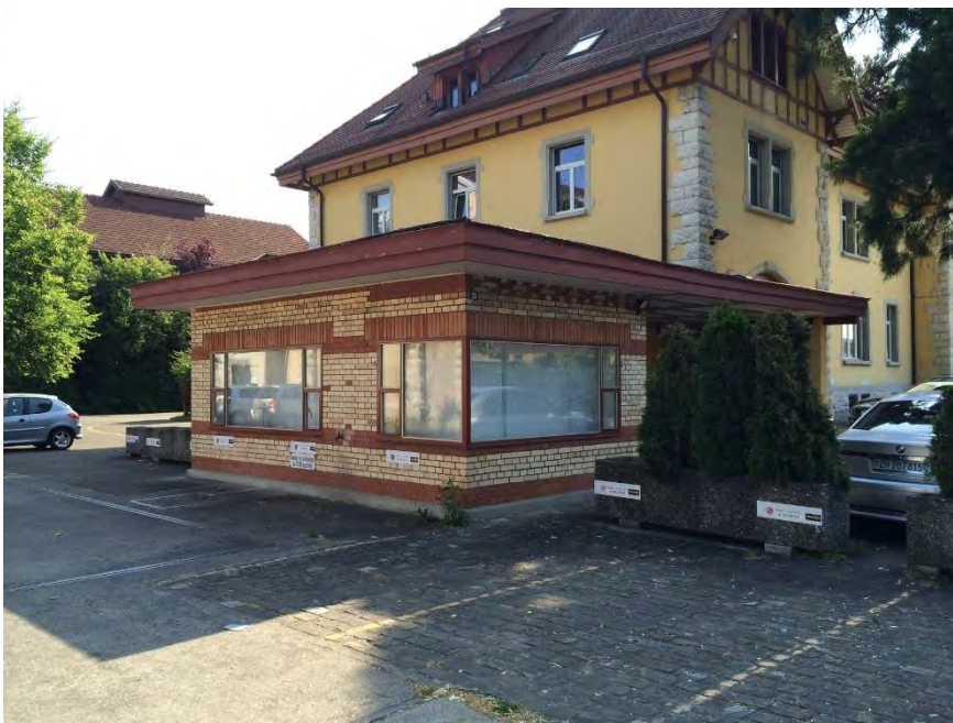
Gaswerkareal, Betriebsbauten, Ehem. Portierhaus (247BEI00439), Ansicht von SW, 10.06.2014 (Bild Nr. D101141_69)
