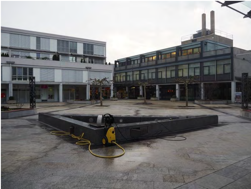
Gemeindezentrum, Dorfplatz (Vers. Nr. 00155) mit Wohn- und Geschäftshaus (Vers. Nr. 00250) und Gemeindehaus (Vers. Nr. 00154), Ansicht von NW, 11.01.2018 (Bild Nr. D101132_08)
