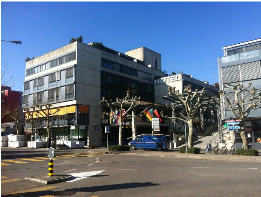
Gemeindezentrum, Hallenbad, Hotel und Restaurant (Vers. Nr. 00162), Ansicht von S, 03.03.2014 (Bild Nr. D100655_38)
