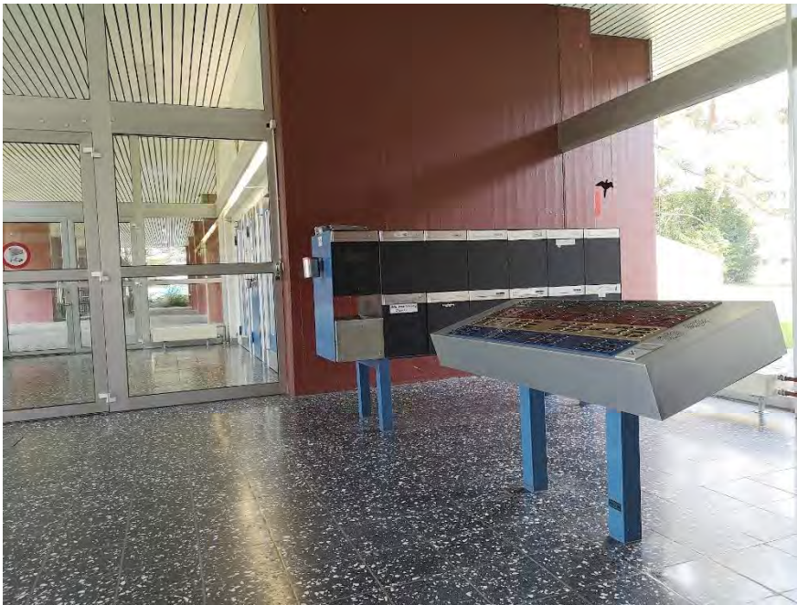
Scheibenhochhaus «Zelgli», Briefkasten- und Klingelanlage in der Eingangshalle, 18.10.2018 (Bild Nr. D1011148_17)
