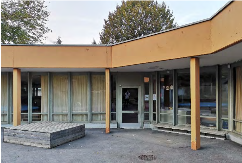
Überbauung «Halde», Kindergarten (Vers. Nr. 01560), Nordfassade, zentraler Bereich und Eingang zum westlichen Kindergarten, 20.10.2018 (Bild Nr. D101148_59)
