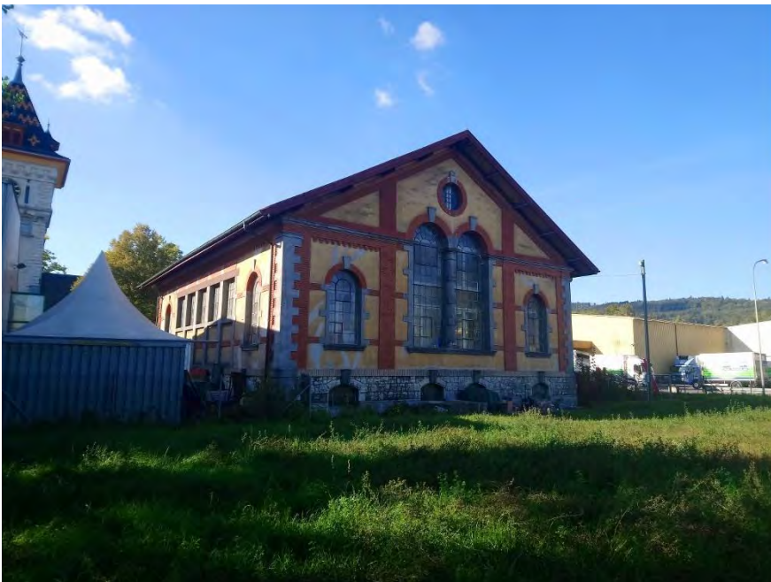
Gaswerkareal, Betriebsbauten, Ehem. Uhren- und Reglerhaus (Vers. Nr. 00340), Ansicht von SO, 07.10.2018 (Bild Nr. D101141_62)
