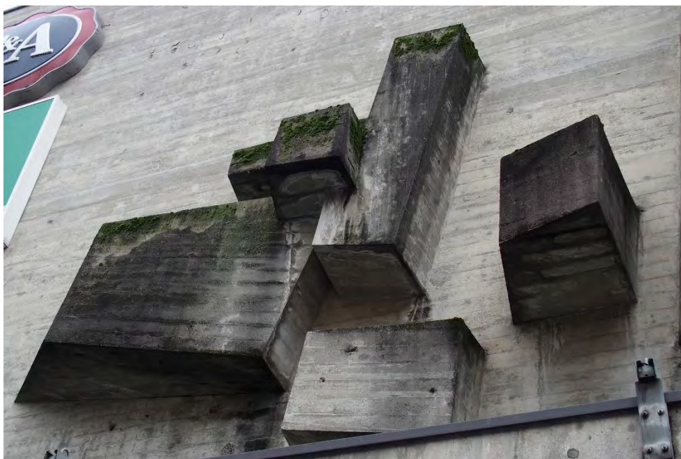
Kaufhaus «Regina», Fassadenrelief, Detail Nordostfassade, 06.10.2017 (Bild Nr. D100668_52)
