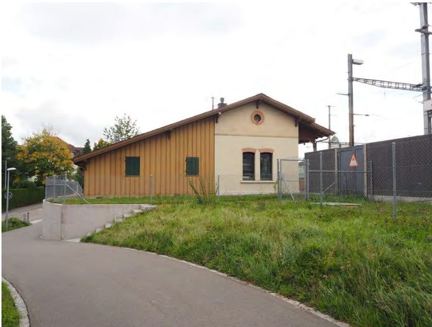
Stationsgebäude, Ansicht von N, 06.10.2017 (Bild Nr. D100668_32)
