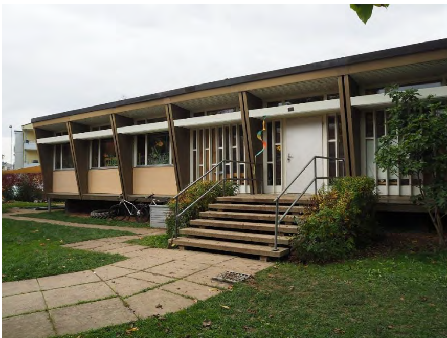
Kindergarten Wolfsmatt, Ansicht von SO, 06.10.2017 (Bild Nr. D101085_11)
