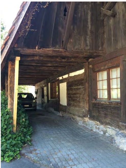
Vielzweckbauernhaus, Ehem. Schopfteil, Ansicht von SW, 08.08.2016 (Bild Nr. D101085_03)
