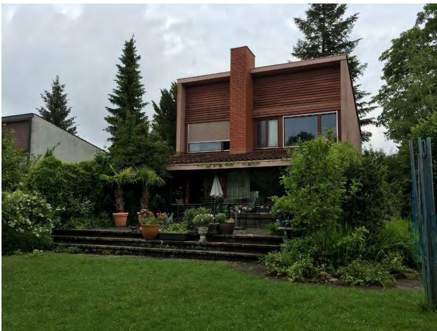
Wohnhausgruppe Windhalb, Wohnhaus Nr. 136 (Vers. Nr. 01939), Ansicht von W, 26.05.2015 (Bild Nr. D100662_27)
