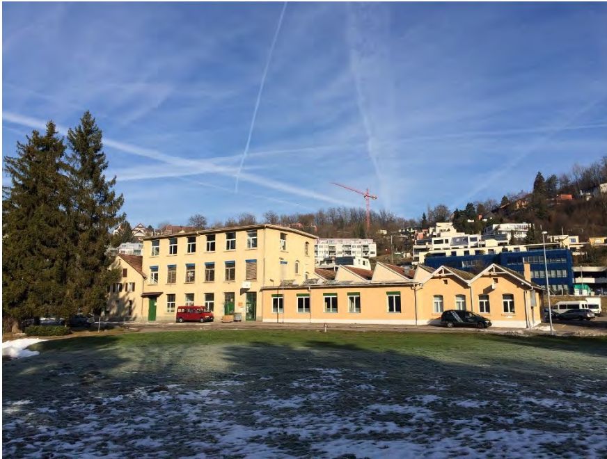
Ehem. Glühlampenfabrik, Shedhalle mit Wohnhaus und Betriebsgebäuden (Vers. Nr. 00351), Ansicht von S, 06.01.2015 (Bild Nr. D100657_27)
