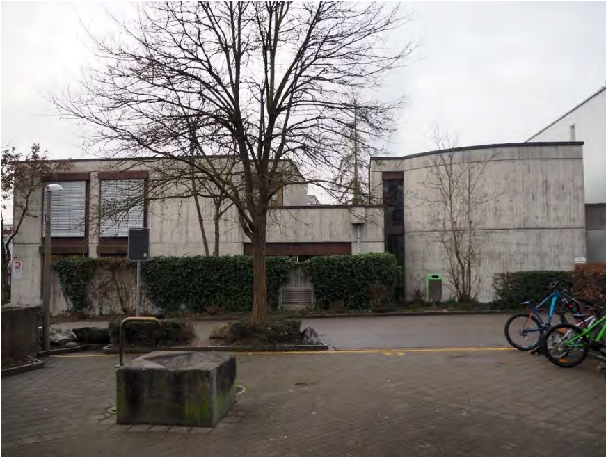
Gemeindezentrum, Reformiertes Kirchenzentrum (Vers. Nr. 00158), Ansicht von N, 11.01.2018 (Bild Nr. D101132_23)
