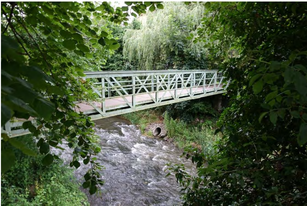
Fussgängersteg, Ansicht von O, 13.06.2018 (Bild Nr. D101085_43)
