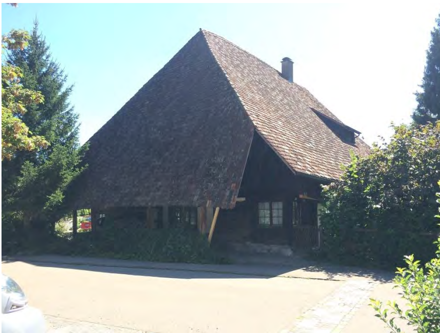
Vielzweckbauernhaus, Ansicht von W, 08.08.2016 (Bild Nr. D101085_01)
