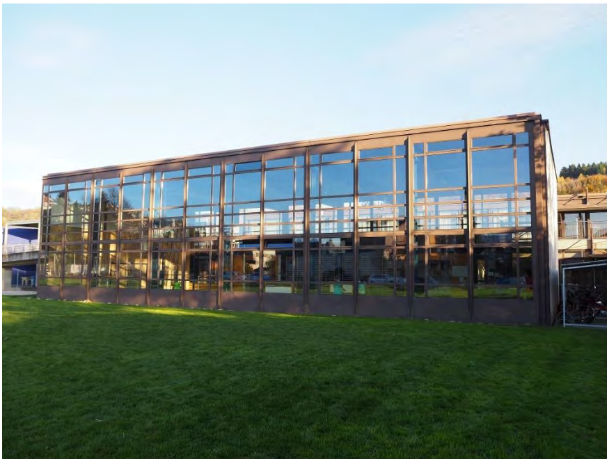
Oberstufenschulanlage Brüelmann, Turnhallentrakt, Ansicht von W, 31.10.2017 (Bild Nr. D101131_41)
