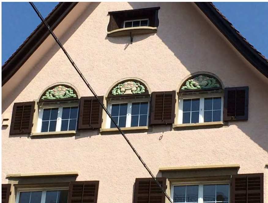
Angestelltenwohnhäuser, Ansicht von S, 12.06.2014 (Bild Nr. D100538_35)
