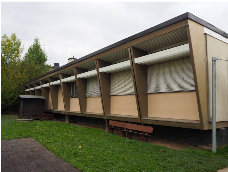
Kindergarten Wolfsmatt, Ansicht von NW, 06.10.2017 (Bild Nr. D101085_10)
