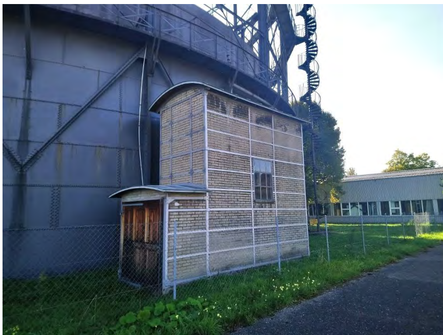
Gaswerkareal, Betriebsbauten, Heizhäuschen Nord (247BEI00351), Ansicht von NO, 07.10.2018 (Bild Nr. D101141_52)
