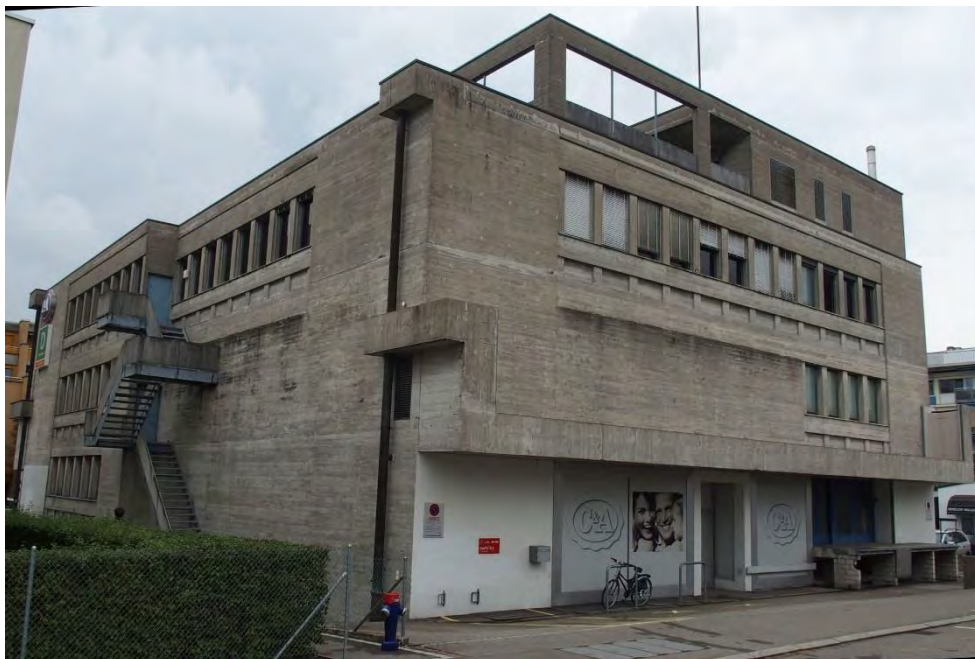
Kaufhaus «Regina», Ansicht von SW, 06.10.2017 (Bild Nr. D100668_54)
