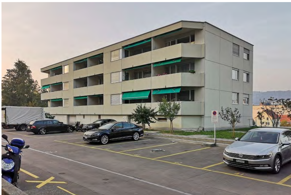
Überbauung «Halde», Laubenganghaus (Vers. Nr. 01550), Ansicht von SO, 20.10.2018 (Bild Nr. D101148_41)
