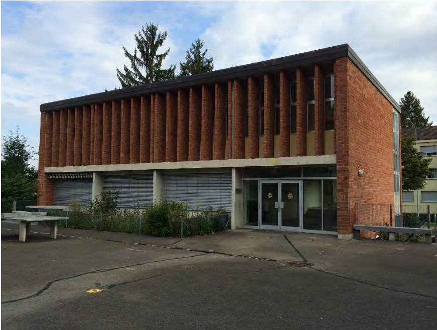
Primarschulanlage Wolfsmatt, Singaaltrakt (Vers. Nr. 02284), Ansicht von S, 05.08.2014 (Bild Nr. D100658_67)
