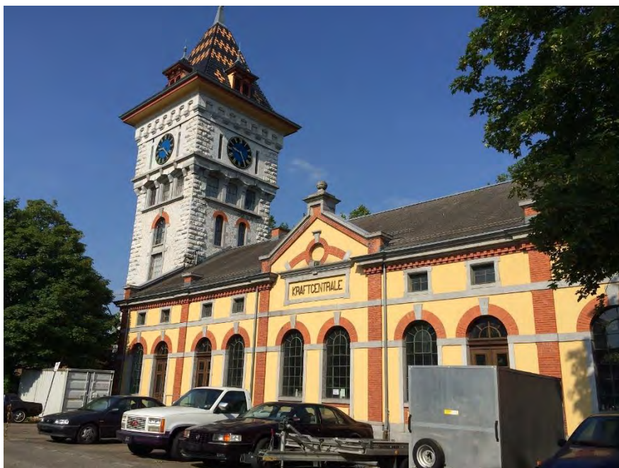
Gaswerkareal, Betriebsbauten, Ehem. Kraftzentrale mit Wasserturm (Vers. Nr. 00338), Ansicht von O, 13.06.2014 (Bild Nr. D101141_55)
