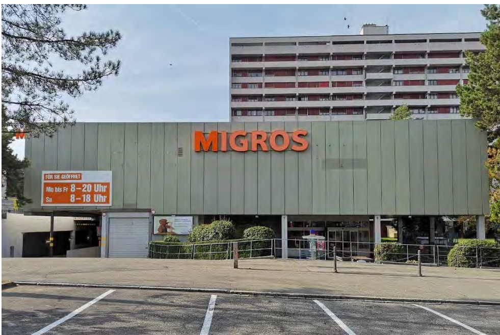
Scheibenhochhaus «Zelgli», Ansicht von O, im Vg. das Ladenzentrum (Vers. Nr. 01421, östlicher Teil), 18.10.2018 (Bild Nr. D1011148_13)
