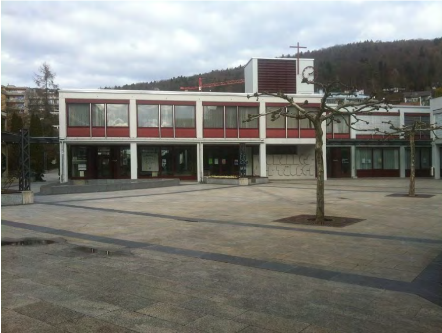
Gemeindezentrum, Katholische Kirche St. Johannes (Vers. Nr. 00157), Ansicht von SW, 03.03.2014 (Bild Nr. D100655_44)
