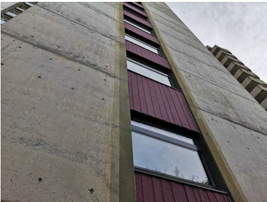
Wohnhochhäuser, Block I (Vers. Nr. 01692), Detail Fassadengestaltung, 31.10.2018 (Bild Nr. D101149_46)
