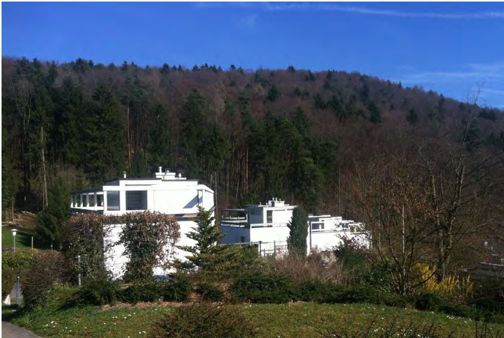
Wohnhäuser im Büel, Ansicht von W , 20.03.2014 (Bild Nr. D100662_79)
