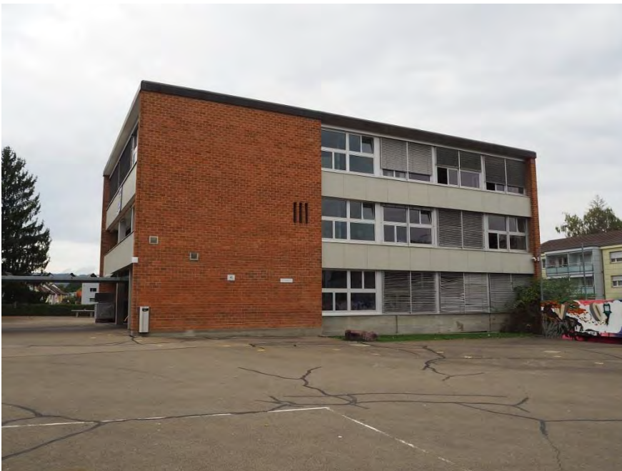
Primarschulanlage Wolfsmatt, Spezialraumtrakt (Vers. Nr. 02280), Ansicht von O, 06.10.2017 (Bild Nr. D100668_76)
