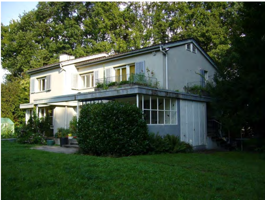
Haus Korkstein AG, Ansicht von O, 31.08.2011 (Bild Nr. D101131_22)
