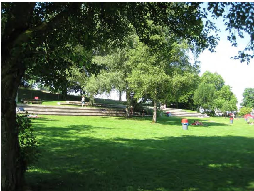
Freibad Zwischen den Hölzern, Freibadgestaltung, Stufenbänder aus Beton, Ansicht von NO, 05.08.2015 (Bild Nr. D100665_70)
