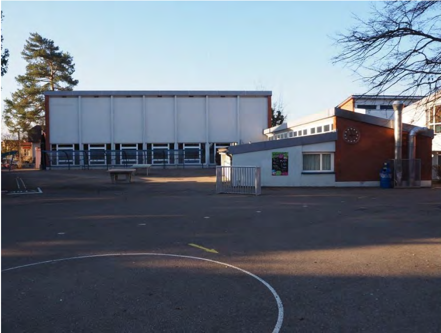
Primarschulanlage Hofacker, Turnhallentrakt (Vers. Nr. 1252), Ansicht von SO, 07.12.2017 (Bild Nr. D101131_64)
