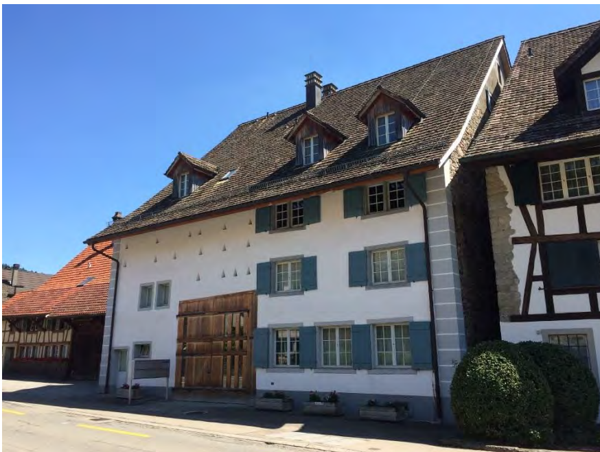
Weinbauernhaus mit Waschhaus, Weinbauernhaus (Vers. Nr. 00157), Ansicht von N, 08.08.2016 (Bild Nr. D100665_10)
