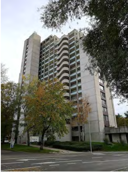
Wohnhochhäuser, Block I (Vers. Nr. 01692), Ansicht von NW, 31.10.2018 (Bild Nr. D101149_32)
