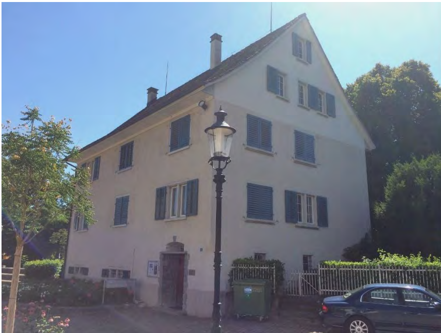
Ehem. Pfarrhaus mit Waschhaus, Ehem. Pfarrhaus (Vers. Nr. 00292), Ansicht von W, 08.08.2016 (Bild Nr. D1000677_21)
