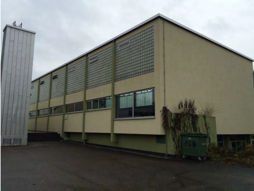
Schulhaus Reppisch, Mehrzweckgebäude, Ansicht von N, 08.12.2014 (Bild Nr. D100657_09)
