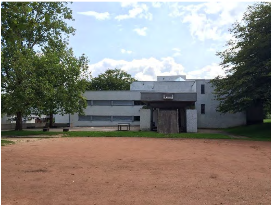
Primarschulanlage Fondli, Klassenzimmertrakt 2 (Vers. Nr. 02385), Ansicht von NW, 05.08.2014 (Bild Nr. D100657_72)
