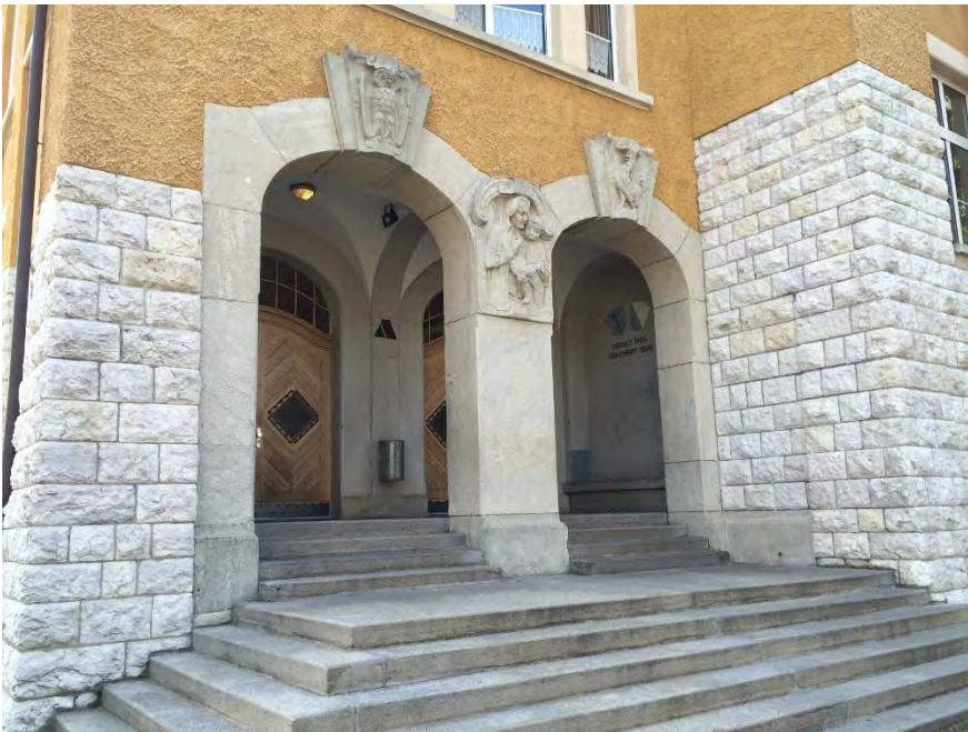
Zentralschulanlage, Schulhaus I (243ZUSA01505), Ansicht von NW, Detail Eingang, 05.08.2014 (Bild Nr. D100658_81)
