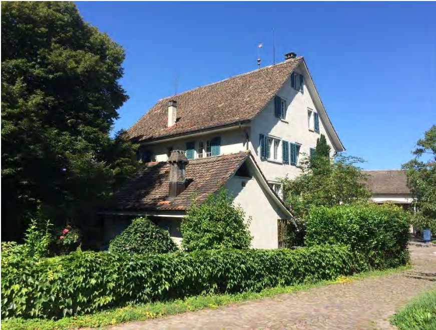
Ehem. Pfarrhaus mit Waschhaus, Ansicht von SO, 08.08.2016 (Bild Nr. D1000677_23)
