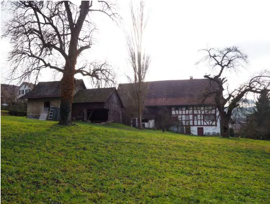
Vielzweckbauernhaus mit ehem. Waschhaus, Ansicht von NO, 11.01.2018 (Bild Nr. D101087_06)
