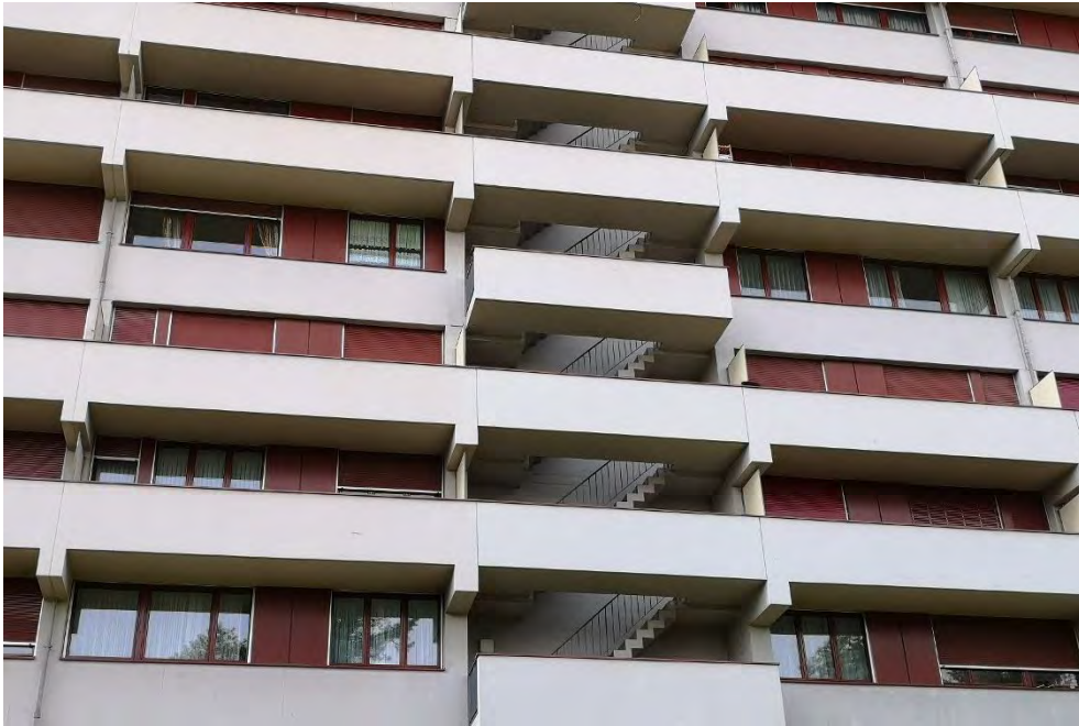
Scheibenhochhaus «Zelgli», Ostfassade, in der M. der Erschliessungstrakt mit offener Fluchttreppenanlage (Detail), 18.10.2018 (Bild Nr. D1011148_14)
