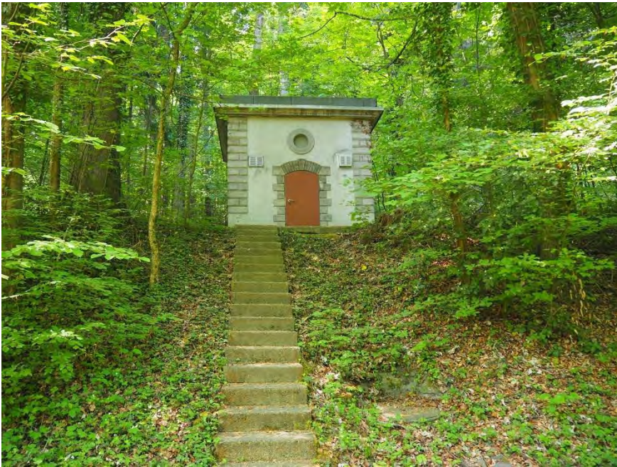
Reservoirensemble Lölmoos, Reservoir und Schieberhaus Lölmoos 1 (247Reservoir00001), Ansicht von NO, 08.05.2018 (Bild Nr. D100677_15)
