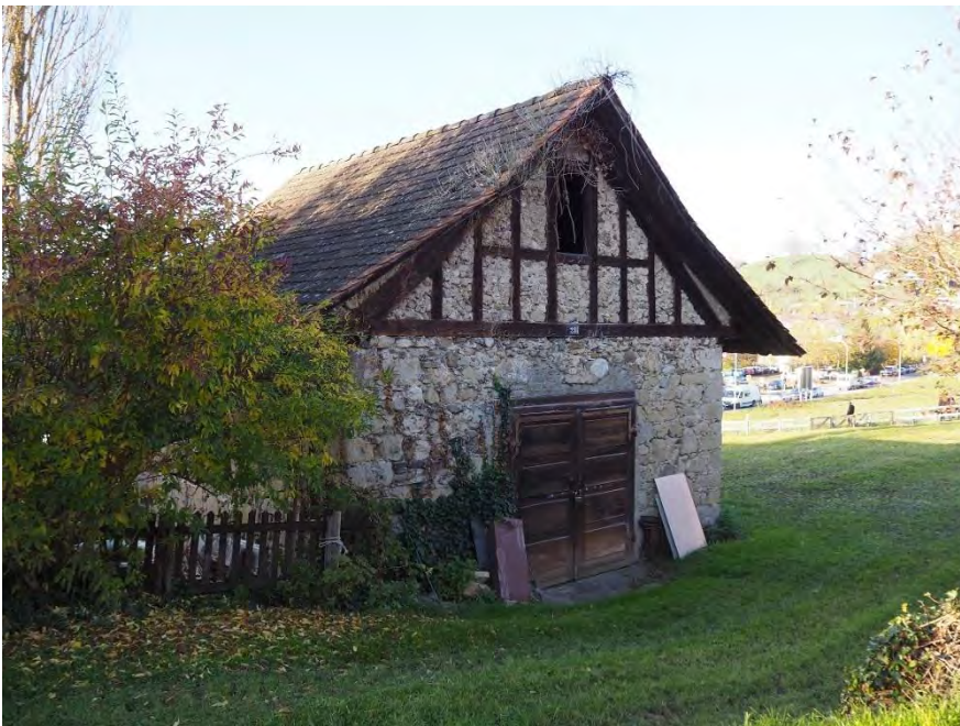
Vielzweckbauernhaus mit ehem. Waschhaus, ehem. Waschhaus (Vers. Nr. 00281), Ansicht von SO, 31.10.2017 (Bild Nr. D101087_01)
