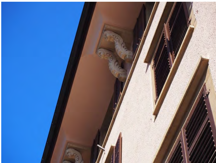
Angestelltenwohnhäuser, Ansicht von S, 12.06.2014 (Bild Nr. D100538_36)
