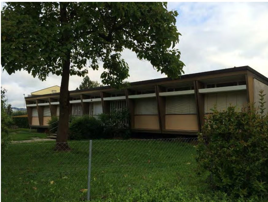
Kindergarten Wolfsmatt, Ansicht von SO, 05.08.2014 (Bild Nr. D100658_24)
