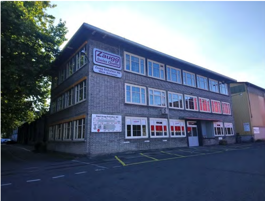
Gaswerkareal, Betriebsbauten, Kopfbau Werkstattgebäude (247ALT01053), Ansicht von NO, 07.10.2018 (Bild Nr. D101141_84)
