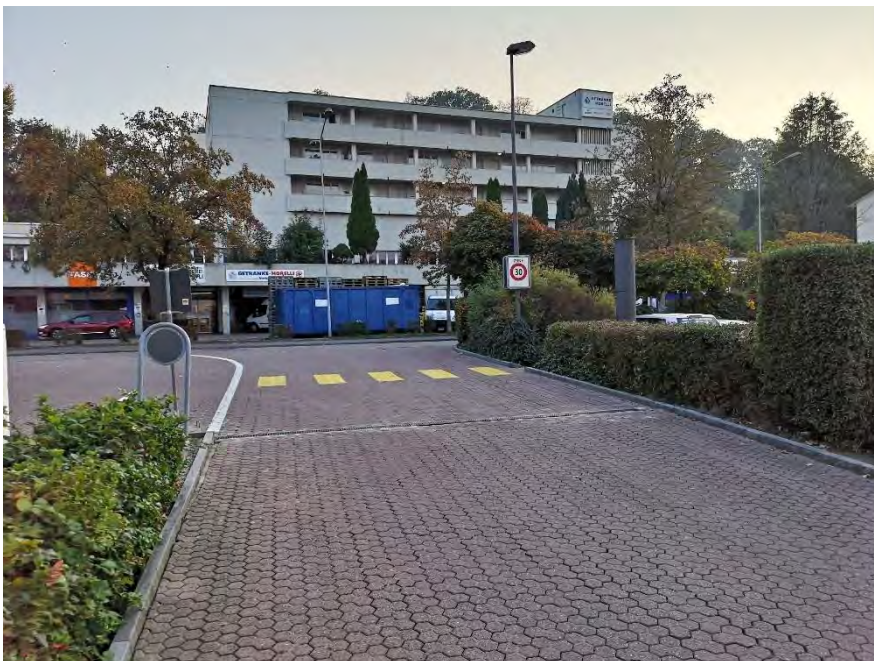
Überbauung «Halde», Laubenganghaus (Vers. Nr. 01550), Ansicht von N, 20.10.2018 (Bild Nr. D101148_31)
