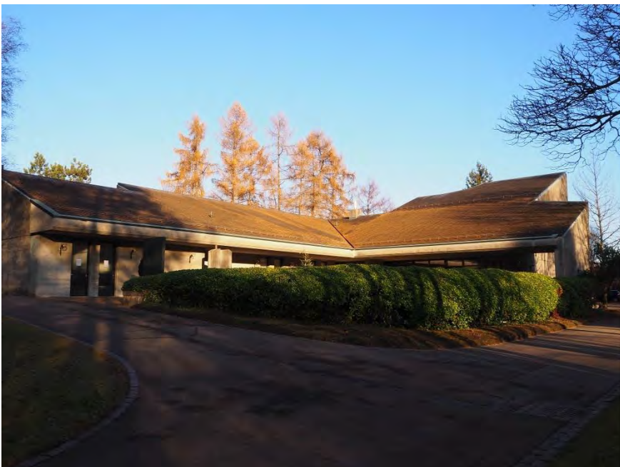
Abdankungshalle, Ansicht von SW, 01.01.2015 (Bild Nr. D100538_16)
