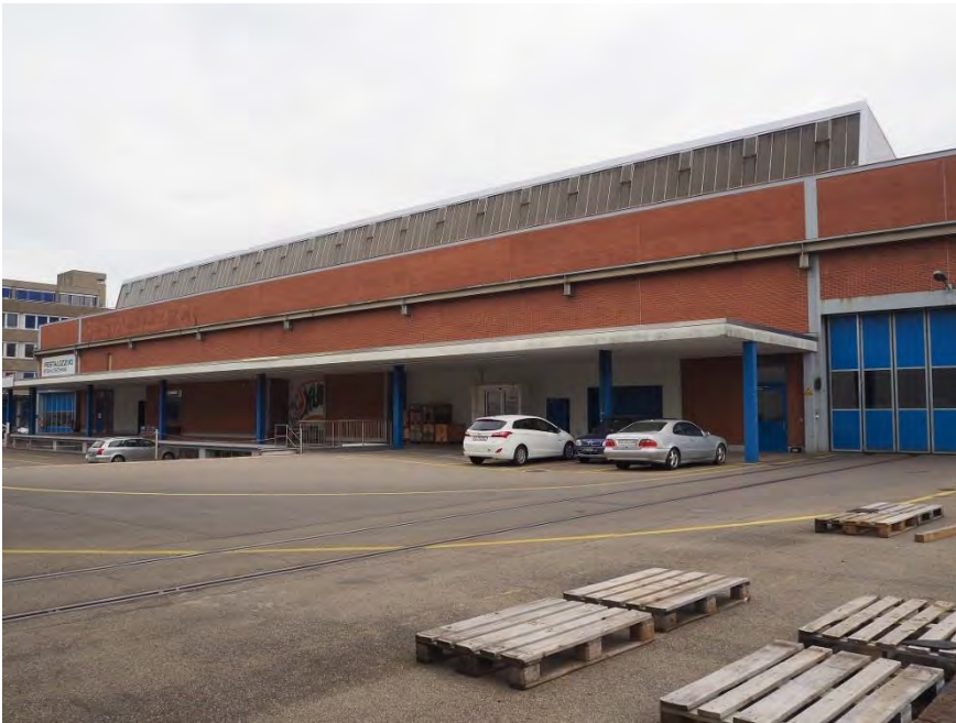
Lagerhaus Pestalozzi & Co., Ansicht von W, 04.04.2018 (Bild Nr. D101618_05)
