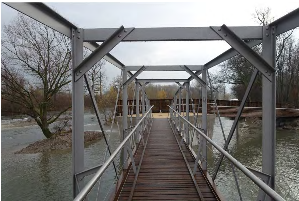
Reppischbrücke, Unterlauf (Mündung in Limmat), Detail, 06.12.2018 (Bild Nr. D101093_01)
