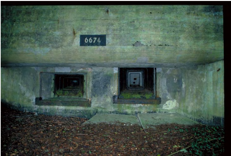
Sperrstelle 5050, Geschützstand A05204, 23.09.1997 (Bild Nr. D100538_89).
