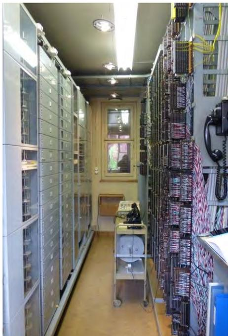
Telefonzentrale, Telefonautomat Rotary 7D3, 17.05.2016 (Bild Nr. D101061\_57).
